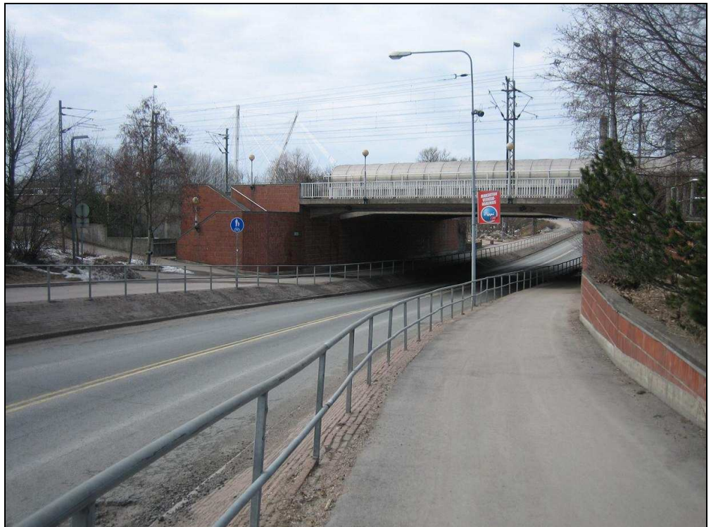
Kuva 8. Tulviva vesi ohjautuu rautatien alikulkuun Tikkurilantiellä.
