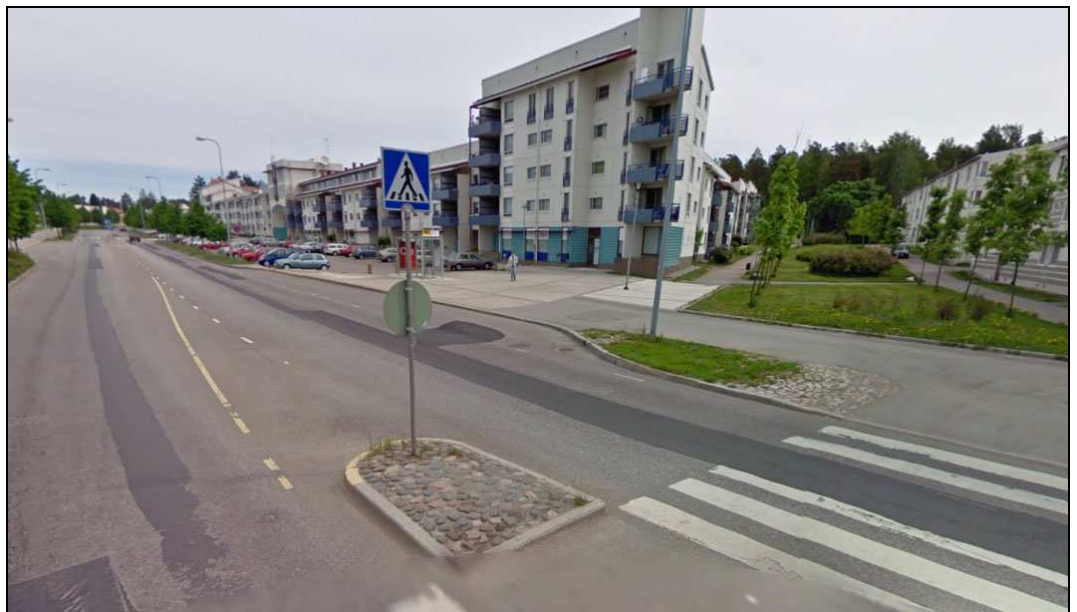
Kuva 18. Risteysaluetta, jonne hulevedet tulvalla lammikoituvat.
