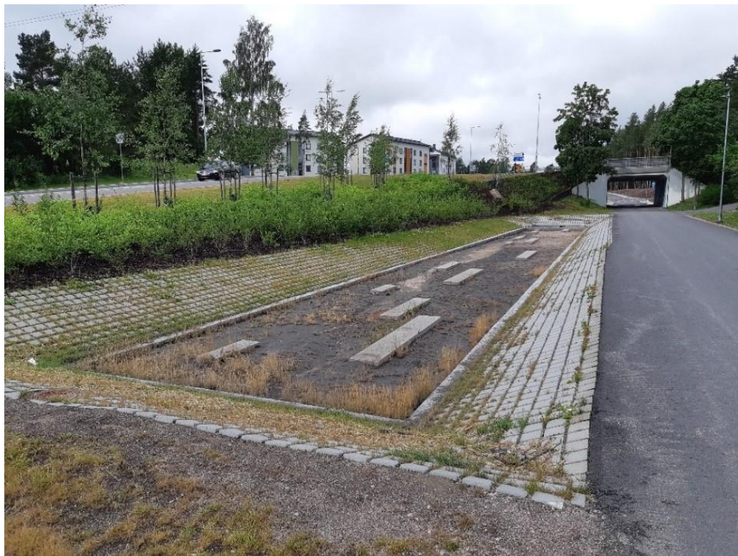
Kuva 51. Länsimäentien hulevesiä viivytetään ja suodatetaan hulevesirakenteessa
