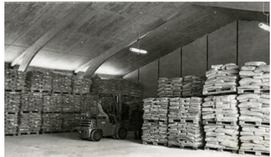
Joен eteläpuolelle rakennettiin uusia raaka-ainevarastoja. Valokuvat vuodelta 1956 ja 1965 Tikkurila Oyj.
