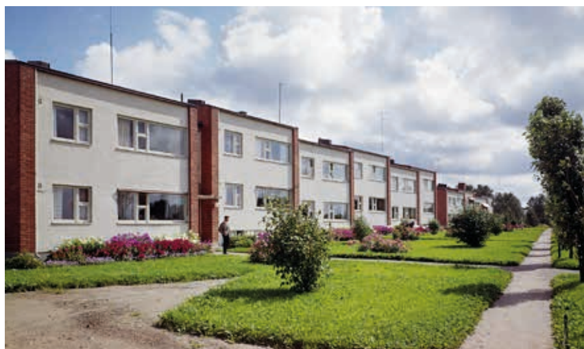
Yhtiön pääkonttorin ja henkilökunnan rivitalojen julkisivuja on jäsennetty puhtaaksi muurattuilla tiilipinnoilla. Valokuvat vuodelta 1960, rivitalojen kuva Pietilä ja päärakennuksen kuvaaja tuntematon. Tikkurila Oyj.
