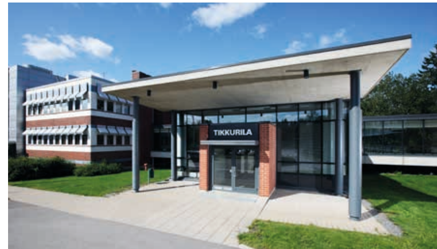
Arkkitehtuuritoimisto Ilonen & Lautamo Ky:n suunnittelema Sävytyspastatehdas Colorado ja vuonna 2004 valmistunut pääkonttorin vastaanottokeskus. Kuvat P. Forsgård 1996 ja K. Harkoma 2004, Tikkurila Oyj.
