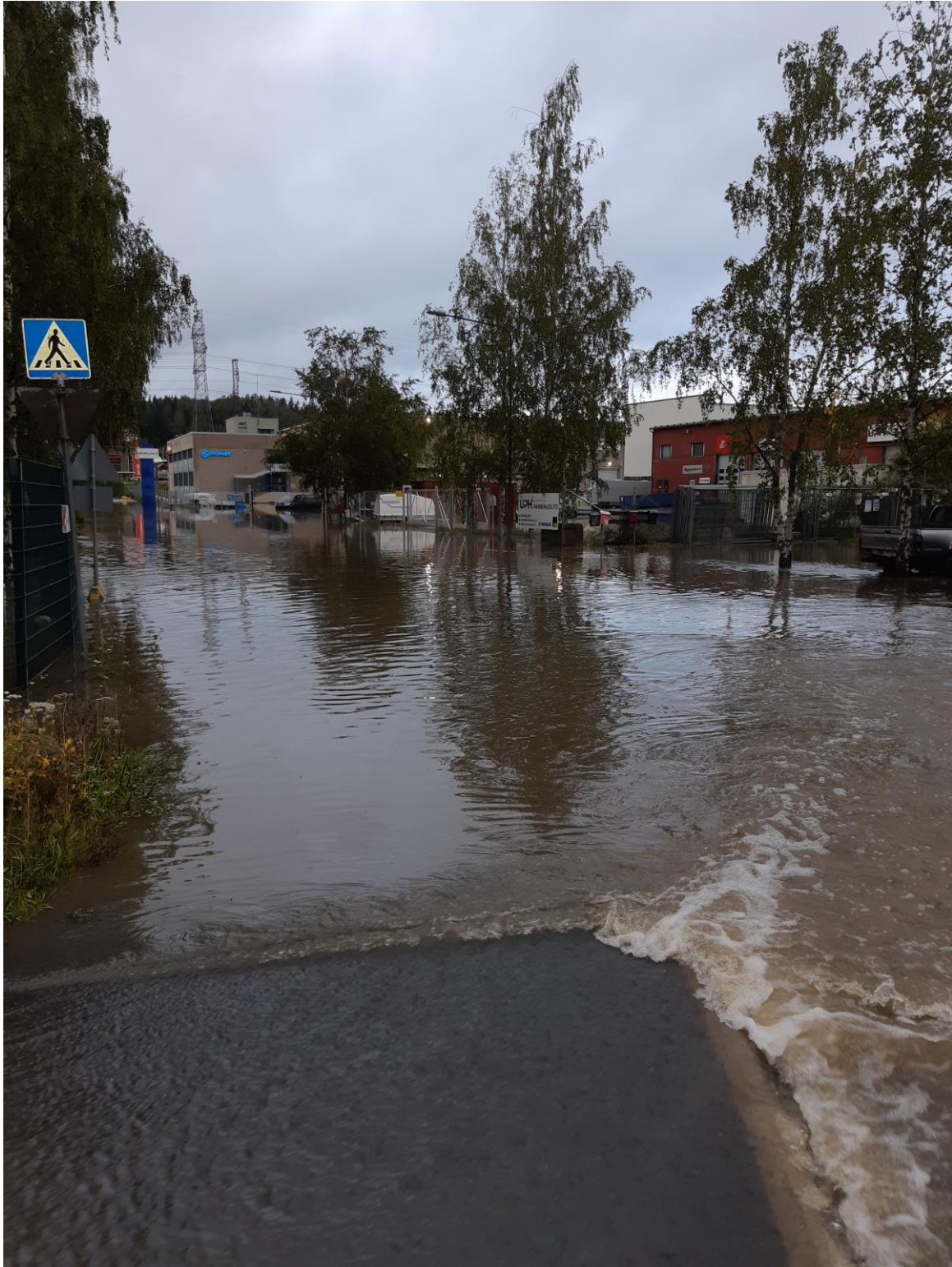
Kuva 14. Varistonojan tulviminen Vantaan Variston teollisuusalueella. (Vantaan kaupunki)
