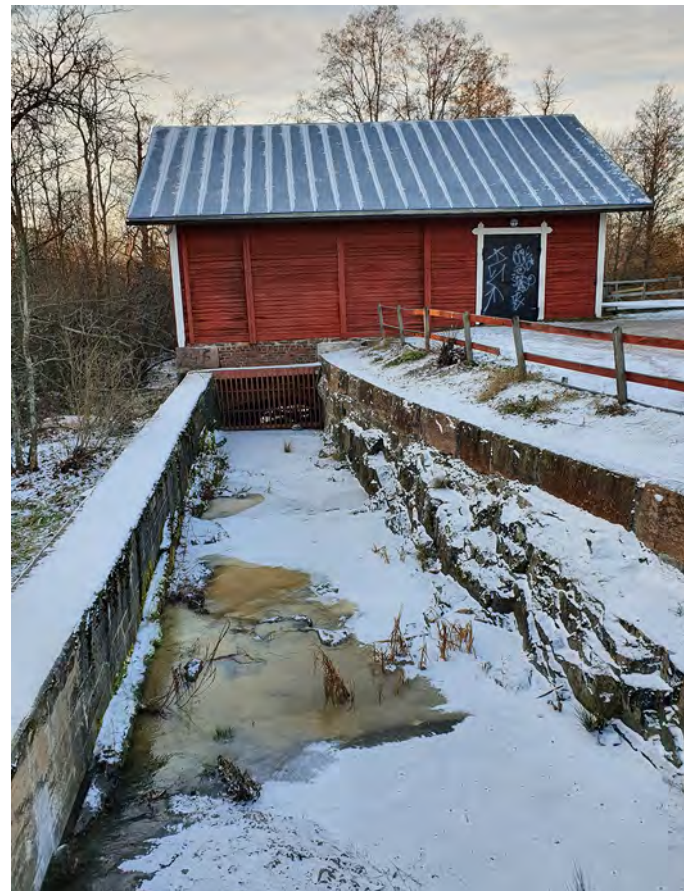
Kuva 8. Kirkonkylänkosken mylly ja myllyränni, joka ohjaa vettä myllyyn. Kuva Hanna Keskinen / Ramboll Finland.
