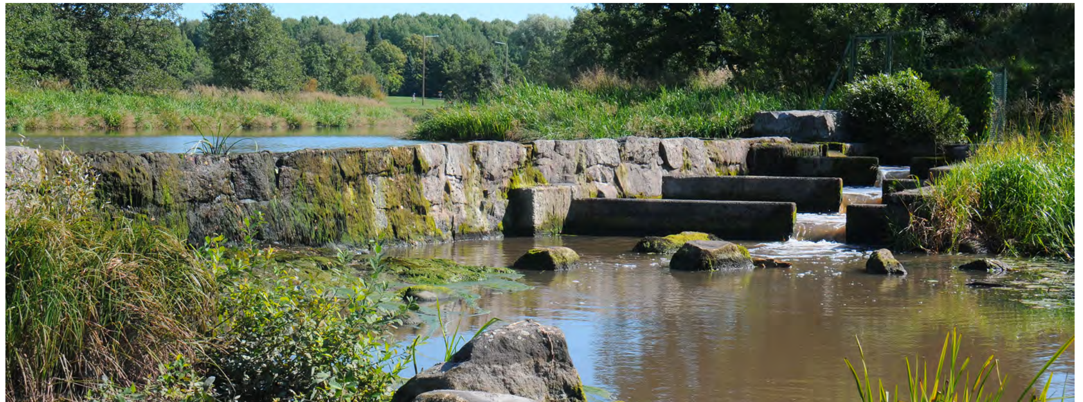
Kuva 10. Kirkonkylänkosken pato sekä oikealla etelärannan tuntumaan rakennettu kalaporras. Kuva: Otso Lintinen / Ramboll Finland
