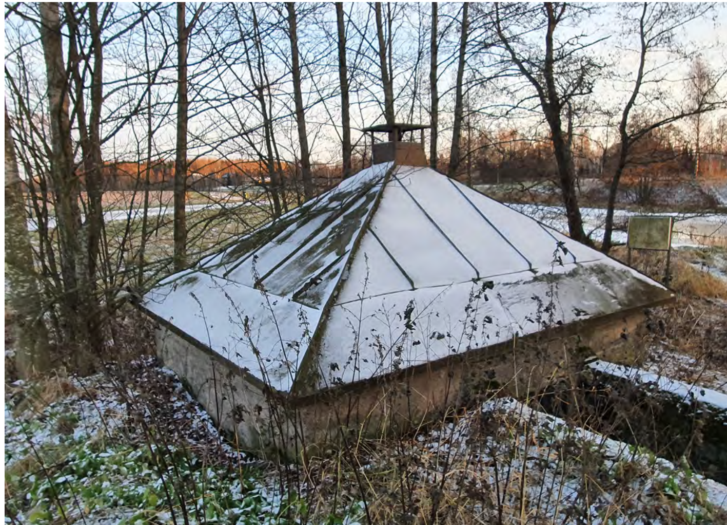
Kuva 12. Pumppuhuone. Kuva Hanna Keskinen / Ramboll Finland
