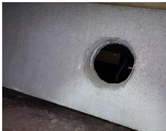
Kuva 9. D-linjan perustuspalkissa on rei'ityksiä joiden kautta A-D alueen alapohjan tuuletus tehostuu.
