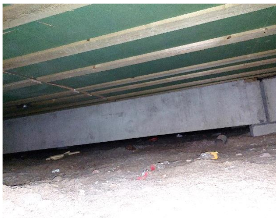
Kuva 8. Alapohjatilan tuuletus on järjestetty perustuspalkkien alta sekä palkkeihin porattujen reikien kautta.
