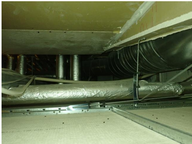
4. Pölyä ja likaa silminnähdessä havaittavissa putkien ja kattopalojen pinnalla.
