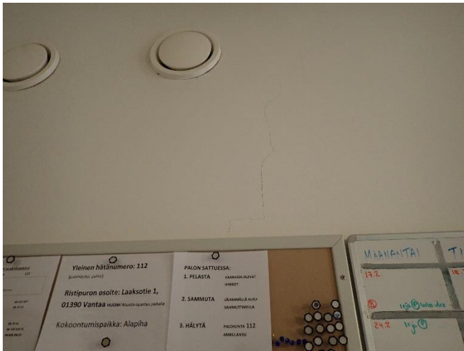
Kuva 31. Väliseinän halkeama
