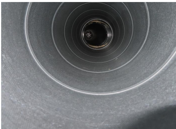
Kuva 27. IV-koneen TK01 tuloilmakanava, ryhmähuone 106. Sisäpinnan pölykertymäarvio oli alle 1 g/m 2 (arviointipiste KP1).
