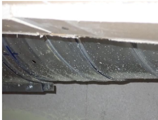
4. Pölyä ja likaa silminnähdessä havaittavissa putkien ja kattopalojen pinnalla.
