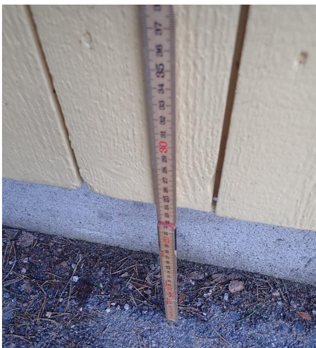
Kuva 8. Puutteellinen sokkelikorkeus
