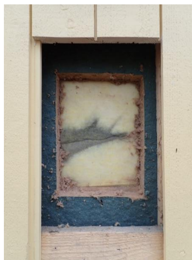
Kuva 16 Värimuunnoksia mineraalivillassa
