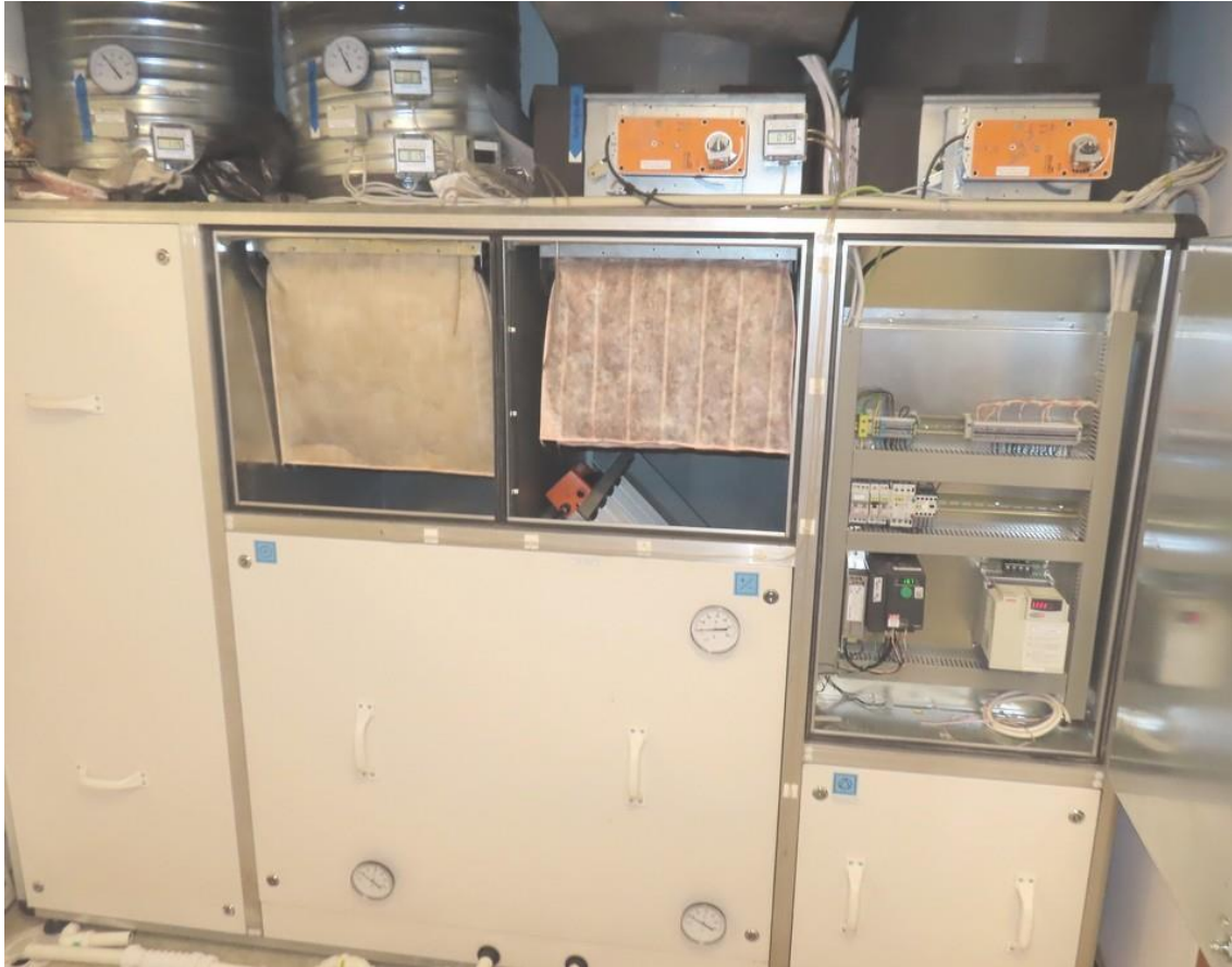
Kuva 25. Tuloilmasuodatin oli F7-tasoinen ja poistoilmasuodatin oli M6-tasoinen. Suodattimien kehykset olivat tiiviit.
