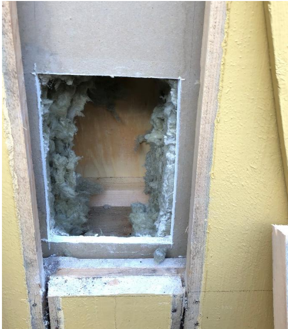
Kuva 6. Ulkoseinään tehty rakenneavaus
