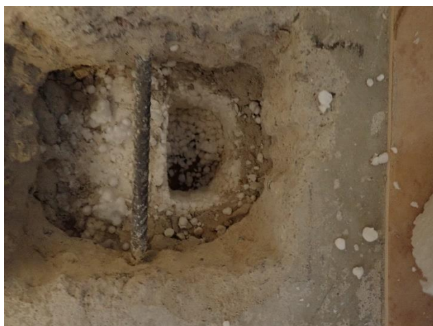
Kuva 4. Alapohjan rakenneavaus tilassa 3
