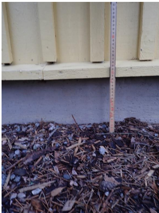
Kuva 8. Monin paikoin laudoitus alkaa liian läheltä maanpintaa. Suositeltu etäisyys on vähintään 300mm.
