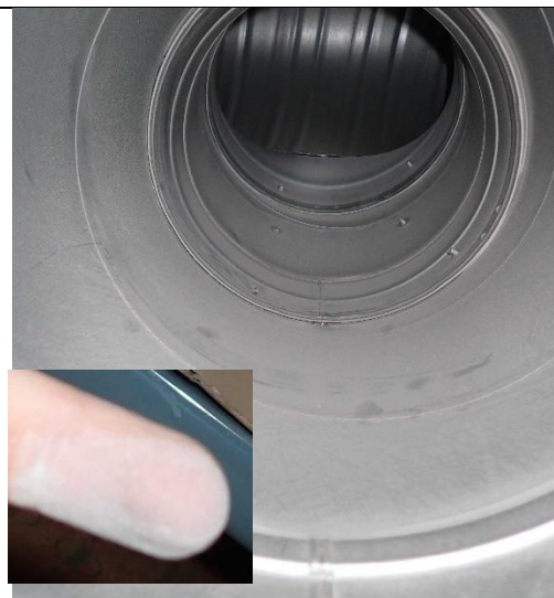
Kuva 27. Arviointipiste KP2, poistoilmakanava TK01, pölykertymäarvio alle 2 \text{ g/m}^2 .
