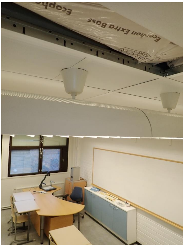
Kuvat 12 ja 13. Toisessa kerroksessa opetustiloissa on pussitettua Ecophon mineraalivillaa alakattolevytyksen päällä.
