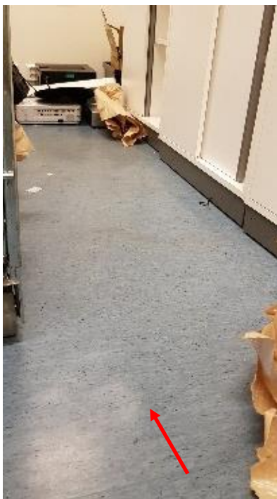
Kuva 24. Tilassa 1055 muovimattolattia kuprulla.
