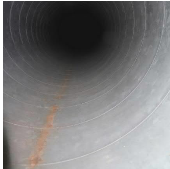
Kuva 28. Tuloilmakanava tilassa 117, sisäpinnan pölykertymäarvio oli alle 1 g/m 2 (arviointipiste KP3).
