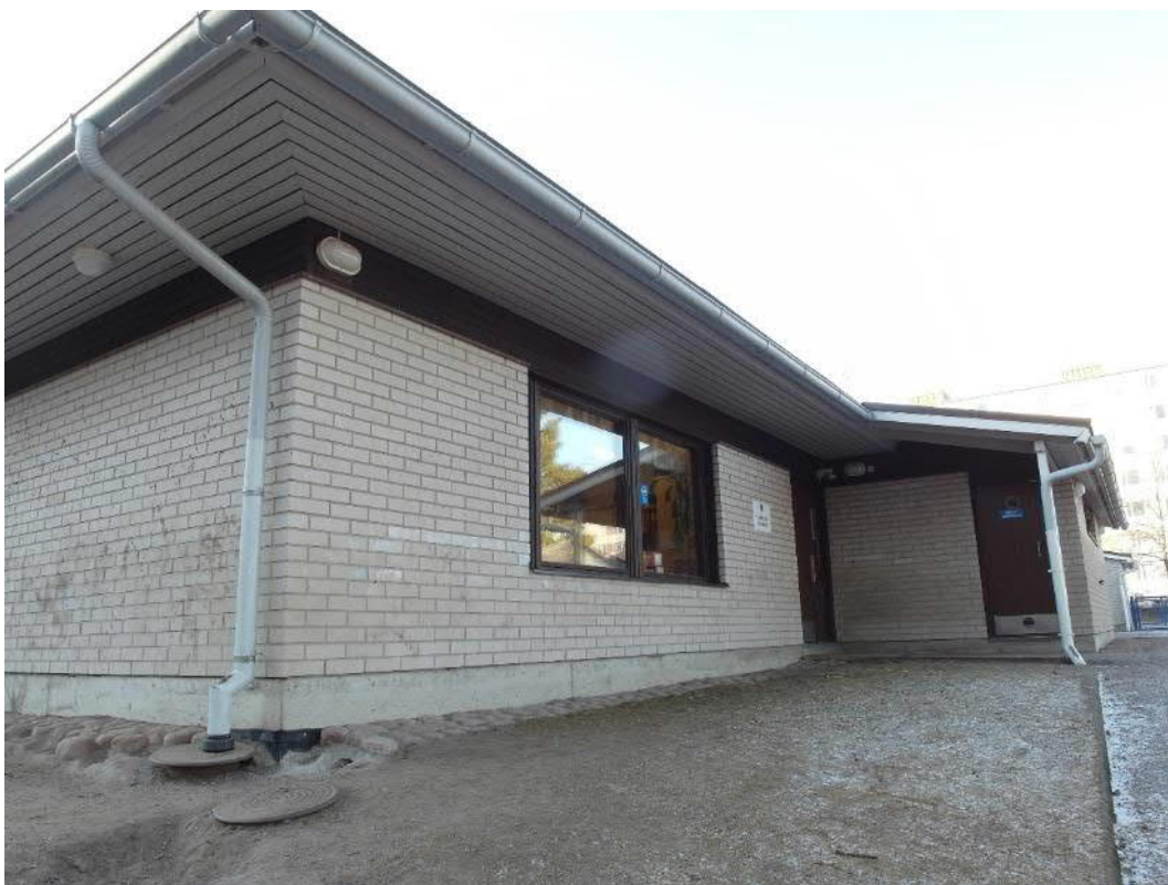
Kuva 25. Kuva sisäpihalta (pohjoiseen päin). Piha viettää pohjois- ja itäjulkisivuilla pois- päin rakennuksesta.
