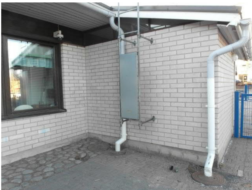
Kuva 21. Sadevesikourut on johdettu suoraan sadevesikaivoihin. Tämä vähentää sadeveden roiskumista ulkoseinän ja sokkelin pinnoille.
