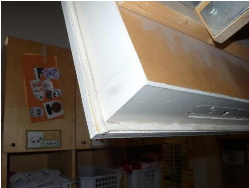
Kuva 14. Käytävällä on käyntiluukku yläpohjan ontelotilaan, jossa on ilmanvaihtokonehuone. Luukussa on tiivisteet.
