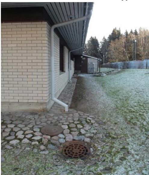
Kuva 24. Kuva takapihalta (etelään päin). Piha viettää kauempana rakennukseen päin, mutta sokkelin välittömässä läheisyydessä maa viettää poispäin rakennuksesta.
