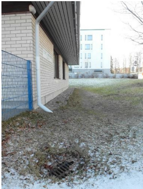
Kuva 23. Kuva julkisivulta länteen päin. Piha viettää kauempana rakennukseen päin, mutta sokkelin välittömässä läheisyydessä maa viettää poispäin rakennuksesta.
