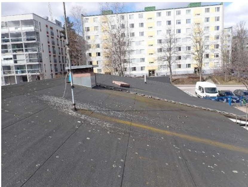
Kuva 16. Vesikatolla on jäkälää, mutta kermikate on tyydyttävässä kunnossa. Katon poikki pituussuunnassa ei ole kattosiltaa. Katolla ei ole erillisiä pollareita. Katolla ei ole lumi- miesteitä.
