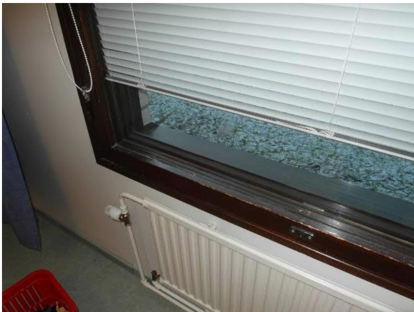
Kuva 6. Rakennuksessa on 1+1 -tyyppiset puuikkunat. Ikkunoissa ei todettu jälkiä vesivuodoista. Ikkunat olivat pääasiassa hyväkuntoisia. Tarkastuskohdissa ikkunat toimivat normaalisti
