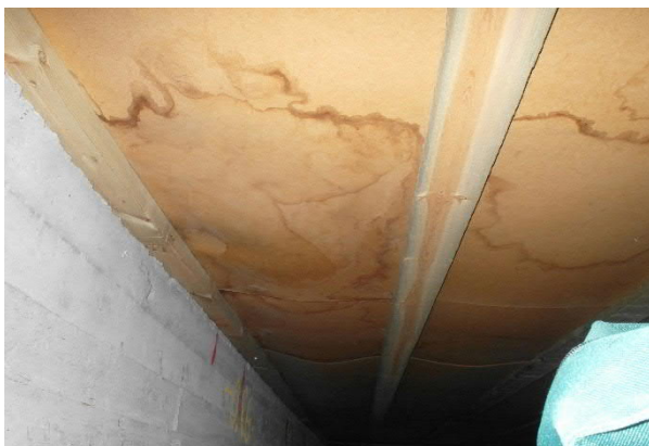
Kuva 5. Ryömintätilassa oli yleensä vesipisteiden ja märkätilojen yhteydessä vanhoja vesivuotojälkiä. Pintakosteusilmaisimen perusteella kohdissa ei todettu viitteitä kosteudesta.
