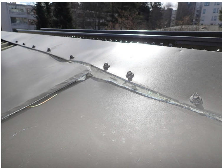
Kuva 23 . Teräsohutlevyliittymien tiivistelyjä katon harjalla.
