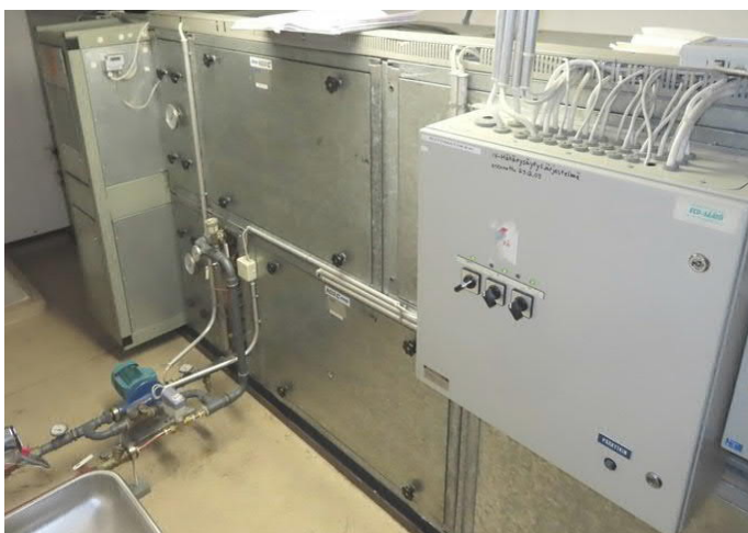
Kuva 32. Ilmanvaihtokone TK1/PK1.
