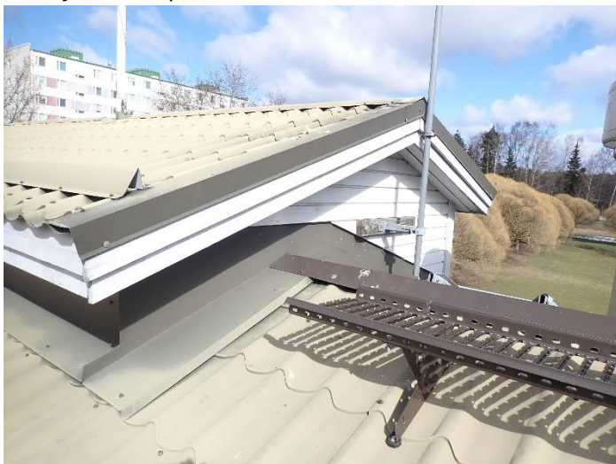
Kuva 22 . Yleiskuva vesikatolta. IV-konehuoneen päällä vesikatto on korotettu.
