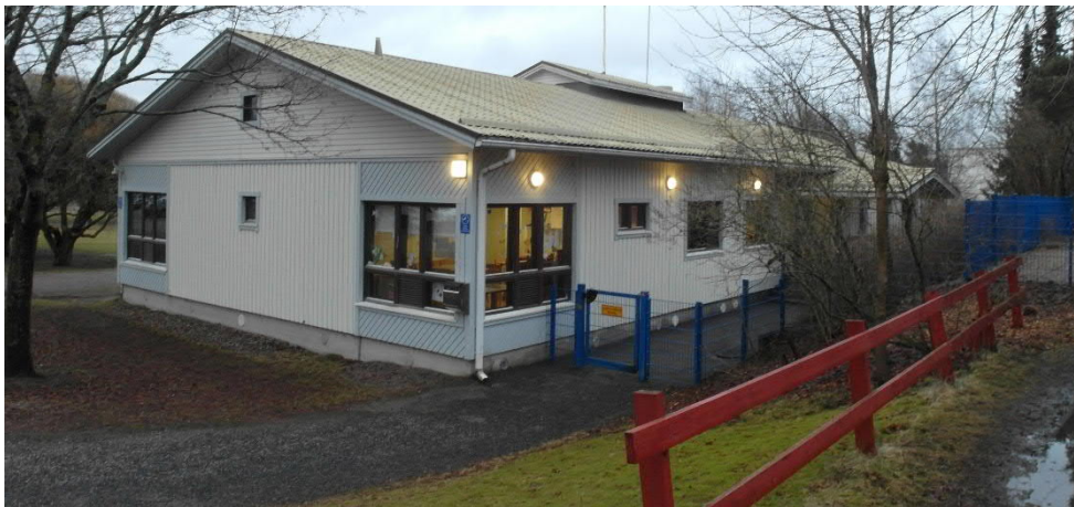
Kuva 29. Rakennuksen julkisivuna on puunpanelointi. Maapinta viettää rakennukseen päin länsi- ja eteläjulkisivulta. Muilla julkisivuilla maapinta viettää rakennuksesta poispäin.
