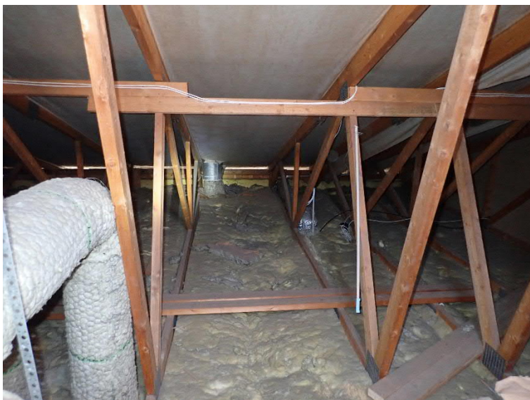
Kuva 24 . Yleiskuva yläpohjan eristetilasta. Tila tuulettuu pitkien sivujen räystäiden kautta.
