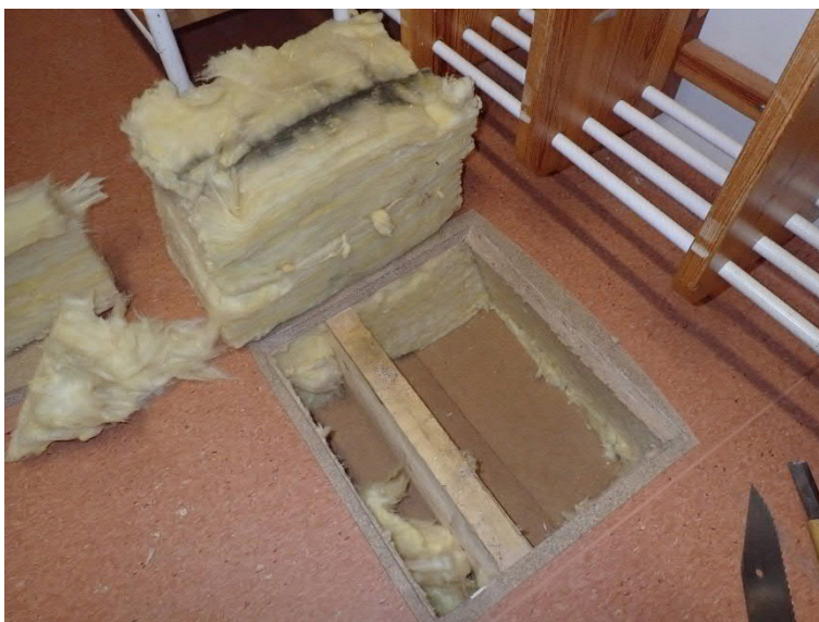
Kuva 9. Esimerkki alapohjarakenteen rakenneavauksesta. Käytävän 102 lattian rakenneavaus WC-tilan 110 vierestä. Mineraalivillassa havaittiin tuulensuojalevyn sauman kohdalla viivamainen tummentuma, joka on seurausta ilmavuodoista. Mikrobitutkimuksen perusteella mineraalivillassa on mikrobikasvustoa.
