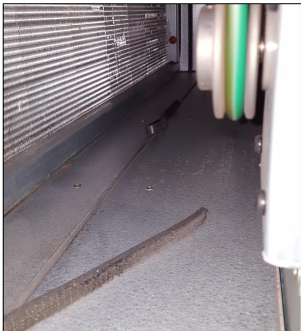
Kuva 26. Ilmanvaihtokoneen tuloilmakammion irtonainen tiiviste.
