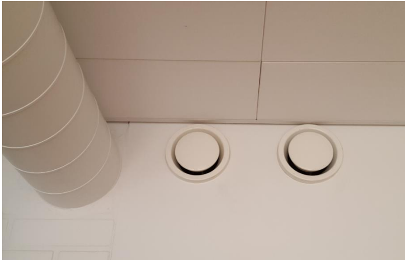
Kuva 34. Poistoilmaventtiili KSO.
