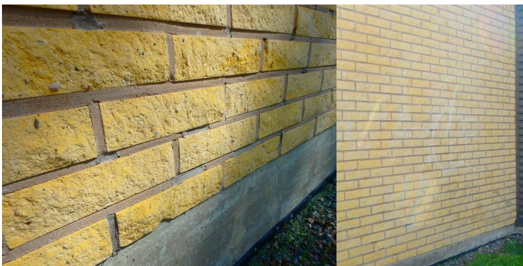
Kuvat 16 ja 17. Julkisivu muurausten saumoja on mm. korjattu elastisella kitillä. Grafiitti on pesty pois.
