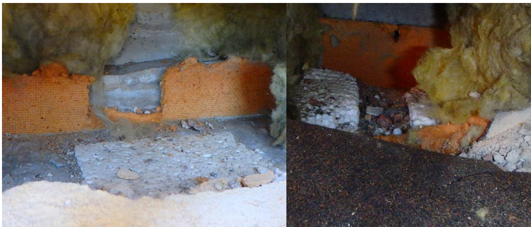
Kuvat 8 ja 9. Ulkoseinään tehdyissä avauksissa 1 ja 5 havaittiin kovalevyä. Avauksessa 5 oli kermi sokkelin ja tiilimuurauksen välissä
