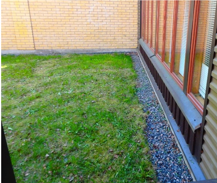
Kuva 23. Rakennuksen pohjoissivu viettää loivasti kohti rakennusta.
