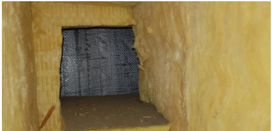
Kuvat 15-19. Tilan B138 katossa todettiin yläpohjan lämmöneristeissä vesivuotojälkiä myös tilan B139 puoleisella sivulla. Aluskatteen sisäpinta oli märkä. Lämmöneristeiden yläpinnalla oli kosteusjälkiä aluskatetta puhkovien naulojen kohdalla.
