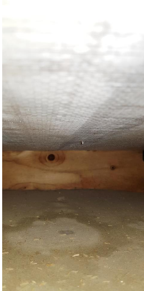
Kuvat 15-19. Tilan B138 katossa todettiin yläpohjan lämmöneristeissä vesivuotojälkiä myös tilan B139 puoleisella sivulla. Aluskatteen sisäpinta oli märkä. Lämmöneristeiden yläpinnalla oli kosteusjälkiä aluskatetta puhkovien naulojen kohdalla.
