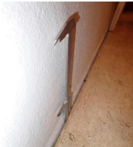
Kuva 15. Tilassa 25 tilan 26 väliseinän ja alapohjan liittymään sai mahtumaan työntömitan.
