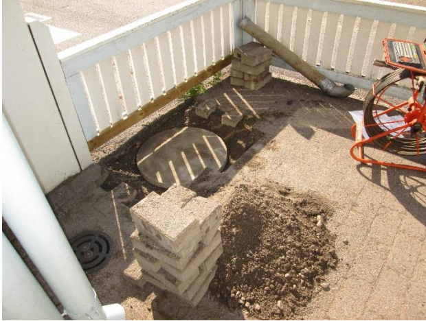
Kuva 5: kaivo SOK 8 otettuna esille kivetyksen alta.
