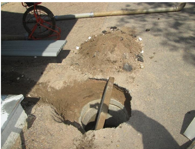
Kuva 7: Kaivo SOK 5 otettuna esille asfaltin alta.
