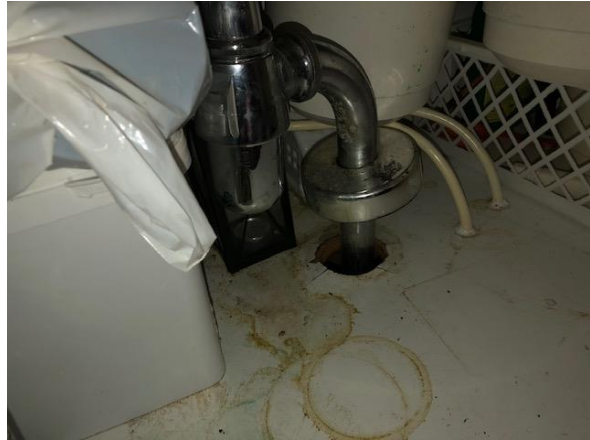
Kuvat 10. ja 11. Ryhmätilan "Satakielet" pesualtaan kaapissa havaittiin irtonainen viemäriiliitos.
