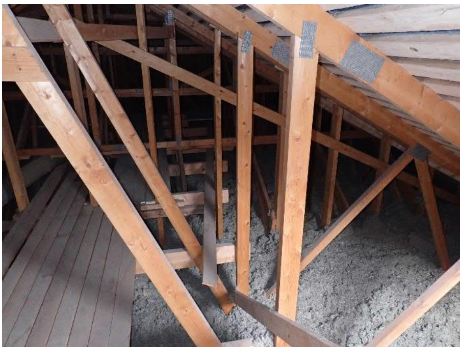
Kuva 52. Yläpohjan eristetila on aistinvaraisen arvion mukaan siisti ja siellä ei havaittu poikkeavaa hajua.
