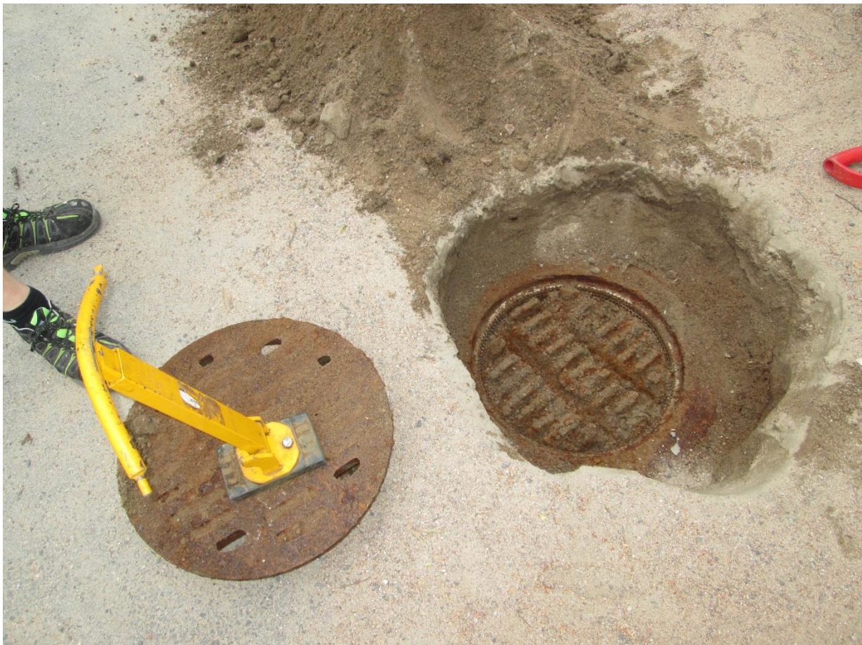
Kuva 3: SVK 9 kaivettuna esille.
