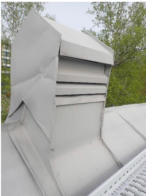
Kuva 48. Yläpohjan tuuletus tapahtuu osittain kuvan tuuletusaukkojen kautta. Tuuletusaukkoja on 8 kappaletta katolla.
