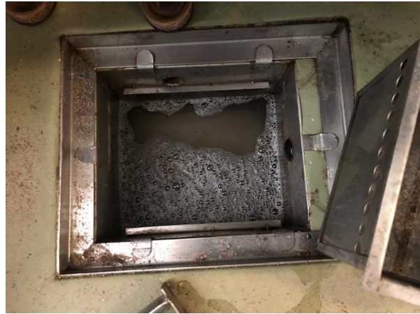
Kuvat 5. ja 6. Hiekanerotuskaivoissa ei havaittu huomautettavaa. Kaivojen huoltaminen on tehty hyvin.
