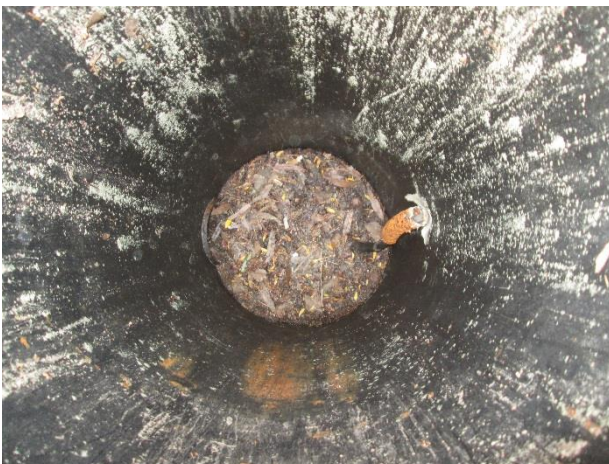
Kuva 7 ja 8: Rännikaivoja, jotka lähes tukossa irtokertymästä.
