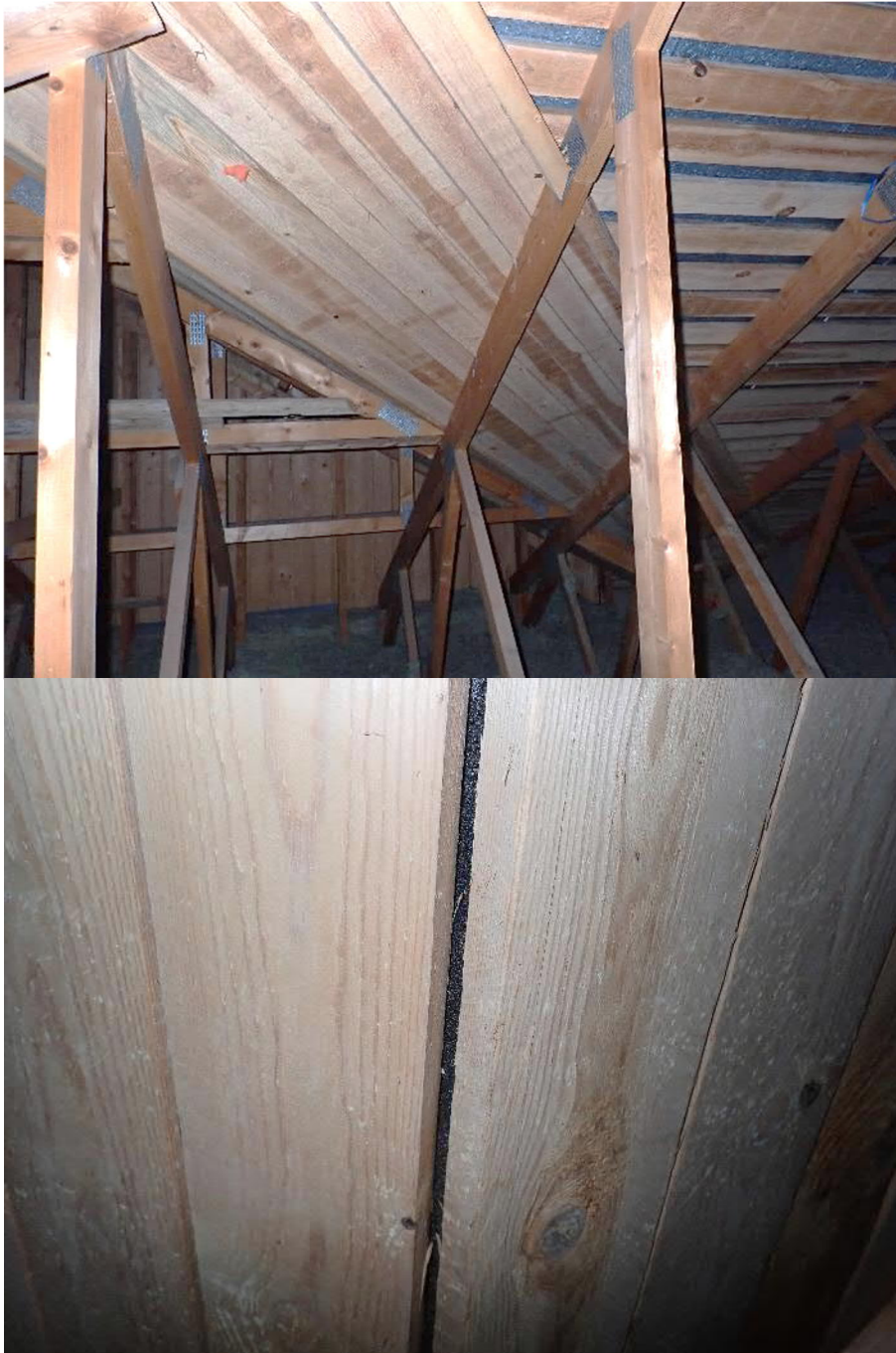
Kuvat 55 ja 56. Jiirien kohdalla on aluskatteena toimiva bitumikermi.
