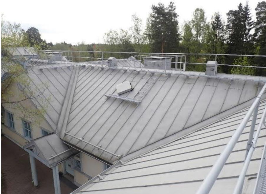
Kuva 46. Vesikatolla on nykyaikaiset turvavarustelut. Vesikatteen pinnoite vaikuttaa vuoden 2015 jälkeen uusitulta. Kattosillat ovat kiinnitetty puristamalla peltikatteen saumoihin.
