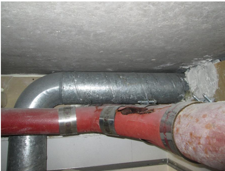
Kuva 2. Laaja reikä vaakaviemärimässä "katossa" Keltasirkkujen kuraeteisessä.
