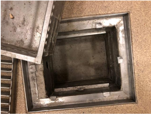
Kuvat 5. ja 6. Hiekanerotuskaivoissa ei havaittu huomautettavaa. Kaivojen huoltaminen on tehty hyvin.
