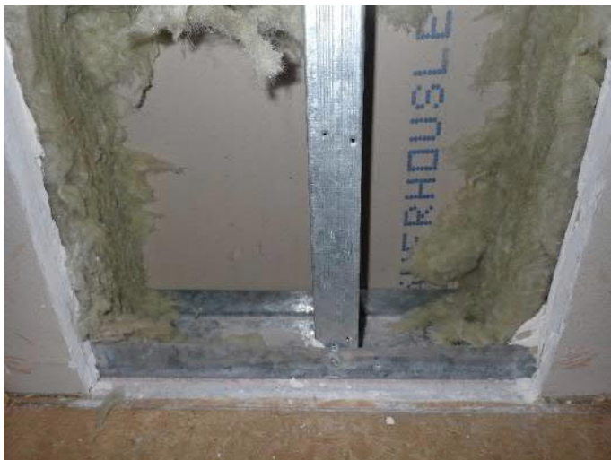
Kuva 43. Väliseinien rakenneavauksissa ei yleisesti todettu poikkeavaa.
