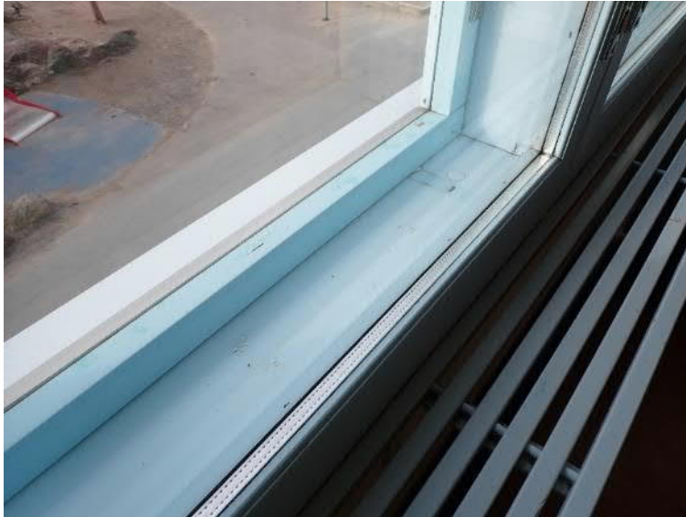
Kuva 28. Ikkunat ovat rakennuksessa kaksipokaisia, joista sisempi on kaksilasinen lämpölasi (MSE). Ikkunat ovat puurakenteisia. Ikkunat olivat tarkastetuilta osin hyväkuntoisia.
