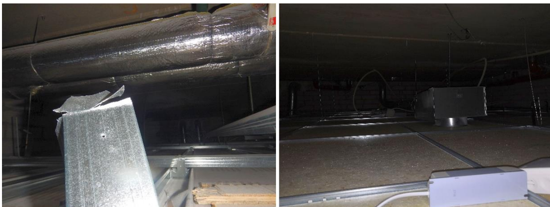
Kuva 26a ja b. Vasemman puoleisessa kuvassa on esitetty yleiskuva apulaisrehtorin huoneen alakattotilasta ja oikeanpuoleisessa kuvassa yleiskuva rehtorin huoneen alakattotilasta. Etenkin apulaisrehtorin huoneen alkuperäisessä alakattotilassa oli reilusti pölykertymää.
