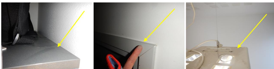
Kuva 38a - c. Käyttötiloissa todettiin pölykertymiä mm. hyllyjen/pöytien päällä, taulujen päällä, ovikarmien ylätasolla ja kattovalaisimien päällä. Vasemmanpuoleinen kuva on opion huoneen tasopinnalta, keskellä oleva kuva käytävän ilmoitustaulun päältä ja oikeanpuoleinen kuva apulaisrehtorin huoneesta.
