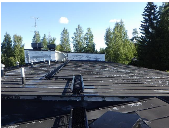
Kuva 107. Yleisnäkymä A-osan vesikatolle
