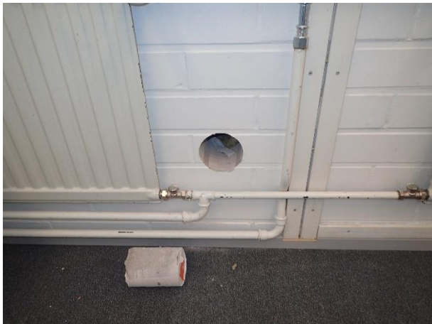
Kuva 1. Avauskohta ikkunan alapolella
