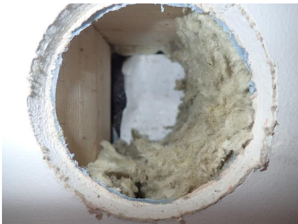
Kuva 3. Ulkoseinän rakennekerroksia
