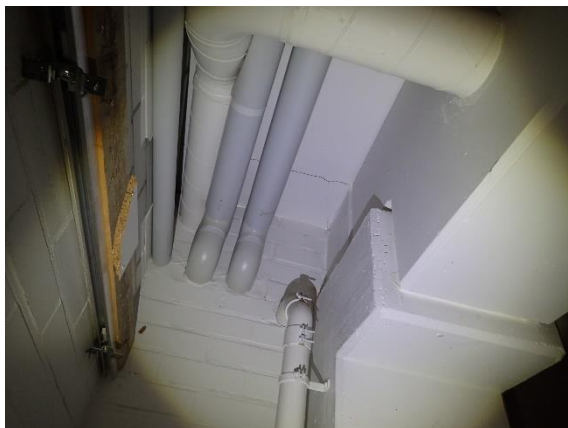
Kuva 65. Sama halkeama jatkuu tuoli- ja näyttämövaraston puolella 107.
