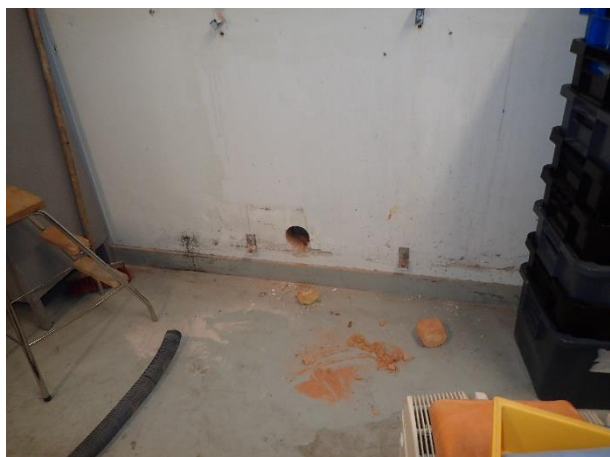
Kuva 1. Avauskohta maanvastaisen seinän alaosaan.
