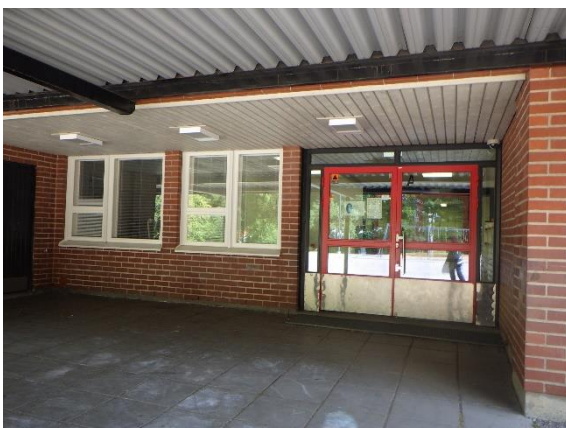
Kuva 60. A-osan pääsisäänkäynnin ulko-ovet
