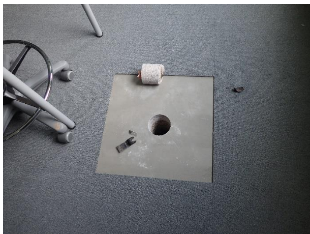
Kuva 1. Avauskohta alapohjaan ja kanaaliin
