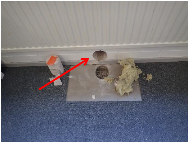
Kuva 1. Avauskohta ikkunan alapolella
