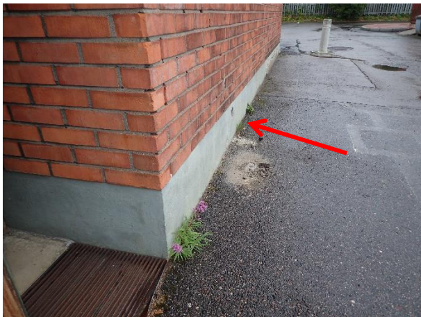
Kuva 1. Avauskohta on sokkelin yläosassa.
