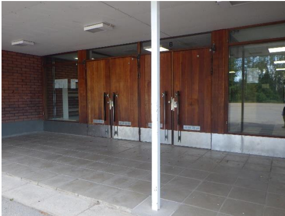
Kuva 58. B-osan pääsisäänkäynnin ulko-ovet
