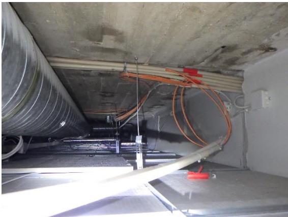
Kuva 99. Alakattotilaa B-osan käytävässä
