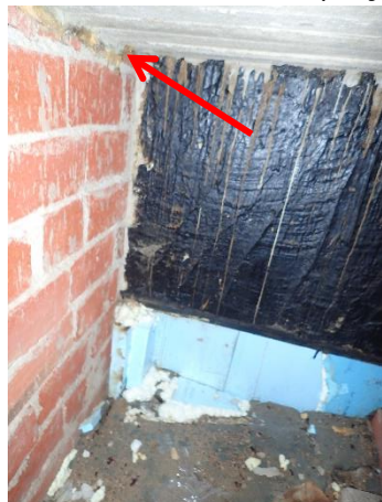
Kuva 3. Kuva kanaalista, avauskohdasta ulkoseinää kohti. Syrjälleen muuratun tiilimuurauksen ja kanaalin katon välissä on mineraalivillaa.
