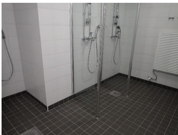
Kuva 18. Pesu- ja WC-tiloissa lattiapäällysteenä on keraamiset laatat.
