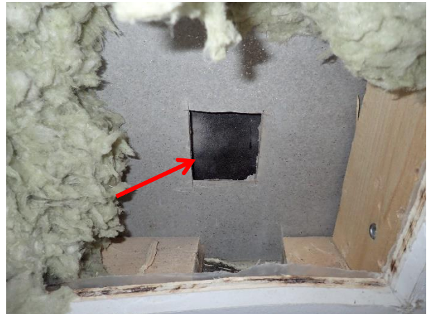
Kuva 2. Tuulensuojalevyn takana on bitumikermi
