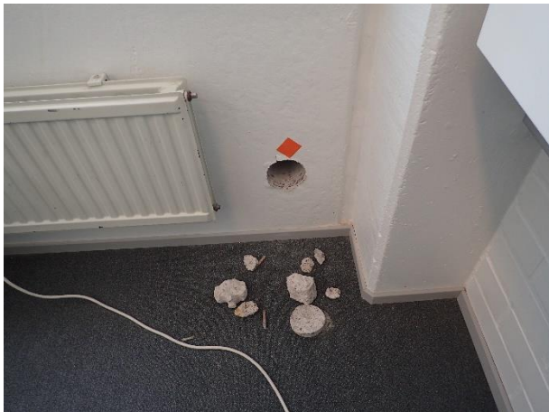
Kuva 1. Avauskohta ikkunan alapolella
