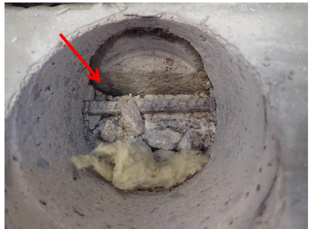
Kuva 2. Lattialaatan erotuskaistana oli bitumoitua kreppipaperi, kuvassa näyte on jo otettu.
