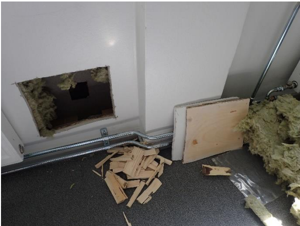
Kuva 1. Avauskohta seinän alaosassa
