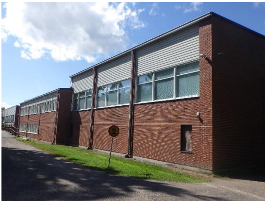
Kuva 5. A-osan takasivulla maanpinta viettää rakennukseen päin, mutta sokkelin vieressä maanpinta on muotoiltu rakennuksesta poispäin viettäväksi
