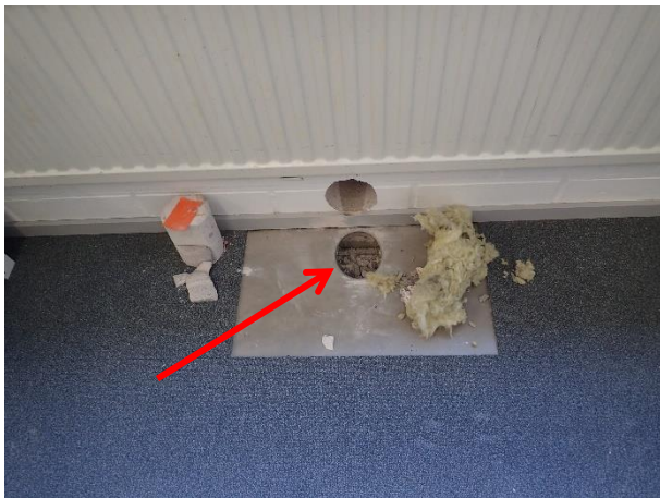
Kuva 1. Avauskohta ulkoseinän vieressä
