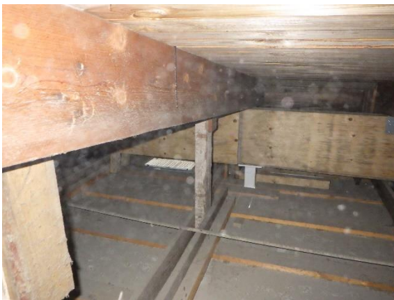
Kuva 83. B-osan yläpohjatila tuulettuu räystäällä olevien aukkojen kautta
