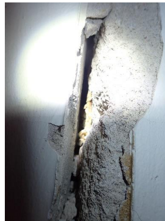
Kuva 2. Rakenne ositain avattuna
