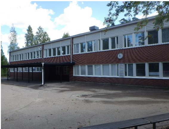
Kuva 2. Piha-alue on pääosin asfaltoitu
