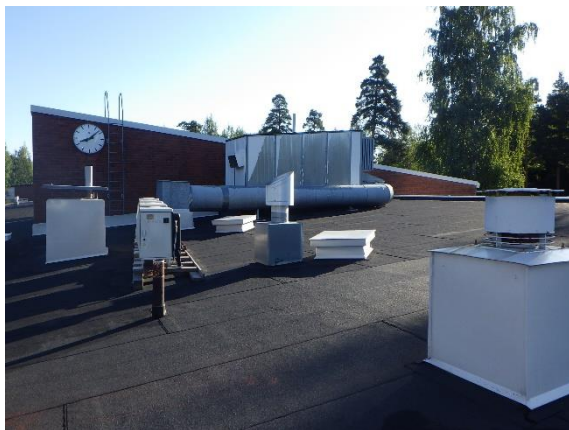
Kuva 102. Yleisnäkymä B-osan vesikatolle
