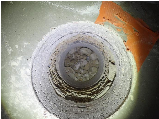
Kuva2. Alapohjan rakennekerroksia
