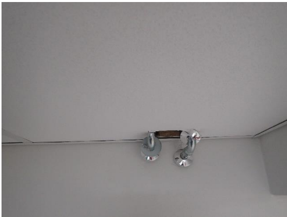
Kuva 75. Putkiläpivienti väliseinässä liikuntasauman kohdalla tilaan 155, kuva käytävältä 135.
