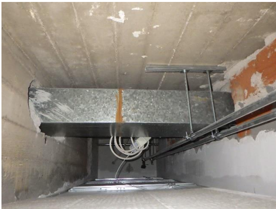
Kuva 97. Alakattotilaa B-osan käytävässä tilan 157 edustalla
