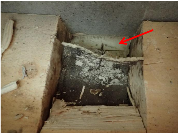
Kuva 3. Alaohjauspuun alla on bitumikermi ja uretaanilevy.
