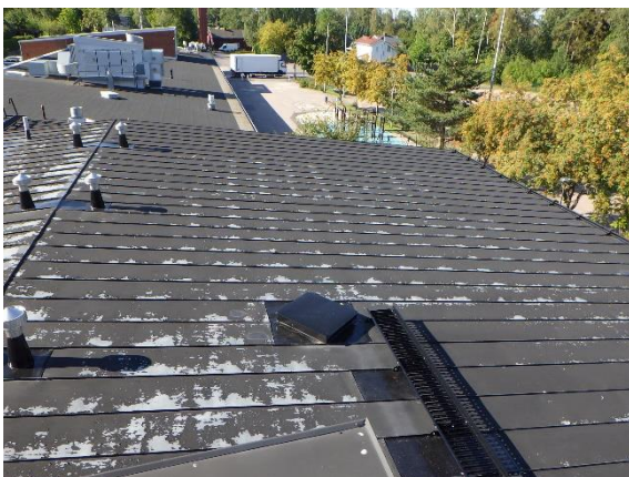
Kuva 108. Yleisnäkymä A-osan vesikatolle
