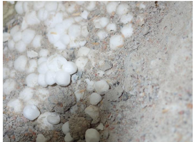
Kuva 4. Sokkelihalkaisu on polystyreeniä.
