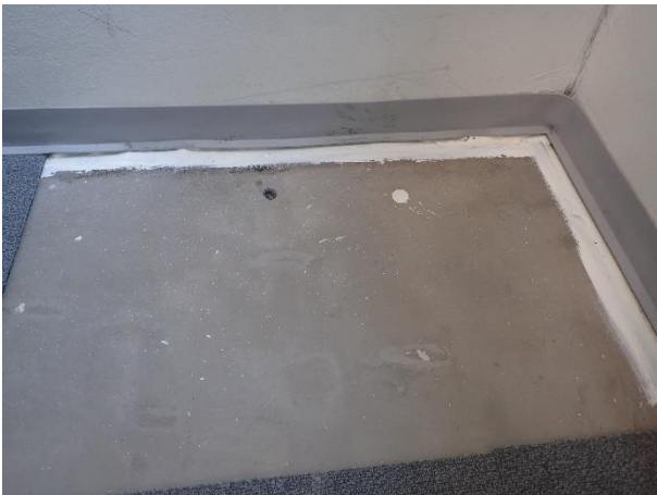
Kuva 1. Rakenneporaus alapohjaan
