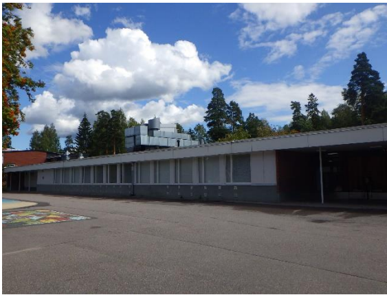
Kuva 1. Piha-alue on pääosin asfaltoitu
