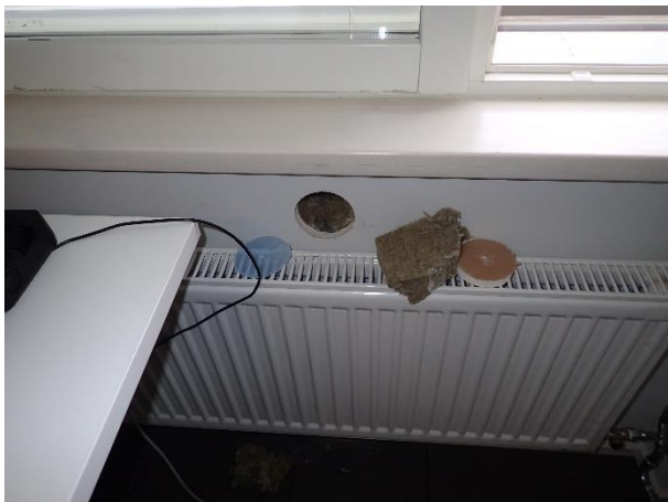
Kuva 1. Avauskohta ikkuna ja patterin välisellä alueella.
