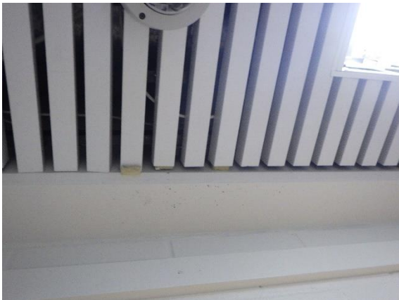
Kuva 93. Ritiäkattojen yläpuolella on villaeristeitä
