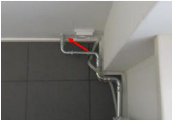
Kuva 54. Pistemäinen vuoto. Lepoh. 160
