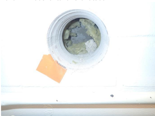
Kuva 2. Ulkoseinän rakennekerroksia.
