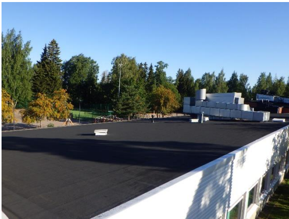
Kuva 103. Yleisnäkymä A-osan vesikatolle
