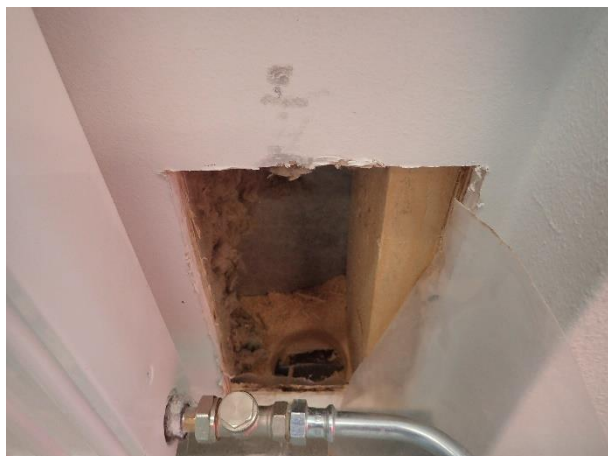
Kuva 1. Avauskohta seinän alaosa
