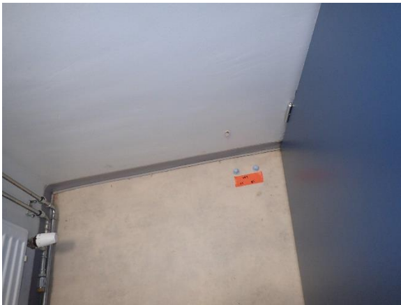
Kuva 24. Tuulikaapin 145 lattian suhteellinen kosteus on koholla.
