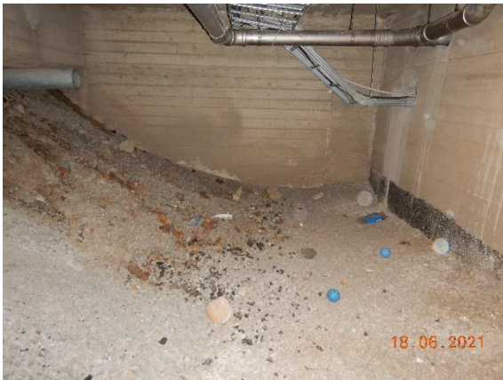
Kuva 25. Yleiskuvaa ryömintätilasta, vasemmassa reunassa etupihan puolen tuuletusputkenpää.
