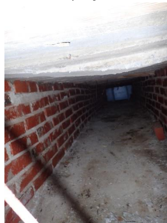
Kuva 4. Kuva kanaalista, avauskohdasta käytävälle päin kuvattuna.
