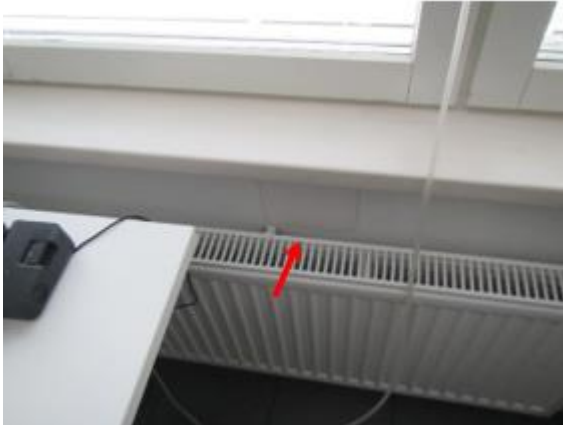
Kuva 56. Pistemäinen vuoto. Terv.huolt/psykologi 162
