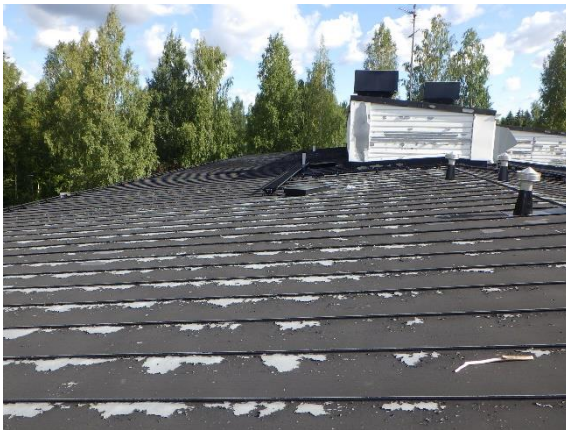
Kuva 109. Yleisnäkymä A-osan vesikatolle
