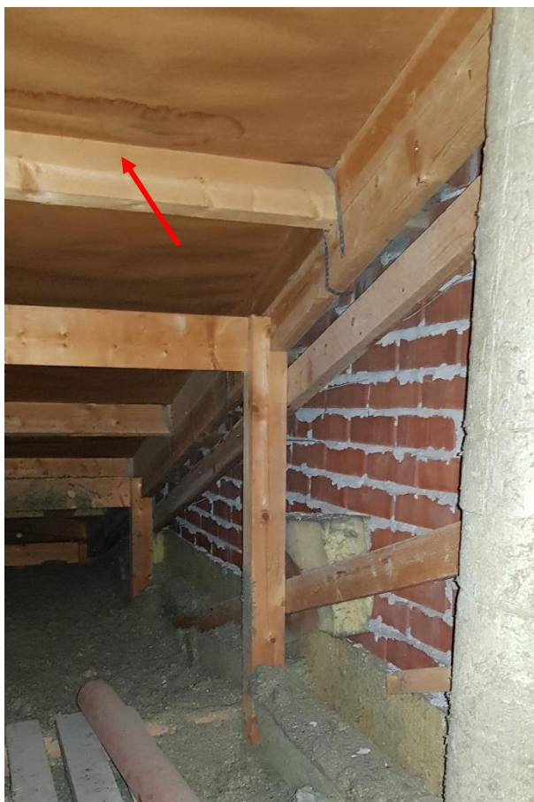
Kuva 12. Laajennusosan yläpohjassa YP1 on pahvinen panssarialuskate. Luukun kohdalla ja kateen saumakohdassa oli vanhat vesivuotojäljet. Muutoin rakennepinnoilla ei havaittu viitteitä vesikattovuodoista.
