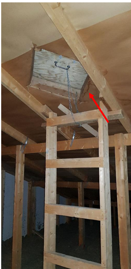
Kuva 12. Laajennusosan yläpohjassa YP1 on pahvinen panssarialuskate. Luukun kohdalla ja kateen saumakohdassa oli vanhat vesivuotojäljet. Muutoin rakennepinnoilla ei havaittu viitteitä vesikattovuodoista.
