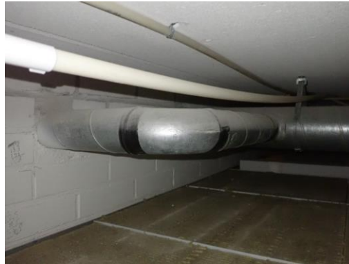
Katon tarkastuspiste 2. Kattolevyjen ja iv-putkien päällä silminnähden likaa ja pölyä. Kattolevyissä villaa.
