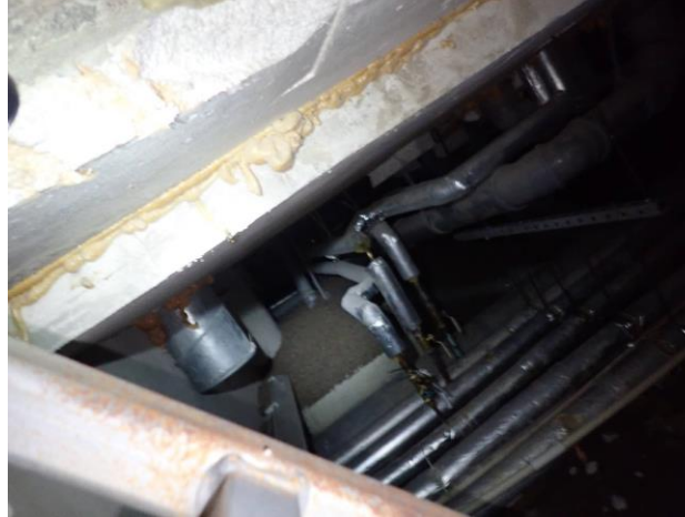
Lattialuukun tarkastuspiste 2. Läpivientejä alapohjasta huonetilaan. Ryömintätilassa eristelevyjä.
