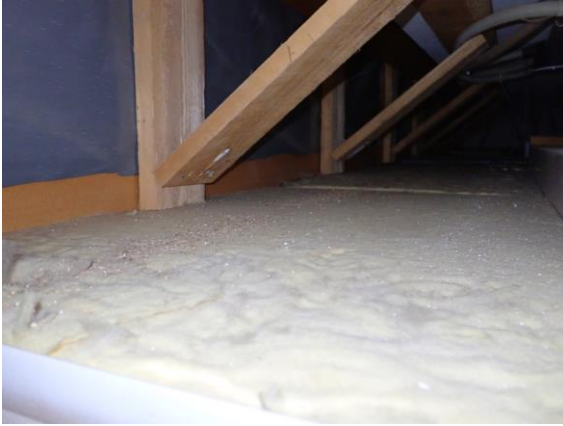
Katon tarkastuspiste 3. Kattolevyjen päällä silminnähdn likaa ja pölyä. Kattolevyissä villaa. Kattopalkin päällä villaa.
