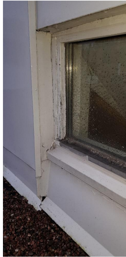
Kuvat 19, 20 ja 21. Kattolyhtyjen pellitysten saumoja ikkunarakenteisiin on massattu ja ne ovat silmämääräisesti arvioituna vesitiiviit.
