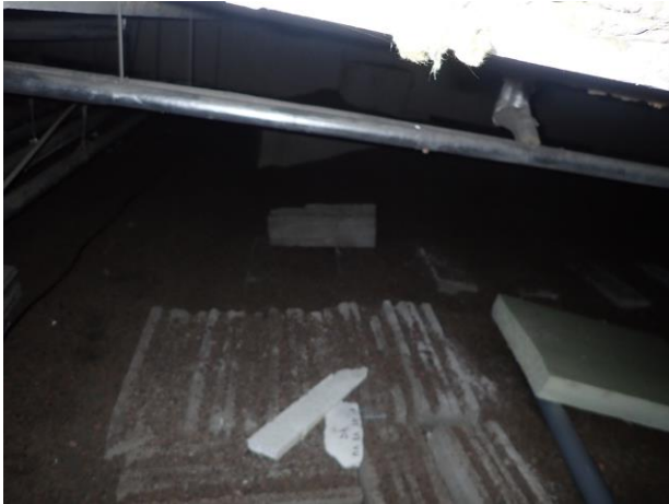
Lattialuukun tarkastuspiste 2. Läpivientejä alapohjasta huonetilaan. Ryömintätilassa eristelevyjä.
