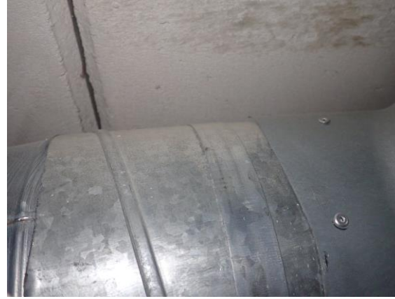
Katon tarkastuspiste 5. Kattolevyjen ja iv-putkien päällä silminnähden likaa ja pölyä. Välitilassa ylimääräisiä villapaloja.
