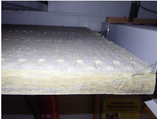
Katon tarkastuspiste 2. Kattolevyjen ja iv-putkien päällä silminnähden likaa ja pölyä. Kattolevyissä villaa.
