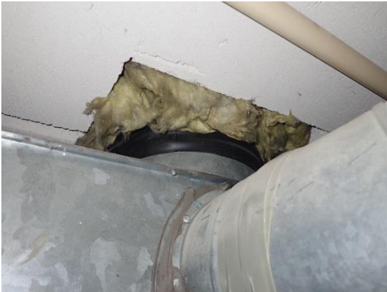
Katon tarkastuspiste 4. Kattolevyjen ja iv-putkien päällä silminnähdn likaa ja pölyä. Yläpohjan läpivienneissä villaeristettä.
