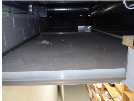
Katon tarkastuspiste 4. Kattolevyjen ja iv-putkien päällä silminnähdn likaa ja pölyä. Yläpohjan läpivienneissä villaeristettä.
