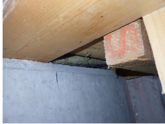
Katon tarkastuspiste 3. Kattolevyjen päällä silminnähdn likaa ja pölyä. Kattolevyissä villaa. Kattopalkin päällä villaa.
