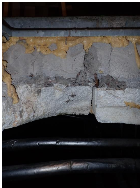
Havainto 6. Lattialuukku, tuulettuvan alapohjan rakenne. Pieni ilmavirta huonetilaan päin. Ryömintätila siisti
