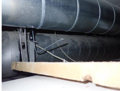
Katon tarkastuspiste 1. Kattolevyjen ja iv-putkien päällä silminnähden likaa ja pölyä. Kattolevyissä villaa.
