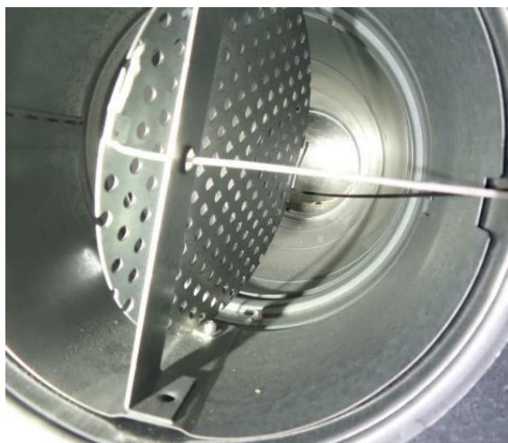
Kuva 33. Tuloilmakanava, tila 13. Sisäpinnan pölykertymäarvio oli alle 1 g/m 2 (arviointipiste KP2).
