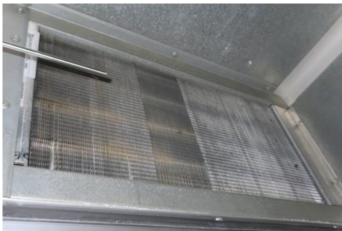
Kuva 30. Lämmityspatteri, jonka lamellien pölyn määrä oli vähäinen.).
