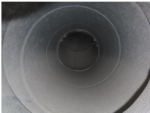
Kuva 35. Poistoilmakanava, tila 26. Sisäpinnan pölykertymäarvio oli 2-3 g/m 2 (arviointipiste KP6).
