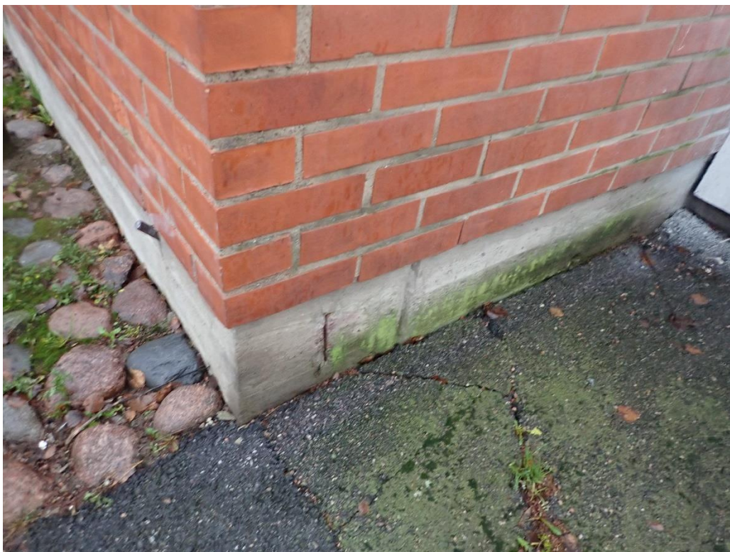
Kuva 6. Sokkelin ulkopinnassa oli yksittäisiä teräksiä näkyvissä. Kuva tilan 52 kohdalta.
