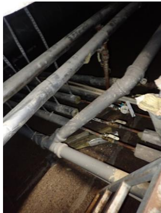
Lattialuukun tarkastuspiste 1. Läpivientejä alapohjasta huonetilaan.
