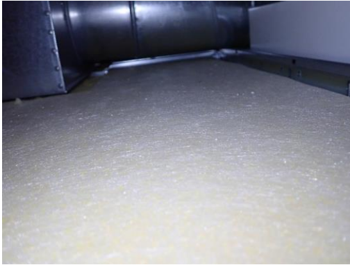
Katon tarkastuspiste 1. Kattolevyjen ja iv-putkien päällä silminnähden likaa ja pölyä. Kattolevyissä villaa.
