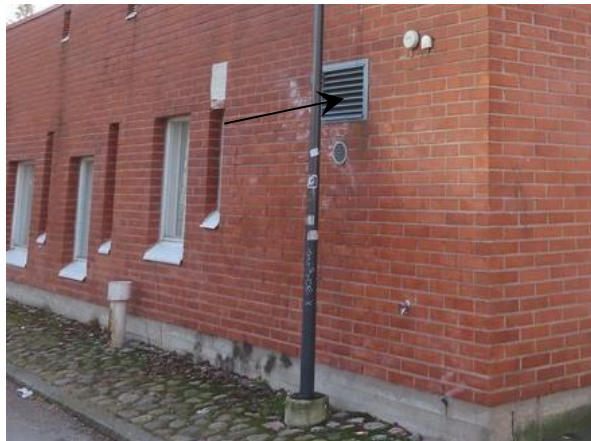
Kuva 28. Ulkoilmasäleikkö on ulkoseinällä. Säleikössä ei ole erillistä sääsuojaa.
