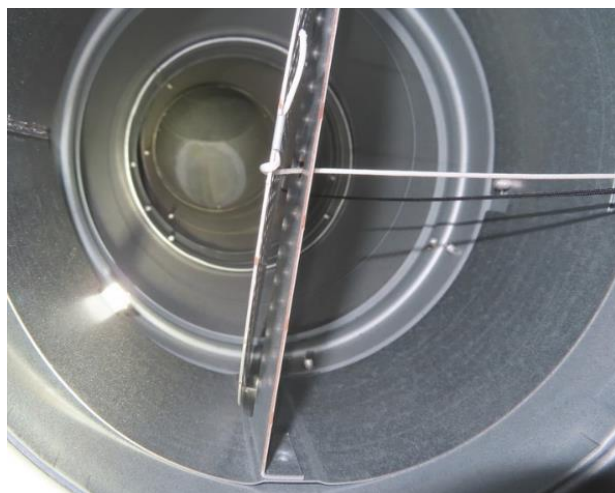
Kuva 34. Tuloilmakanava, tila 26. Sisäpinnan pölykertymäarvio oli alle 1 g/m 2 (arviointipiste KP3).
