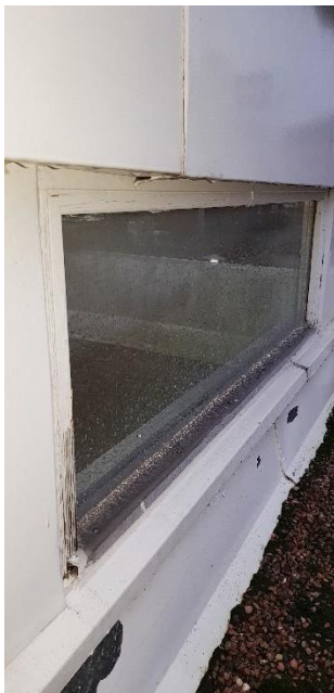
Kuvat 19, 20 ja 21. Kattolyhtyjen pellitysten saumoja ikkunarakenteisiin on massattu ja ne ovat silmämääräisesti arvioituna vesitiiviit.
