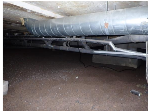
Katon tarkastuspiste 5. Kattolevyjen ja iv-putkien päällä silminnähden likaa ja pölyä. Välitilassa ylimääräisiä villapaloja.
