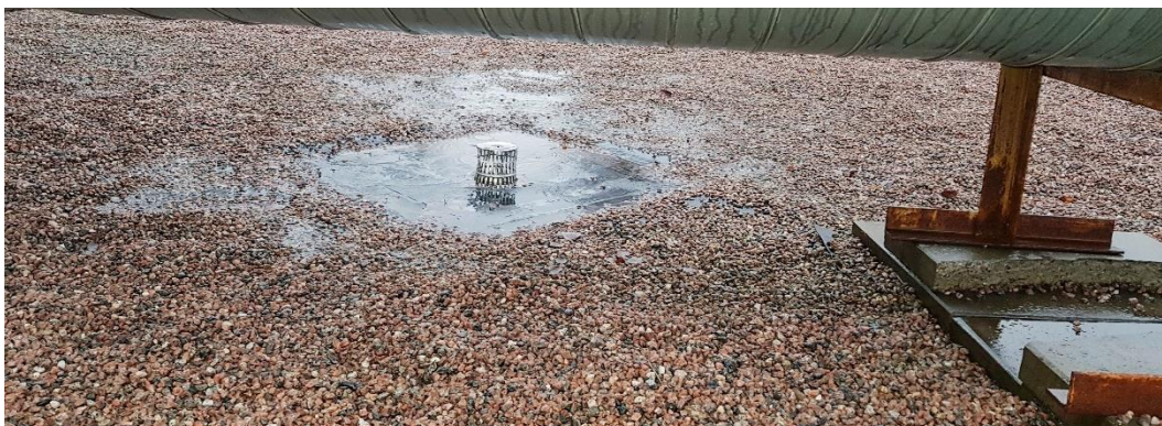
Kuva 16. Yläpohjan YP1 kattovesikaivoihin on asennettu ritilät ja kattokaivojen laippojen liittymiä kermeihin on kunnostettu.
