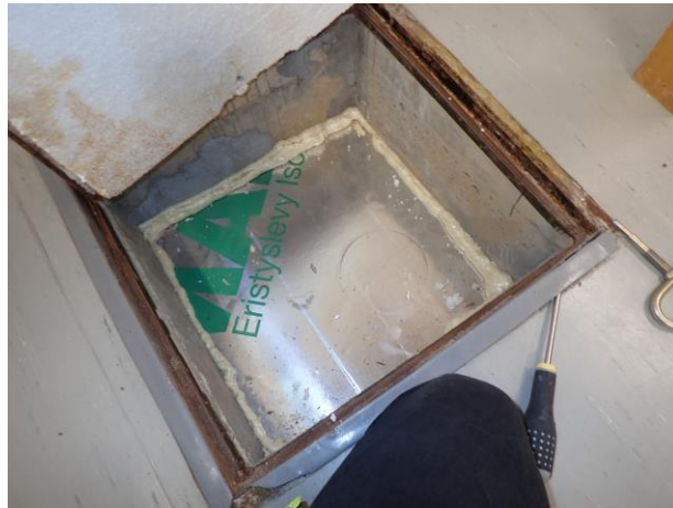
Lattialuukun tarkastuspiste 3. Lattialuukku täytetty eristelevyllä.
