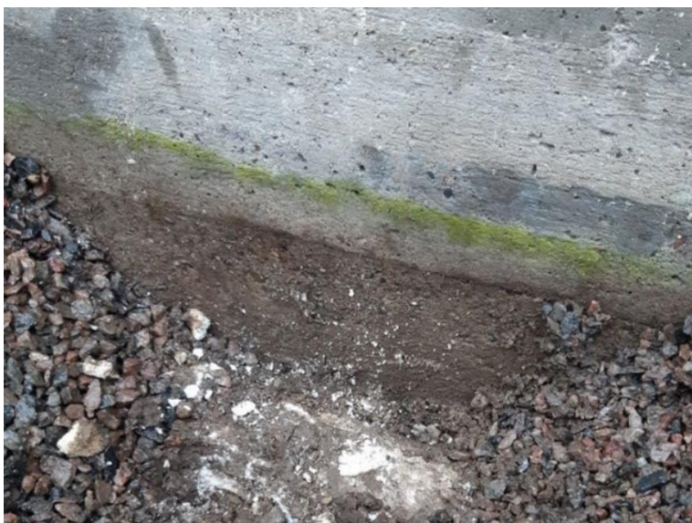
Kuvat 4 ja 5. Ylempi kuva tilan 29 kohdalla ja alempi kuva noin tilan 34 kohdalla.
