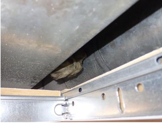
Katon tarkastuspiste 5. Kattolevyjen ja iv-putkien päällä silminnähden likaa ja pölyä. Välitilassa ylimääräisiä villapaloja.
