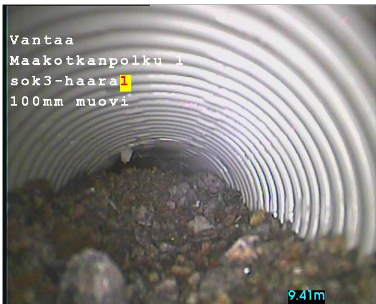
Runsaasti hiekkaa salaojakaivolle SOK 3 tulevan haaran loppupäässä.
