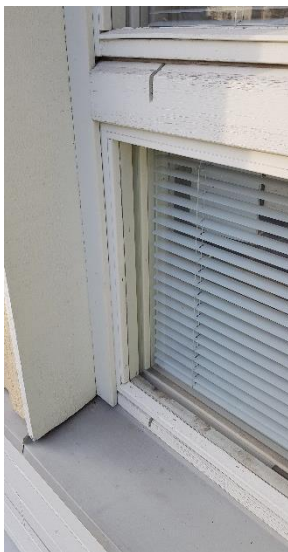
Kuvat 16 ja 17. Ikkunoiden ulkopuitteissa on mahdollisesti vedenpoistoa varten tehdyt tuuletusreiät. Ulkopuitteiden maalipinnat ja ikkunoiden kittaukset ovat kuluneita ja huoltokorjausta ei tehty. Alakarmien alapinnoilla on paikoin vanhoja kosteusjälkiä. Eniten kosteusjälkiä on havaittavissa tiloissa 11 ja 12.
