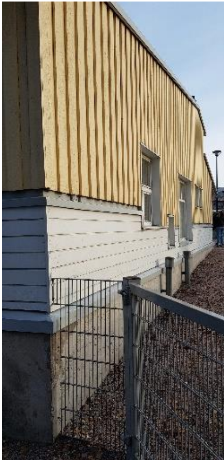
Kuvat 30 ja 31. Maanpintojen muotoilut ovat muutoin riittävät, eikä sadevesiä kerääny rakennuksen vierustalle.
