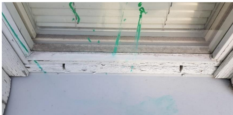
Kuvat 16 ja 17. Ikkunoiden ulkopuitteissa on mahdollisesti vedenpoistoa varten tehdyt tuuletusreiät. Ulkopuitteiden maalipinnat ja ikkunoiden kittaukset ovat kuluneita ja huoltokorjausta ei tehty. Alakarmien alapinnoilla on paikoin vanhoja kosteusjälkiä. Eniten kosteusjälkiä on havaittavissa tiloissa 11 ja 12.
