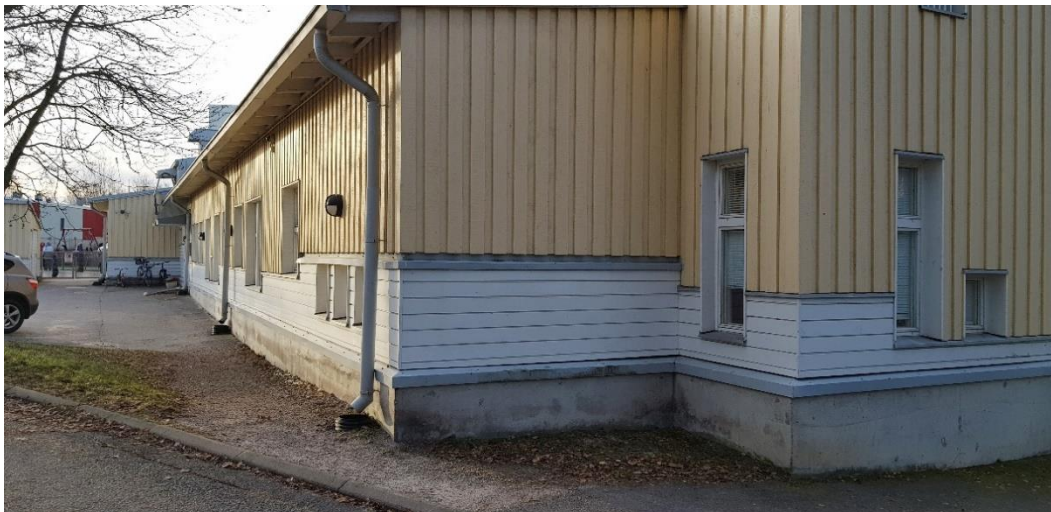
Kuva 29. Vesileikkihuoneen 42 puoleisella julkisivulla maanpinta viettää hieman rakennusta kohti, mutta sorapinnalla ei havaittu lätäkköä.
