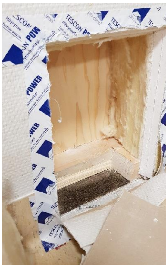
Kuvat 24 ja 25. Yhteistilassa 40 (ylempi kuva, avaus 11) ja ryhmähuoneessa 48 (alempi kuva, avaus 12) väliseinien alaosan puurunkorakenteet nostettu kivirakenteella pintalaatan päälle.
