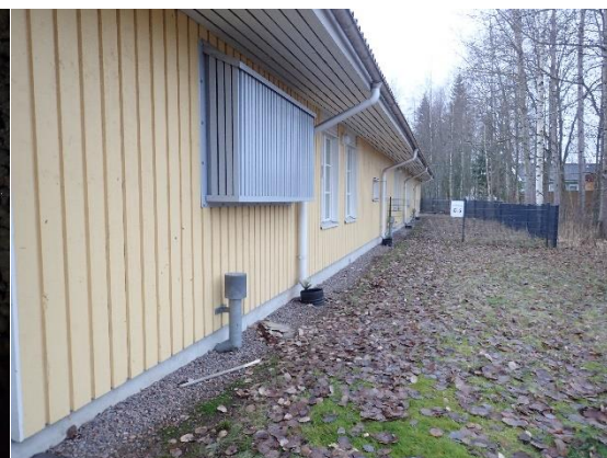
Kuva 9. Alustatilan tuuletusputki
