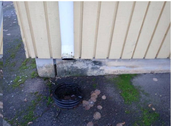
Kuva 21 ja 22. Syöksytorvet ovat lyhyet ja sadevesi pääsee kastelemaan sokkelia
