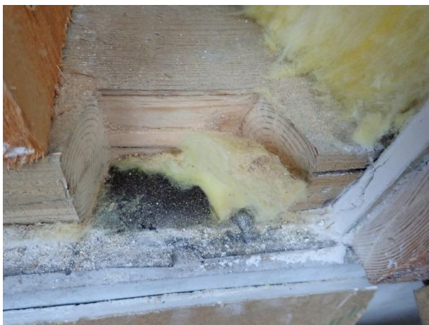
Kuva 13. Alaohjauspuun alla villakaista ja bitumihuopa
