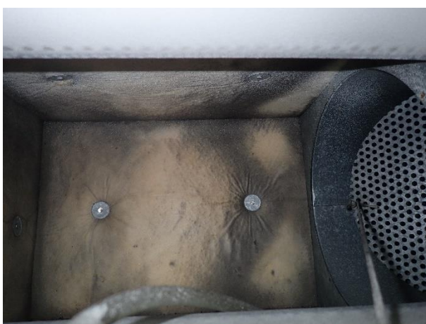
Kuva 26. Tuloilmalaitteessa mineraalivillaa
