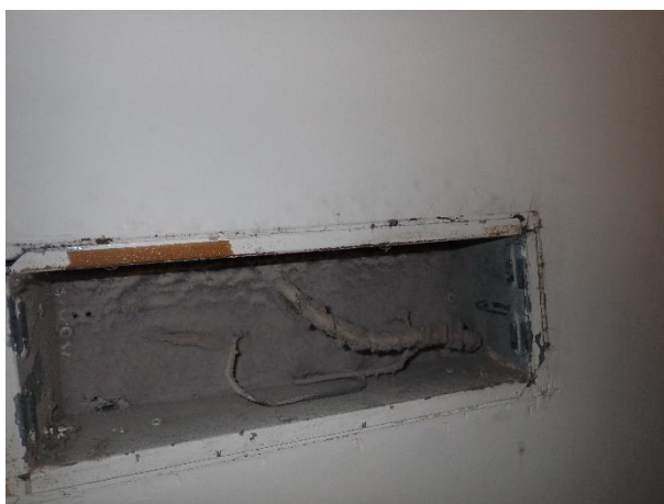
Kuva 28. Poistoilmalaitteessa pölyä
