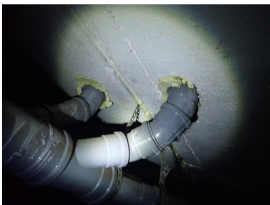
Kuva 6. Läpivientien tiivistyksiä
