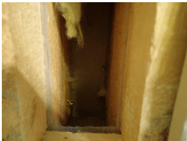
Kuva 12. Tilaan 47 tehty ulkoseinän (US1) rakenneavaus
