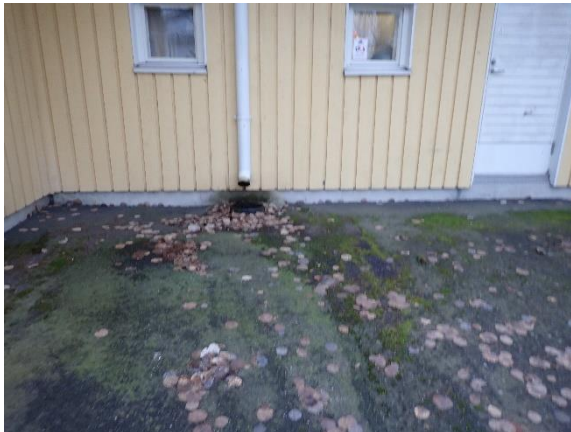
Kuva 21 ja 22. Syöksytorvet ovat lyhyet ja sadevesi pääsee kastelemaan sokkelia
