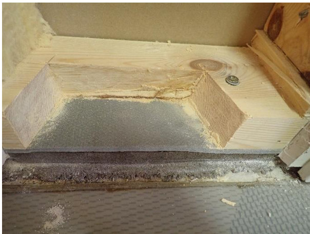
Kuva 18. Alaohjauspuun ja alapohjalaatan liittymä
