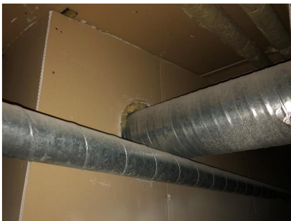
Kuva 24. Läpiviennin villatiivistys
