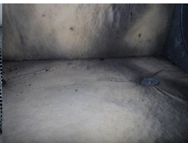
Kuva 27. Karkeaa likaa liitäntälaatikon pohjalla
