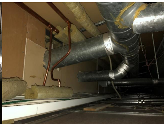
Kuva 25. Suojaamatonta mineraalivillaa
