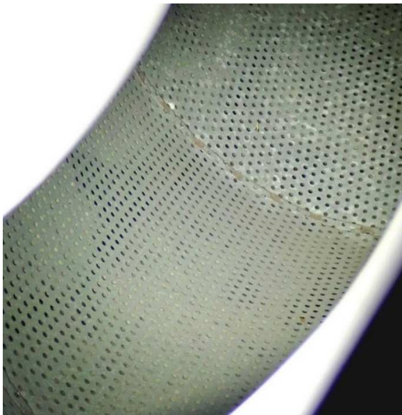
Kuvat 88 ja 89. Vasemmalla näkymä tilan 143 käytöstä poistetun alkuperäisen tuloilmalaitteen takana olevaan tuloilmakanavaan, jonka sisäpinnalla on pinnoittamatonta mineraalivillaa reikäpellin takana. Tiloissa 132 ja 133 vastaavan tyyppiset päätelaitteet ovat käytössä, todennäköisesti myös näiden päätelaitteiden takana on mineraalivillaa tuloilmakanavan sisäpinnalla reikäpellin takana. Oikealla näkyy alkuperäinen tuloilman päätelaite tilassa 132.
