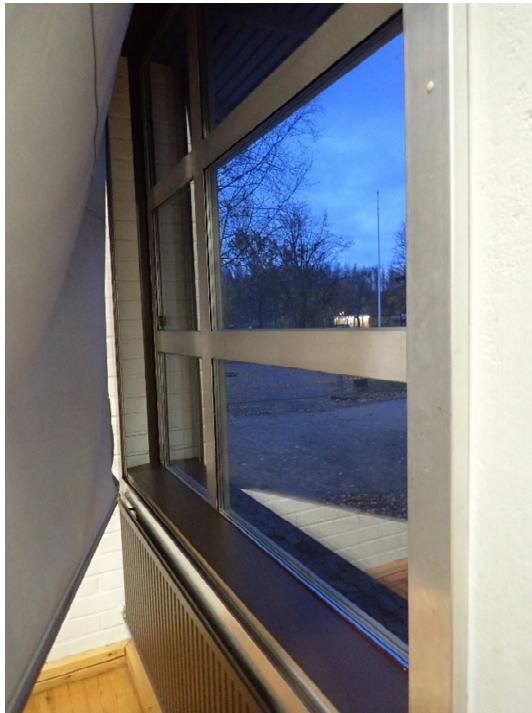
Kuva 30. Liikuntasalin ikkunat ovat kiinteitä metalli-ikkunoita. Ikkunat vaikuttivat hyväkuntoisilta.
