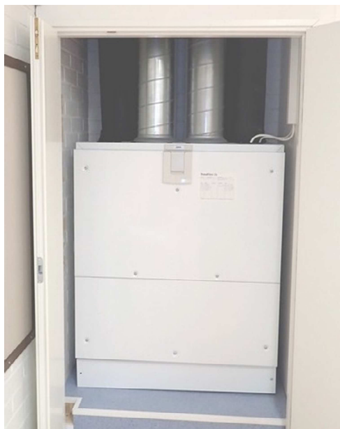
Kuvat 74 ja 75. Ilmanvaihtokone Vallox 280 SE tilassa 118. Ulkoilmanotto sijaitsee vesikatolla.
