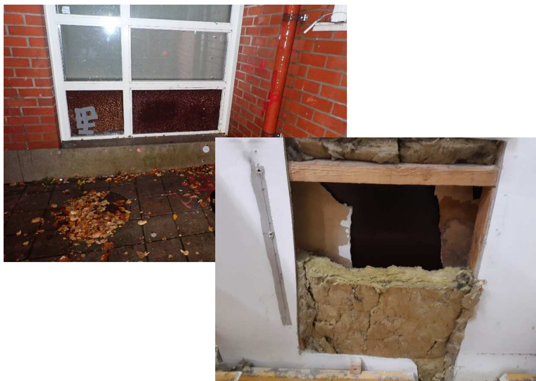
Kuvat 31 ja 32. Liikuntasalin ulkoseinän levyrakenteinen osa on ikkunan alapuolella ja osittain suoraan ikkunan alaosan (ikkunan alimmat, ruskeataustaiset ruudut) kohdalla. Ikkunaruudun takana oleva ruskea levy on maalattu teräsohutlevy. Ylemmässä kuvassa vasen alin ikkunaruutu on hajonnut ja sen kautta suurin osa mikrobivaurion aiheuttamasta vedestä on kulkeutunut ulkoseinärakenteeseen.
