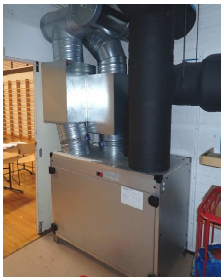
Kuvat 77 ja 78. Ilmanvaihtokone Ilox 297. Ulkoilmasäleikkö sijaitsee ulkoseinällä pihatasolla räystään alla, säleikön epäpuhtauksien määrä oli vähäinen.
