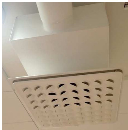
Kuvat 90 ja 91. Näiden tuloilman päätelaiteiden sisäosissa ei todettu mineraalivillaa. Vasemmalla alkuperäinen tuloilman päätelaite. Oikealla v. 2015 asennettu tuloilman päätelaite.
