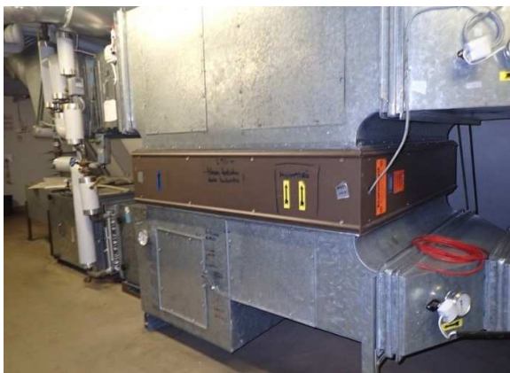
Kuvat 65 ja 66. Ilmanvaihtokone 1TK. Vesikatolla sijaitsevassa ulkoilmanotossa on säältä suojaava rakenne.
