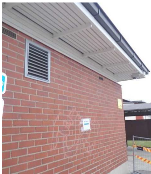
Kuvat 77 ja 78. Ilmanvaihtokone Ilox 297. Ulkoilmasäleikkö sijaitsee ulkoseinällä pihatasolla räystään alla, säleikön epäpuhtauksien määrä oli vähäinen.
