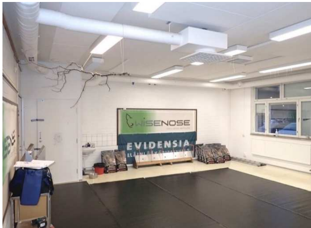
Kuva 92. Tila 134 edustaa tyypillistä tutkittua tilaa, jossa ilmanvaihdon ilmanjako arvioitiin koh- tuulliseksi. Tuloilma jaetaan tilan keskialueelle ja poistoilmaventtiilit sijaitsevat tilan eri reunoilla. Savun avulla todettiin, että tuloilma kulkeutuu melko hyvin tilojen keskialueelta tilojen reunoille asti.
