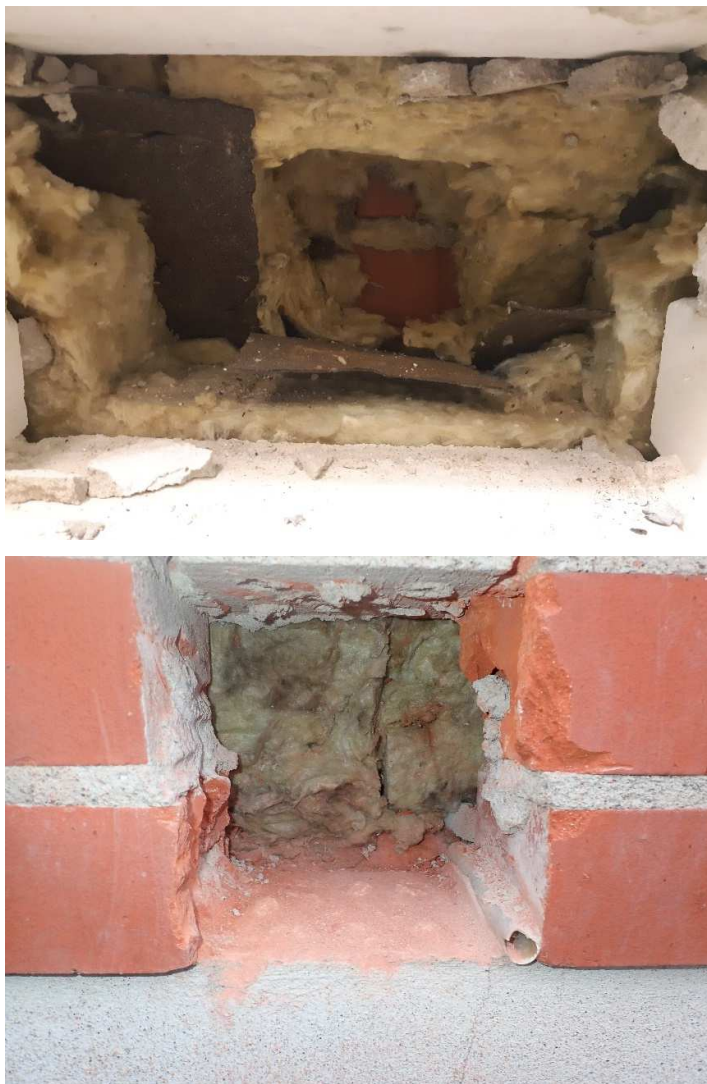
Kuvat 33 ja 34. Ulkoseinärakenteet ovat valtaosin tiili-villa-tiili -rakenteisia. Ulkoseinärakenteet ovat pääosin hyväkuntoisia. Ulkoseinärakenteessa ei ole tuuletusrakoa ja muuraukseen asennetut tuuletusputket ovat suurimmaksi osaksi tukittu.
