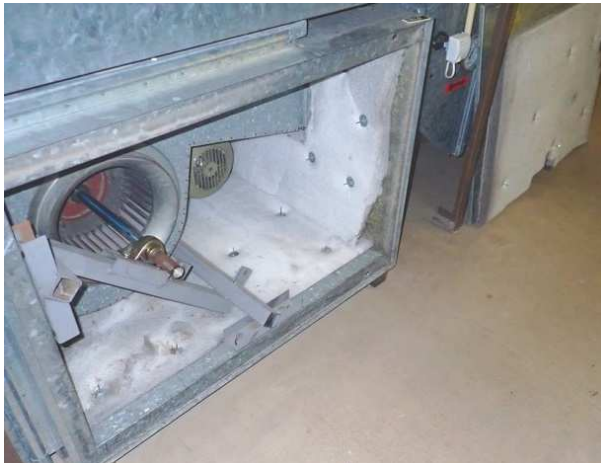
Kuva 73. Tulo- ja poistoilmapuhaltimet ovat hihnakäyttöisiä, hihnat olivat kunnossa. Puhallinosissa kotelon sisäpuolisena vaimennuksena polyesterimateriaali.
