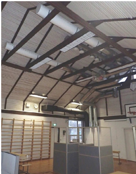
Kuvat 93 ja 94. Tilan 143 ilmanvaihdon ilmajako on puutteellista. Tuloilman suutinkanavista puhallus on vaakatasoon molempiin suuntiin, jolloin osa tuloilmasta kulkeutuu suoraan poistoilmakanavaan. Ku- vaan on hahmoteltu nuolilla tuloilman puhallusta. Sisäilman ja tuloilman lämpötilat olivat melkein yhtä suuret, jolloin tuloilma ei laskeudu tilan yläosasta alas oleskeluvyöhykkeelle.
