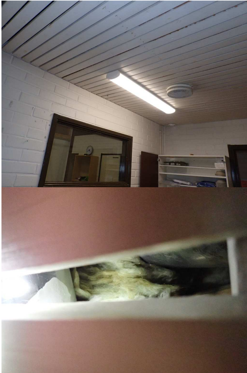
Kuvat 53 ja 54. Alakattomateriaalina on paikoin käytetty lautta, joka on aiempien tutkimusten (Sweco 2014) perusteella painekyllästettyä. Paikoin alakattorakenteen yläpuolella oli havaittavissa pinnoittamatonta mineraalivillaa.
