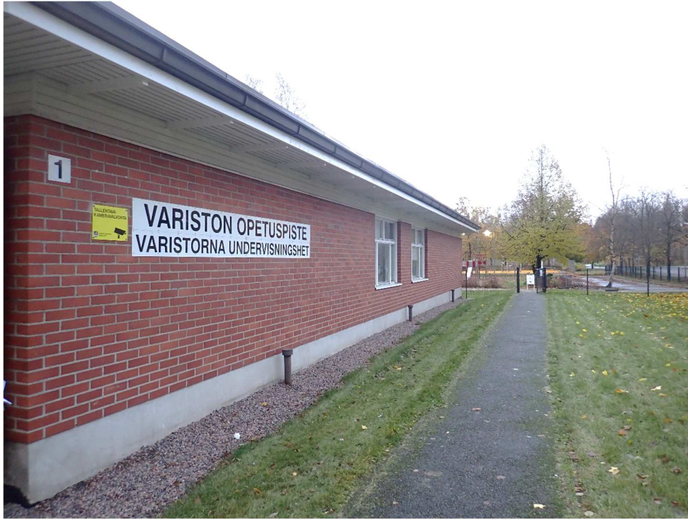
Kuva 59. Julkisivu lounaaseen. Maan pinta viettää selkeästi rakennukseen päin. Maan on nurmi-pintainen. Sokkelin vieressä on sorastus.
