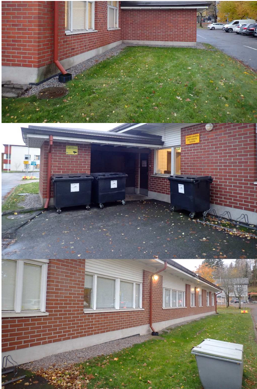
Kuvat 56, 57 ja 58. Julkisivu luoteeseen. Rakennuksen pohjoisnurkassa kaadot ovat vähäisiä. Asfalttialueella roskakatoksen vieressä ne kaadot ovat suurempia. Muuten luoteisjulkisivulla maan pinta kaataa poispäin rakennuksesta välittömästi sorastuksen vieressä, mutta kauempaa rakennuksesta maa viettää rakennusta kohti ja vesi kerääntyisi uraan, joka on noin kahden metrin päässä rakennuksesta.
