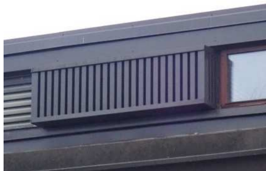
Kuvat 65 ja 66. Ilmanvaihtokone 1TK. Vesikatolla sijaitsevassa ulkoilmanotossa on säältä suojaava rakenne.
