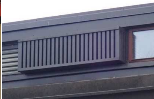
Kuvat 70 ja 71. Ilmanvaihtokone 2TK. Vesikatolla sijaitsevassa ulkoilmanotossa on säältä suojaava rakenne.
