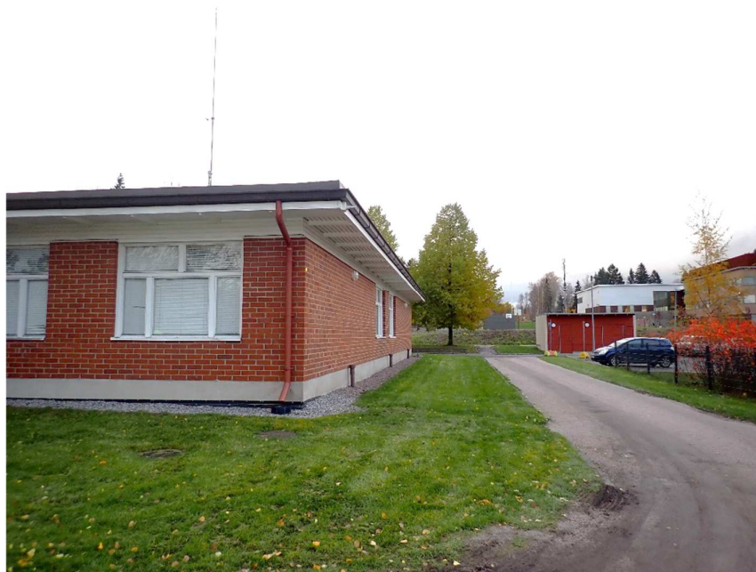
Kuva 55. Julkisivu koilliseen. Maan pinta viettää hieman poispäin rakennuksesta, mutta kaato on heikko. Maan on nurmipintainen. Sokkelin vieressä on sorastus.
