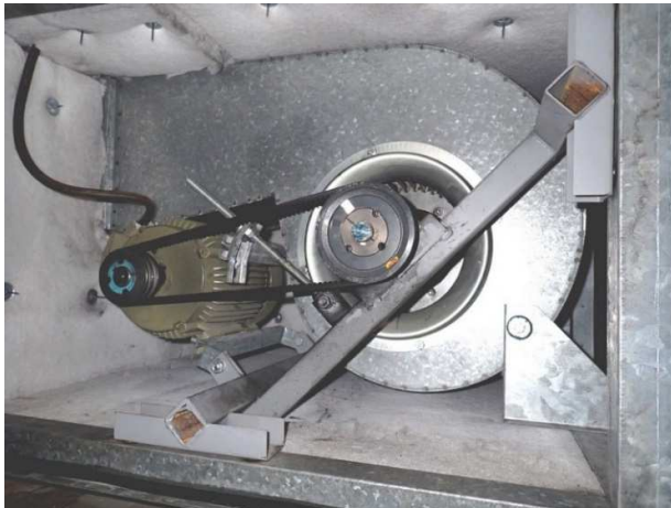
Kuva 69. Tulo- ja poistoilmapuhaltimet ovat hihnakäyttöisiä, hihnat olivat kunnossa. Puhallinosissa kotelon sisäpuolisena vaimennuksena polyesterimateriaali.
