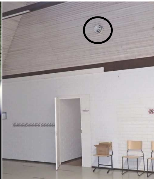
Kuvat 88 ja 89. Vasemmalla näkymä tilan 143 käytöstä poistetun alkuperäisen tuloilmalaitteen takana olevaan tuloilmakanavaan, jonka sisäpinnalla on pinnoittamatonta mineraalivillaa reikäpellin takana. Tiloissa 132 ja 133 vastaavan tyyppiset päätelaitteet ovat käytössä, todennäköisesti myös näiden päätelaitteiden takana on mineraalivillaa tuloilmakanavan sisäpinnalla reikäpellin takana. Oikealla näkyy alkuperäinen tuloilman päätelaite tilassa 132.
