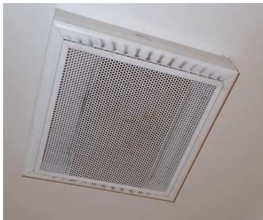
Kuvat 90 ja 91. Näiden tuloilman päätelaiteiden sisäosissa ei todettu mineraalivillaa. Vasemmalla alkuperäinen tuloilman päätelaite. Oikealla v. 2015 asennettu tuloilman päätelaite.
