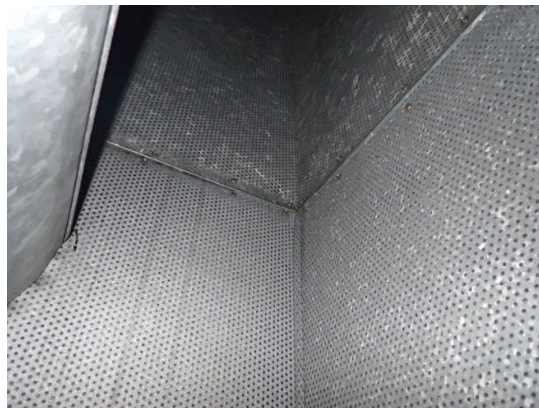
Kuvat 86 ja 87. IV-konehuoneessa 201 heti ilmanvaihtokoneiden 1TK ja 2TK jälkeen olevissa suoraikiteen muotoisissa tuloilmakanavissa on reikäpellin takana pinnoittamatonta mineraalivillaa. Vasemmalla kanava koneen 1TK jälkeen ja oikealla kanava koneen 2TK jälkeen.
