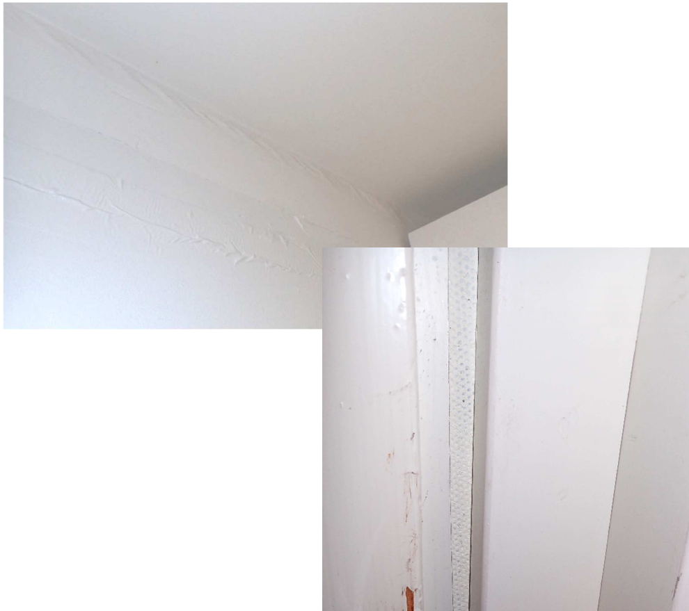
Kuvat 35 ja 36. Luokahuoneiden ja henkilökunnan tilojen ulkoseinäliittymät ylä- ja alapohjaan sekä ikkunakarmien liittymät ulkoseinään on tiivistetty teipillä. Em. tiloissa myös väliseinien liittymät ylä- ja alapohjaan on tiivistetty teippaamalla. Muissa tiloissa ei ole tehty tiivistyksiä.
