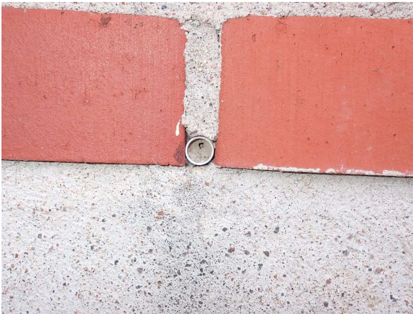
Kuva 25 ja 26. Sokkeliharkon rappaus ulottuu suurimmaksi osaksi sepelin tasolle, mutta pohjoisnurkalla maanpinnan tasoa on laskettu ja patolevy on paljastunut. Julkisivumuurauxsen alimmassa rivissä on noin joka kolmannessa saumassa tuuletusputki. Tuuletusputket ovat tukittu tiivistysmassalla.
