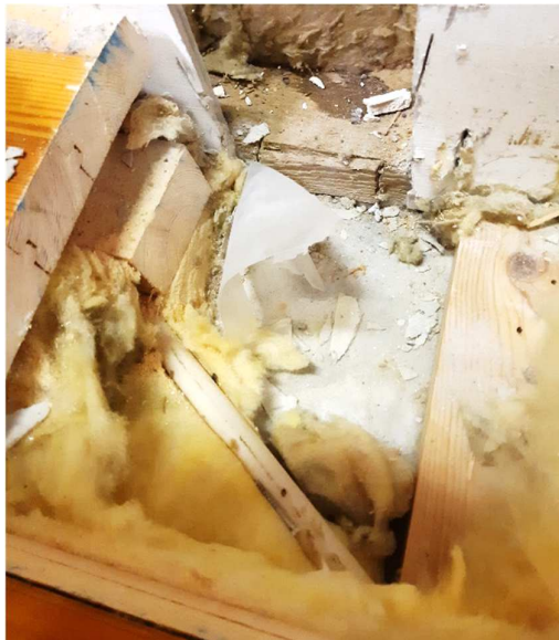
Kuva 4 . AP3 lankkulattian rakenneavaus.
