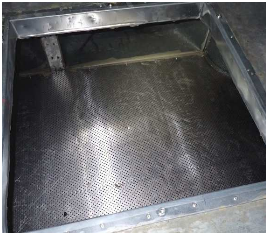
Kuvat 86 ja 87. IV-konehuoneessa 201 heti ilmanvaihtokoneiden 1TK ja 2TK jälkeen olevissa suoraikiteen muotoisissa tuloilmakanavissa on reikäpellin takana pinnoittamatonta mineraalivillaa. Vasemmalla kanava koneen 1TK jälkeen ja oikealla kanava koneen 2TK jälkeen.
