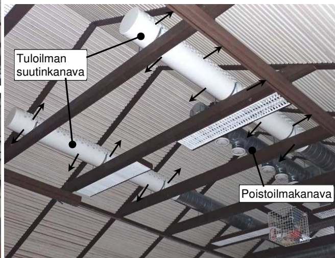
Kuvat 93 ja 94. Tilan 143 ilmanvaihdon ilmajako on puutteellista. Tuloilman suutinkanavista puhallus on vaakatasoon molempiin suuntiin, jolloin osa tuloilmasta kulkeutuu suoraan poistoilmakanavaan. Ku- vaan on hahmoteltu nuolilla tuloilman puhallusta. Sisäilman ja tuloilman lämpötilat olivat melkein yhtä suuret, jolloin tuloilma ei laskeudu tilan yläosasta alas oleskeluvyöhykkeelle.
