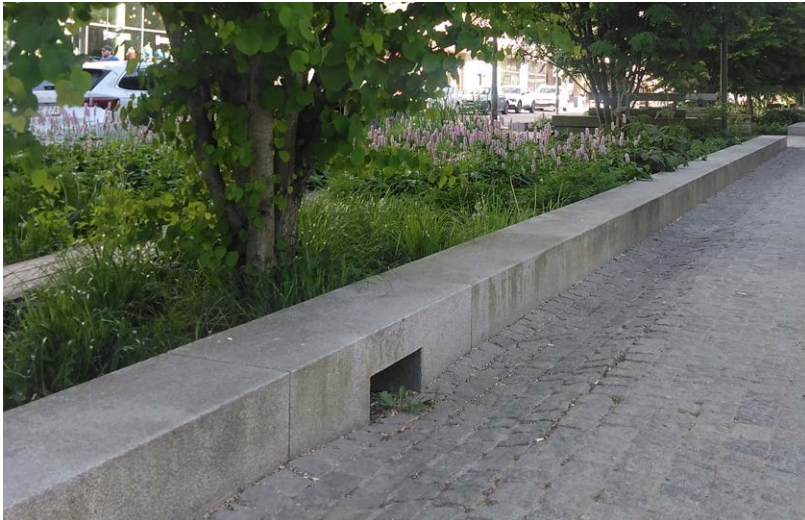
Esimerkkikuva muurin aukotuksesta hulevesien johtamiseksi
