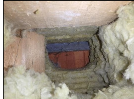
Kuva 35. Avauksessa ei havaittu näkyviä vaurioita.
