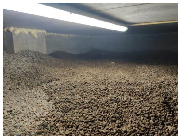
Kuva 3. Ryömintätila, siisti ja puhdistettu aikaisemmin todetuista roskista ja rakennusjätteistä.
