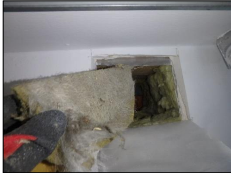
Kuva 34. Ulompi lämmöneristekerros on toteutettu kovalla mineraalivillalla, jonka ulkopinnassa on lasikuitukangas.
