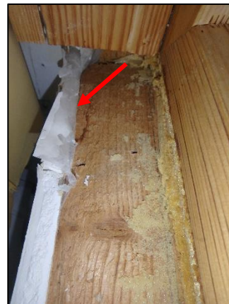
Kuva 79. Alakarmin kohdalla seinärakenteessa oleva muovikalvo on näkyvissä.
