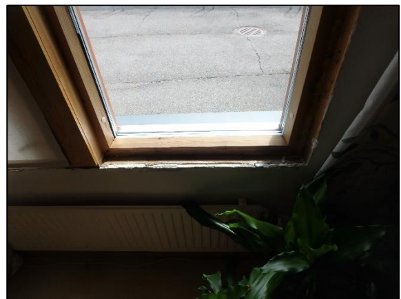
Kuva 87. Avaus toteutettiin avaamalla ikkunalistoja alakarmin ja oikean pystykarmien kohdalta.
