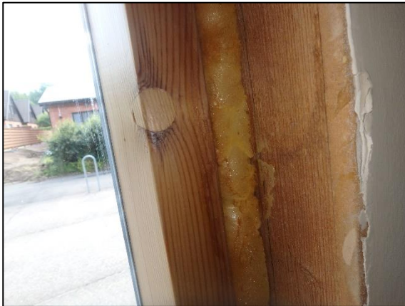
Kuva 84. Ikkunatilkkeenä on käytetty polyuretaanivaahdotusta.
