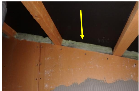
Kuva 115. Alaslaskettua kattoa raottamalla oli havaittavissa yläpohjan mineraalivillaeristeitä.
