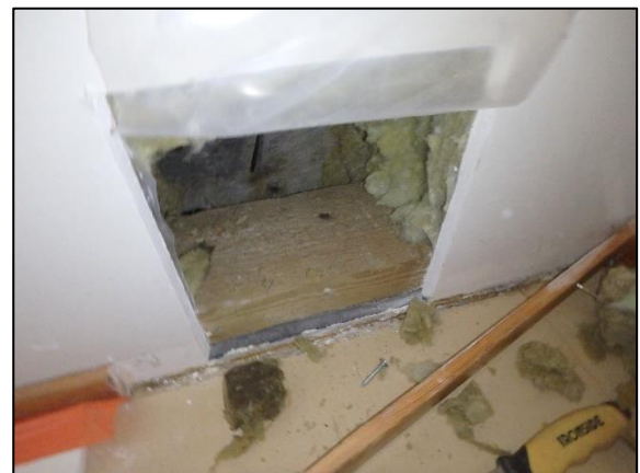
Kuva 49. Avauksessa ei havaittu näkyviä vaurioita.
