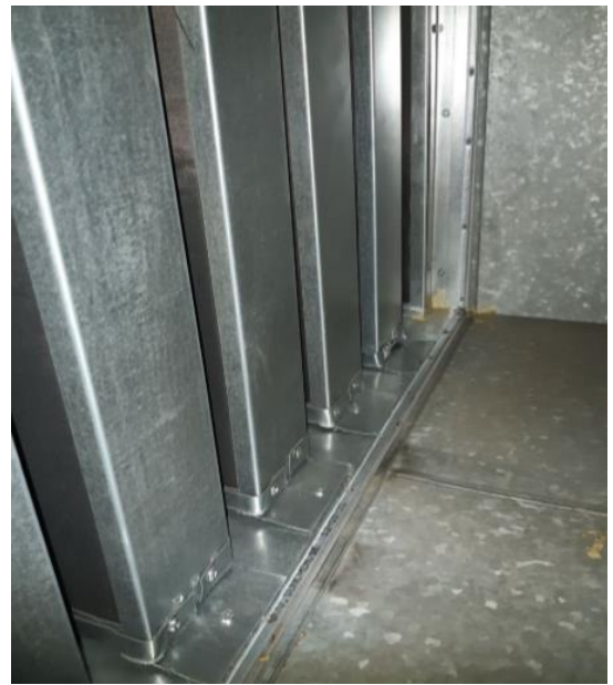
Kuva 102. Ilmanvaihtokoneen äänenvaimennin.
