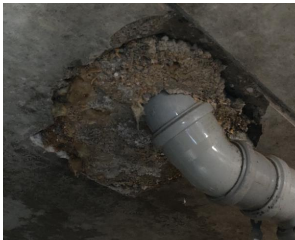
Kuva 7. Alapohjan läpivienti tiivistetty mineraalivillalla.
