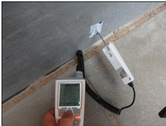
Kuva 75. Rakenneavaus 22 toteutettiin sokkelirakenteeseen ulkokautta porareikämenetelmällä.
