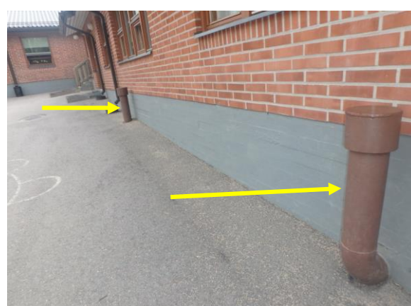
Kuva 1. Ryömintätilan tuuletusputkia.
