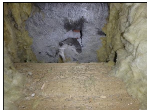
Kuva 64. Alaohjauspuun alle asennettu bitumikermi on nostettu ulkoseinälle.
