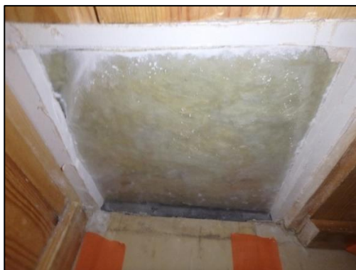
Kuva 63. Rakenneavaus 14. Kipsilevyn ja eristeen välissä on muovikalvo.
