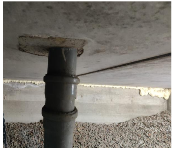
Kuva 6. Alapohjan ja ulkoseinän/sokkelin liitoksia tiivistetty uretaanivaahdolla.
