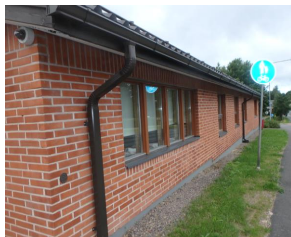
Kuva 23. Yleiskuva rakennuksesta koillisen puolelta.
