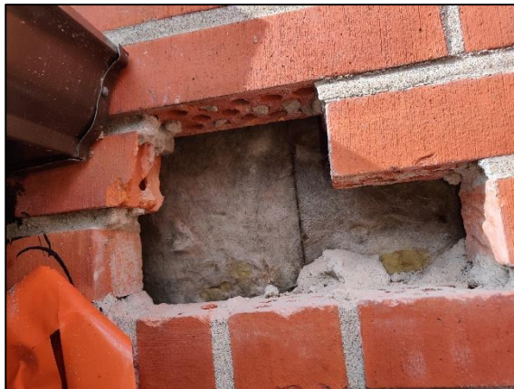
Kuva 69. Rakenneavaus 20 toteutettiin seinän yläosaan räystäään läheisyyteen.
