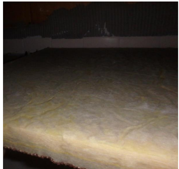
Kuva 113. Pinnoittamaton alaslaskettua kattoa.
