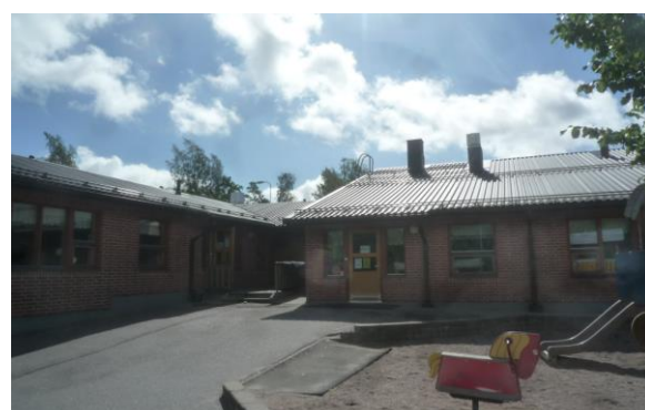
Kuva 21. Yleiskuva rakennuksesta lännen puolelta.
