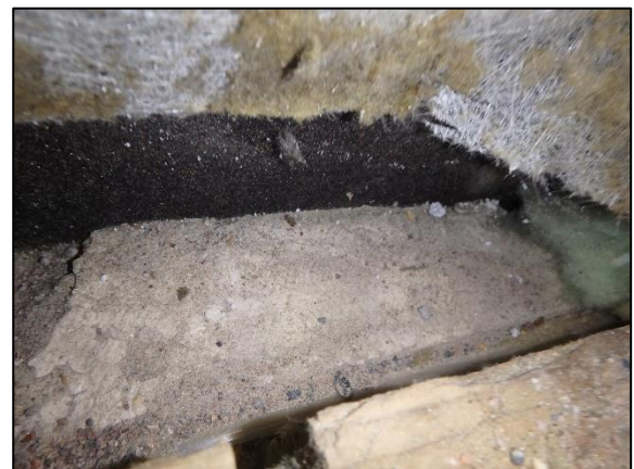
Kuva 38. Kapillaarikatkona oleva bitumikermi on nostettu tiiliverhouksen taustapinnalle.
