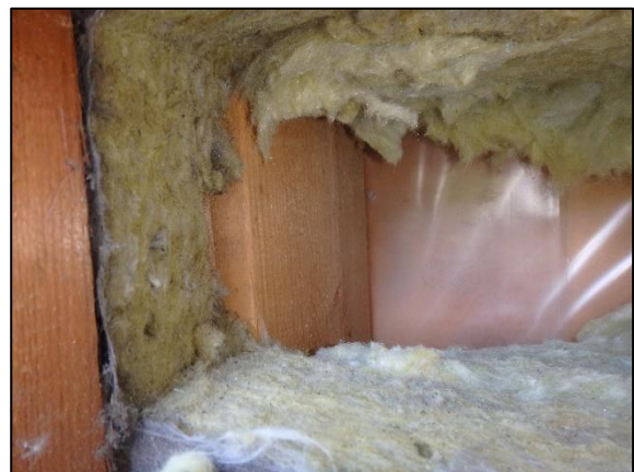
Kuva 61. Avauksessa ei havaittu näkyviä vaurioita.
