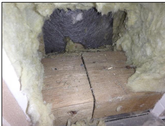
Kuva 45. Avaus 6. Avauksessa ei näkyviä vaurioita.
