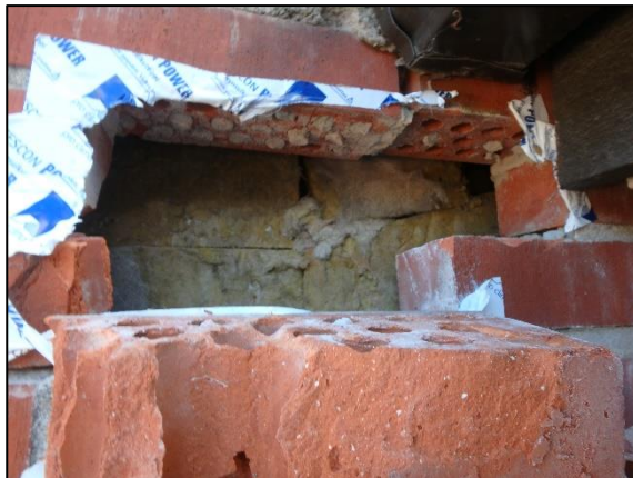
Kuva 72. Rakenneavaus 21 toteutettiin seinän yläosaan räystäään läheisyyteen.
