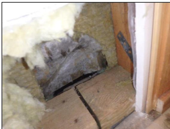
Kuva 37. Rakenneavaus 2. Avauksessa ei havaittu näkyviä vaurioita.
