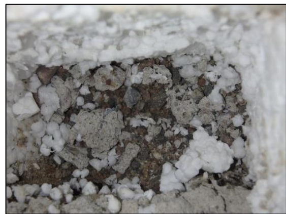
Kuva 11. Alapohjan alustäytönä on hienojakoista hiekkaa tai soraa.
