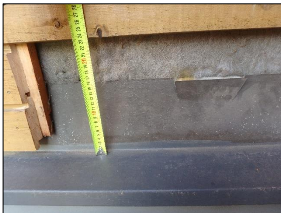
Kuva 60. Rakenneavaus 12. Tippapelti on nostettu paneloinnin takana 150 mm seinärakenteelle.
