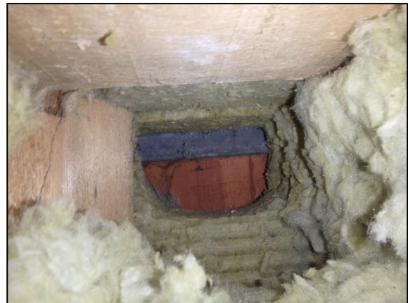
Kuva 55. Avauksessa ei havaittu näkyviä vaurioita.
