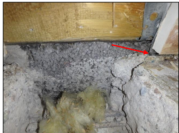
Kuva 17. Seinärakenteen muovikalvo päättyy pintalaatan yläpintaan
