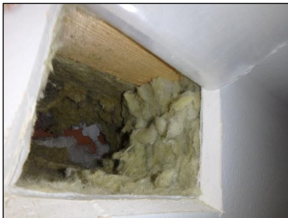
Kuva 66. Rakenneavaus 15 ulotettiin tiiliverhoilun sisäpintaan.
