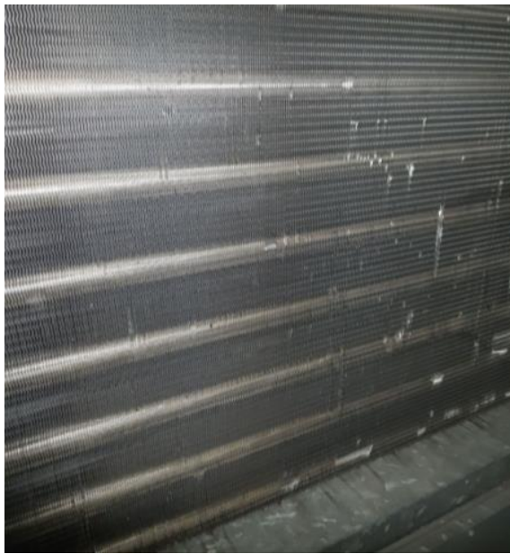
Kuva 101. Lämmityspatteri oli siisti ja puhdas.
