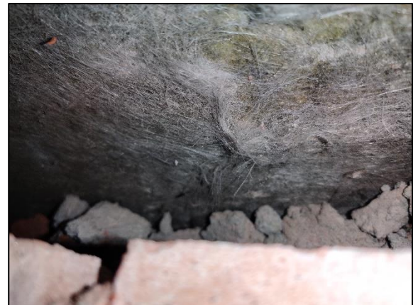
Kuva 70. Avauksessa ei havaittu näkyviä vaurioita. Ilmarako on ainakin osittain täytynyt muurauslaastipurseista.
