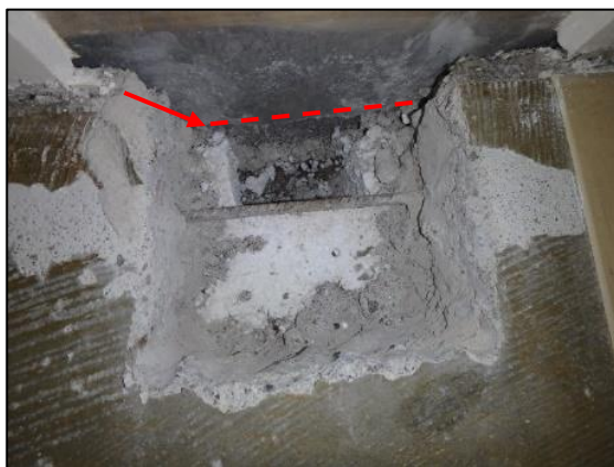
Kuva 10. Rakenneavaus 4 toteutettiin alapohjarakenteen läpi. Ulkoseinän muovikalvo on tuotu sokkelirakenteelle pintalaatan korkeudella.
