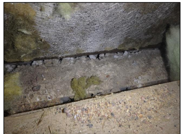
Kuva 43. Sokkelin lämmöneristeinä on käytetty EPS-eristettä.
