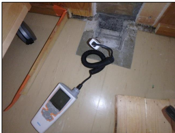
Kuva 16. Rakenneavaus 10 toteutettiin alapohjarakenteeseen ulkoseinärakenteen vierustalle.
