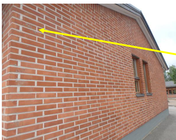
Kuva 24. Yleiskuva rakennuksesta luoteen puolelta.
