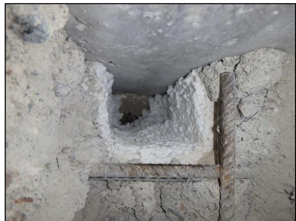
Kuva 14. Seinärakenteen muovikalvo on viety kantavan laatan yläpintaan.
