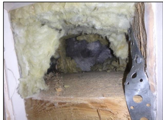
Kuva 58. Avauksessa ei havaittu näkyviä vaurioita.
