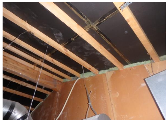
Kuva 95. Alaslasketun katon kautta arvioiden, yläpohjan rakenteet olivat siistit eikä niissä ollut havaittavissa viitteitä kosteus- ja mikrobivaurioista.
