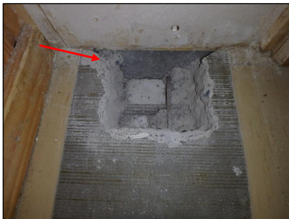
Kuva 13. Rakenneavaus 13 toteutettiin alapohjarakenteeseen ulkoseinärakenteen vierustalle.
