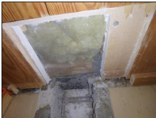
Kuva 57. Rakenneavaus 11 toteutettiin ulkoseinän alaosaan lattiarajaan.
