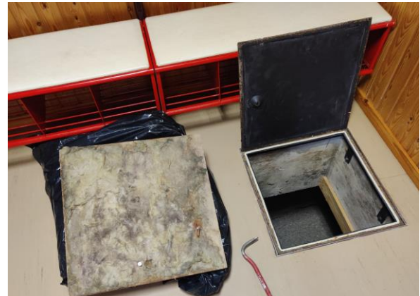
Kuva 2. Eteisessä 32 on alapohjassa luukku ryömintätilaan. Luukun kannen alla oli mineraalivillaa jätesäkkiin käärittynä ja tämän alla vielä toinen kansi.
