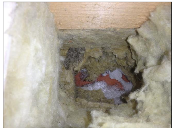
Kuva 67. Avauksessa ei havaittu näkyviä vaurioita. Ilmarako on ainakin osittain täytynyt muurauslaastipurseista.
