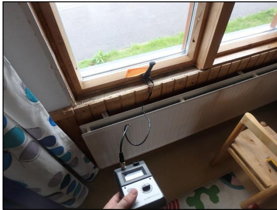
Kuva 88. Ikkunarakenteen avaus tilassa 01.
