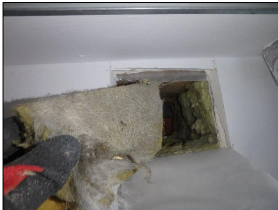
Kuva 54. Ulompi lämmöneristekerros on toteutettu kovalla mineraalivillalla, jonka ulkopinnassa on lasikuitukangas.
