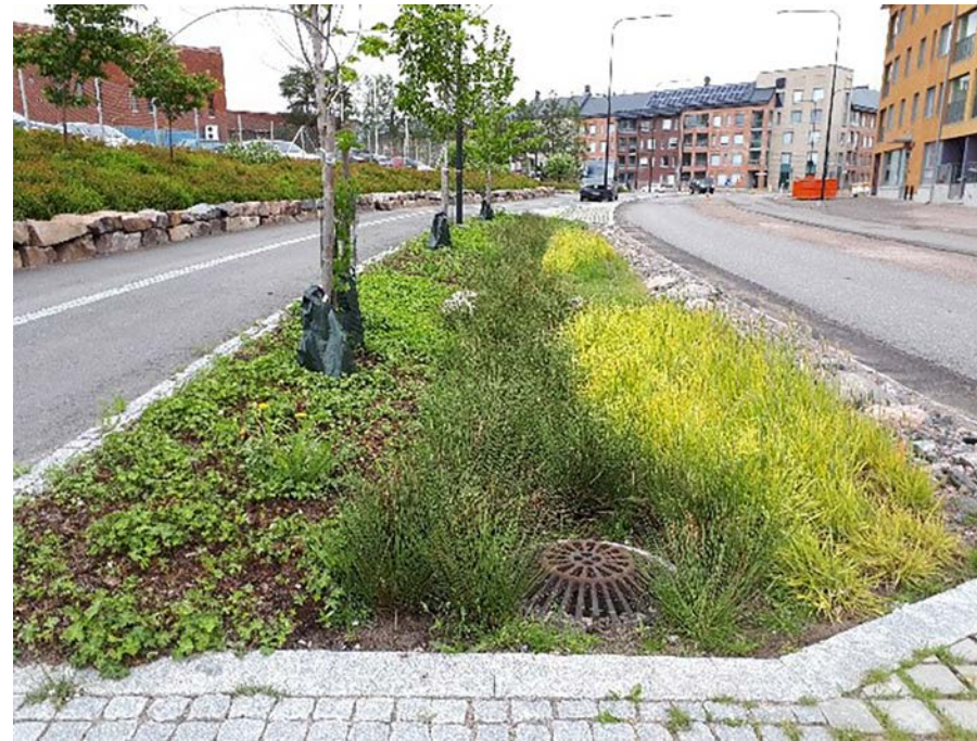
Kuva 34. Kuninkaantammen biosuodatusrakenteet. Vedet ohjataan rakenteeseen kitakaivon kautta (kuva vasemmalla) sekä ylivuotokaivo (kuva oikealla).
