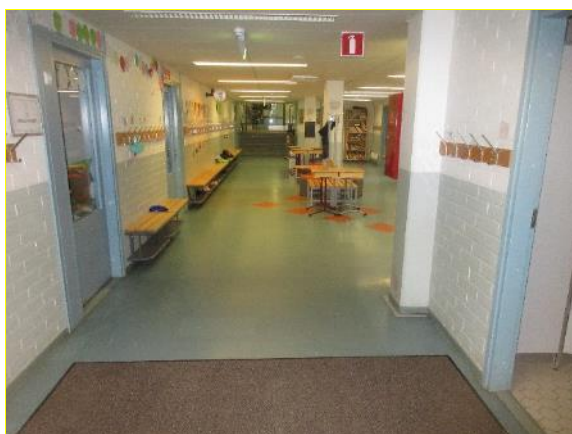
Kuva 5.2. Yleiskuva käytävien lattiapäällysteistä.
