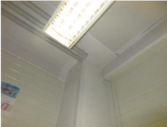
Kuva 8.1. Luokan 101 nurkassa on levytetty putkikotelo.
