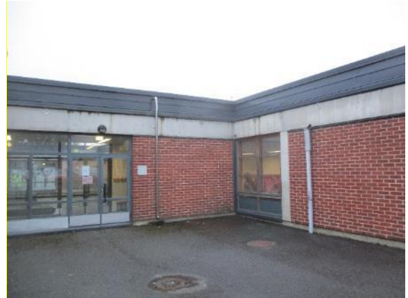
Kuva 4.2. Rakennuksen etelän puoleisen sisäänkäynnin kohdalla on myös matala sokkeli.
