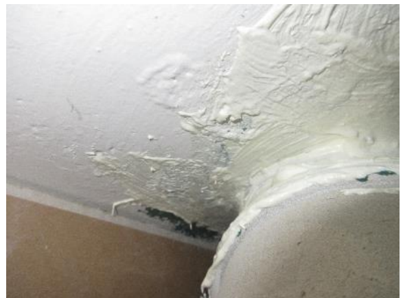
Kuva 8.4. Yläpohjan läpivienti on tiivistetty.
