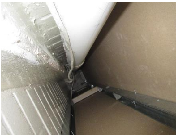
Kuva 8.3. Kotelo on metallirankainen ja kipsilevytetty. Kipsilevyissä ei todettu viitteitä kosteus-/mikrobivaurioista.
