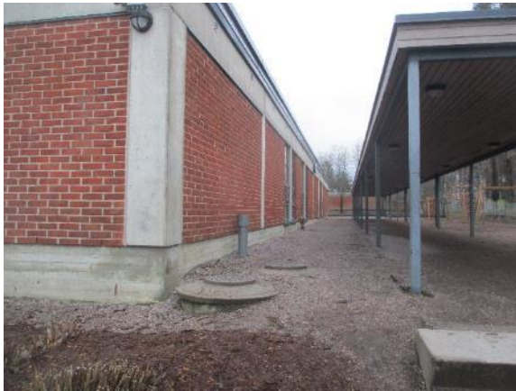
Kuva 4.7. Yleiskuva rakennuksen etelän puoleiselta julkisivulta. Rakennuksen vierustana on hiekkaa.
