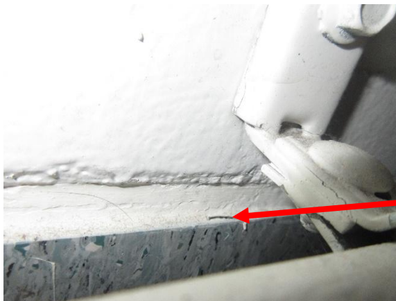
Pistemäisiä ilmavuotoja tiilisaumoista (useampi kohta)
