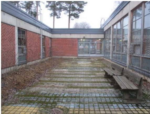
Kuva 4.5. Yleiskuva idän puoleiselta valopihalta.
