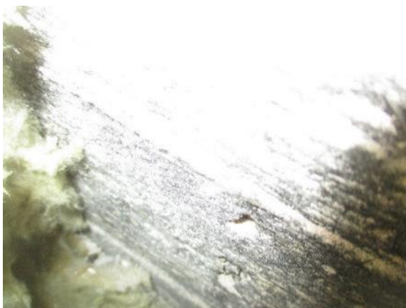
Kuva 6.4. RA.08-US. Sokkelin sisäpinnassa on sively. Sively ei sisällä asbestia tai PAH-yhdisteitä.
