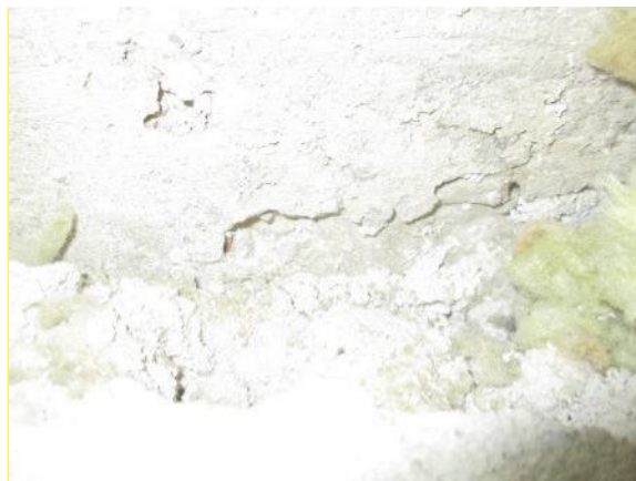
Kuva 6.7. RA.11-US. Sokkelin sisäpinnassa ei todettu bitumisivelyä.
