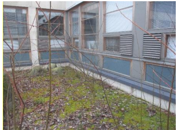
Kuva 4.6. Yleiskuva lännen puoleiselta valopihalta.
