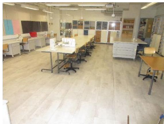
Kuva 5.5. Tekstiilityön luokassa on lattiapäällysteenä vinyylilankku.
