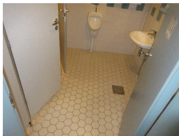
Kuva 5.3. Yleiskuva WC-tilojen lattiapäällysteistä.
