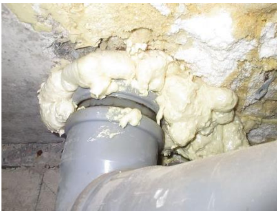
Kuva 5.12. Alapohjarakenteen läpivientejä on tiivistetty uretaanilla.
