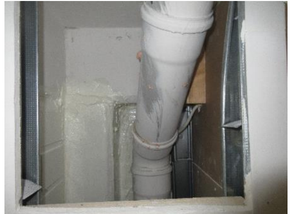
Kuva 8.2. Putkikotelossa kulkee sadevesiviemäri.
