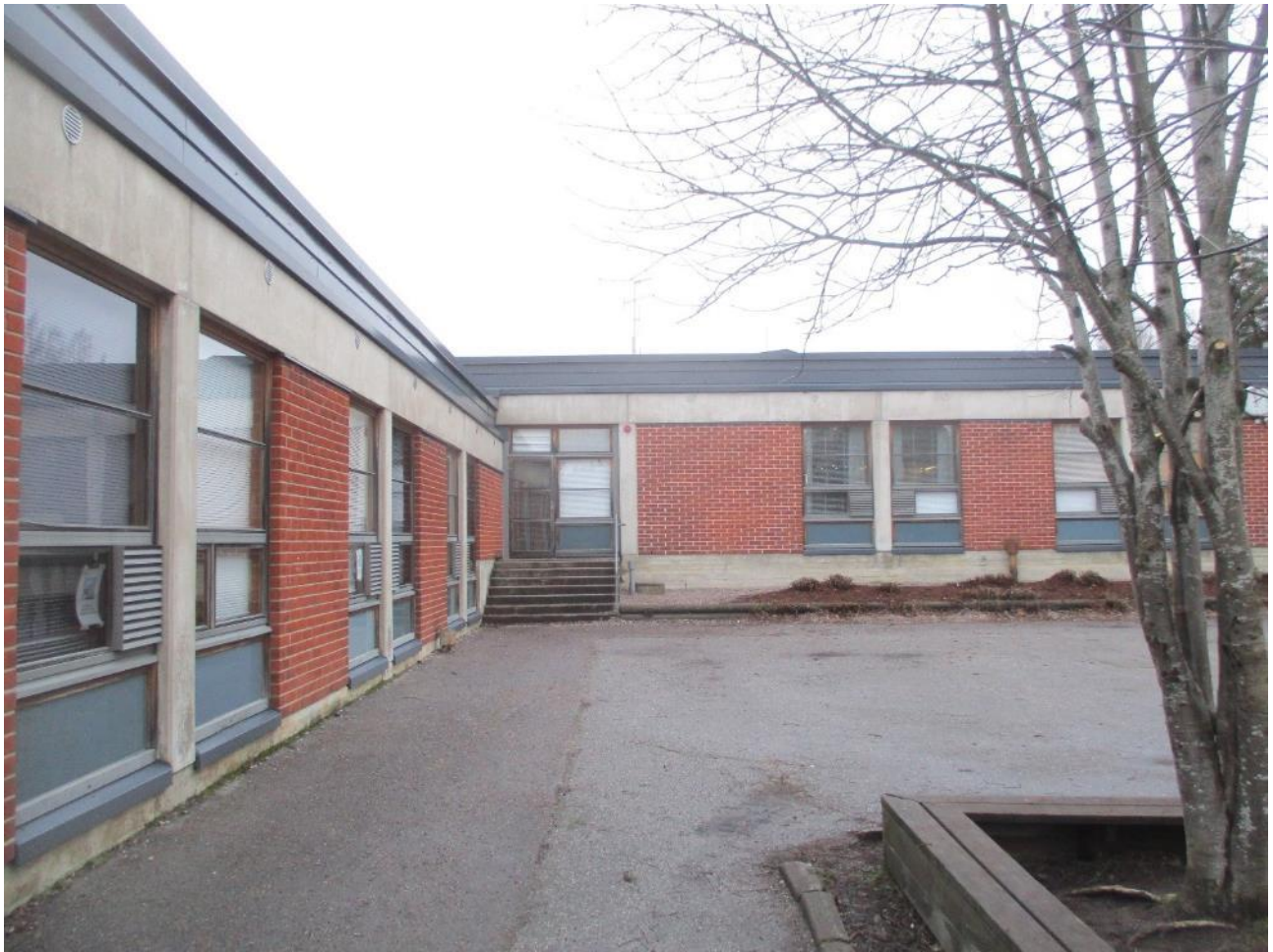
Kuva 3.2 Yleiskuvaa pihan puolelta.
