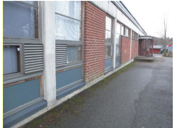
Kuva 4.8. Havaintojen ja saatujen lähtötietojen perusteella ikkunat ovat uusittu perusparannuksen yhteydessä. Ikkunoiden vesipeltien kaa-doissa ei havaittu puutteita.
