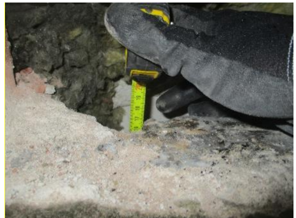
Kuva 6.3. RA.03-US. Mineraalivilla jatkuu n. 200 mm sokkelin alapuolelle. Sokkeli on n. 200 mm ympäröivää maan pintaa ylempänä.
