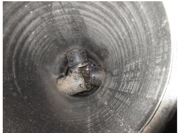
Kuva 5.11. Ryömintätilassa sijaitsee salaojien tarkastuskaivoja
