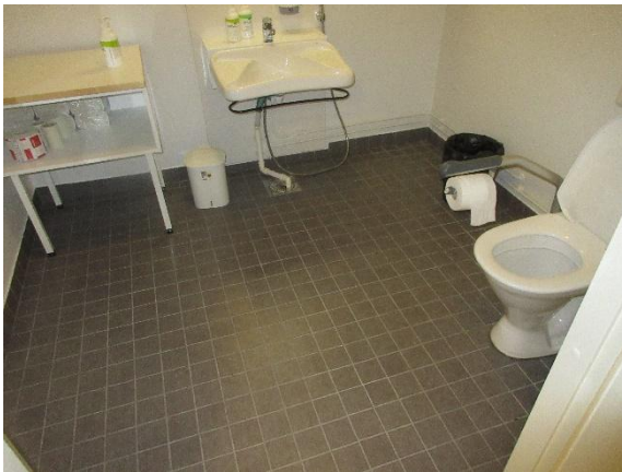
Kuva 5.4. Yleiskuva wc-tilan lattiapäällysteistä.
