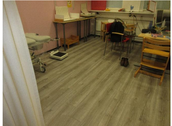
Kuva 5.3. Yleiskuva huonetilojen lattiapäällysteistä.
