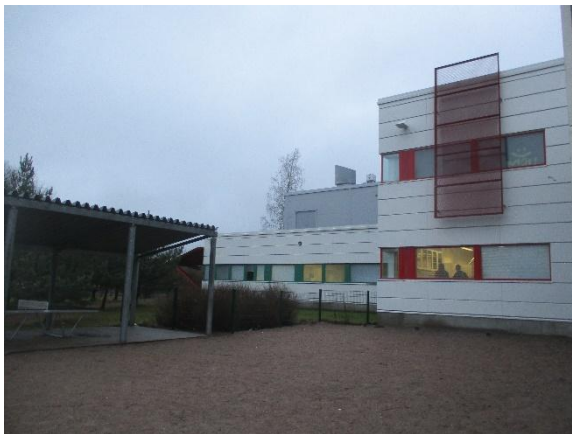
Kuva 4.1. Yleiskuva rakennuksen länsipäädyästä
