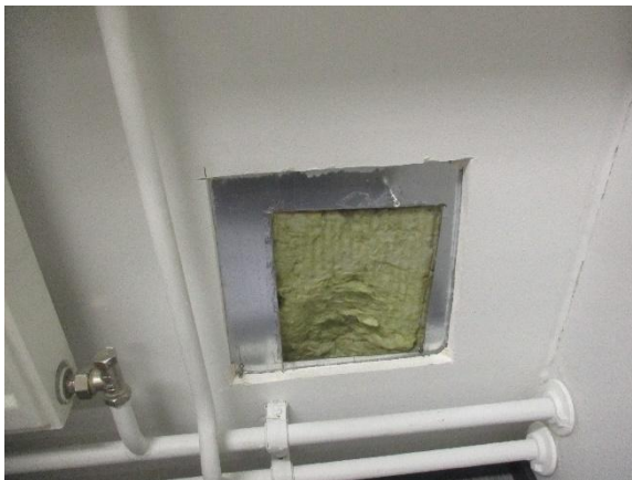
Kuva 6.4. Sisäpuolelta tehtiin avaus rakenteen alaosaan (RA.12-US). Rakenneavauksesta ei saatu tarkastettua onko sisäverhouslevyn takana olevan metallilevyjen saumoja teipattu.
