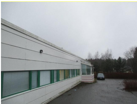
Kuva 4.3. Yleiskuva pohjoisen puoleisesta julkisivusta
