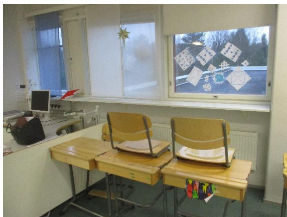
7.1. Yleiskuva luokan 2008 ulkoseinästä.
