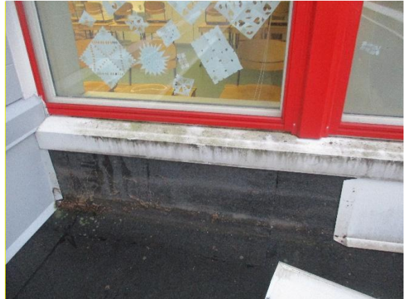
Kuva 6.7. RA.16-US. Luokan 2008 vesikattoon rajoittuvan ulkoseinärakenteen rakenneavaus. Vesikaton vedeneristeen ylösnosto jatkuu ikku- naan saakka (>400 mm).
