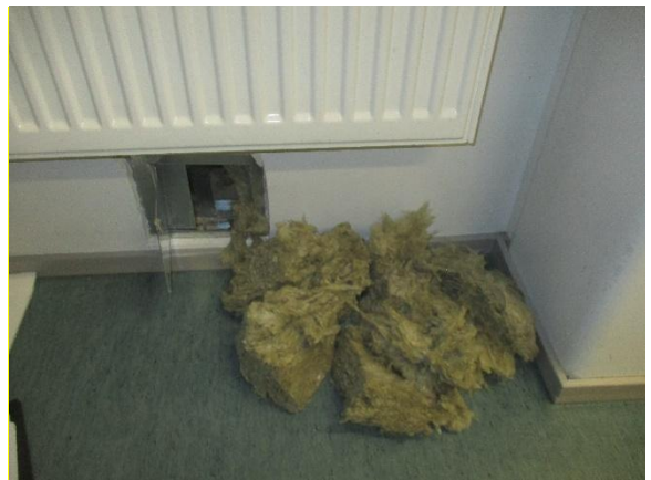
Kuva 6.9. Luokan 2008 ulkoseinärakenteeseen toteutettiin sisäpuolinen rakenneavaus (RA.14- US).
