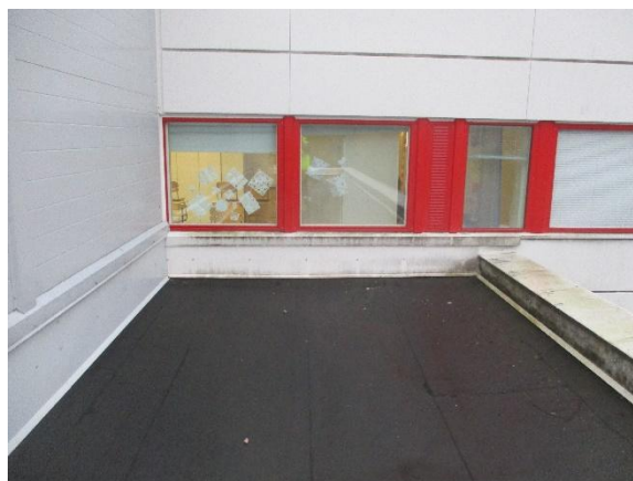
7.2. Vastaava kohta vesikaton puolelta.
