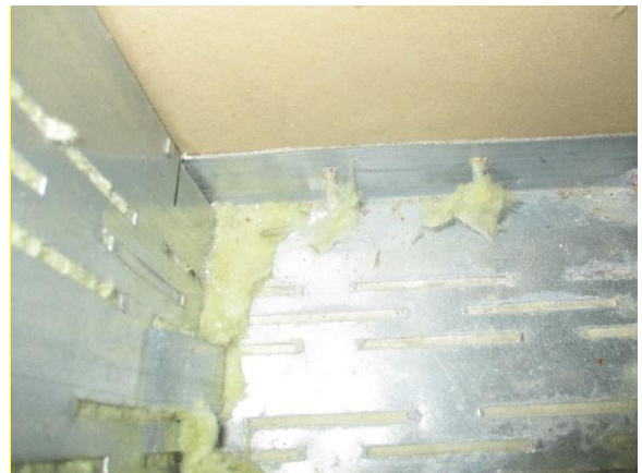
Kuva 6.5. RA.12-US. Ulkoseinärakenteen metalliosissa ei todettu viitteitä kosteusrasituksesta tai mikrobivaurioon viittaavaa tuoksua.
