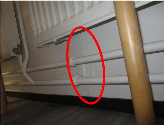
Kuva 6.14. Kupruilua saumanauhan kohdalla (huone 1009).
