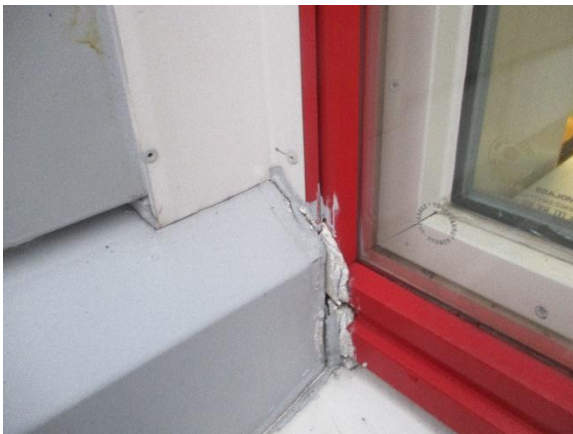
Kuva 6.8. RA.16-US. Peltilistojen elastiset mas- sat ovat rakoilleet.
