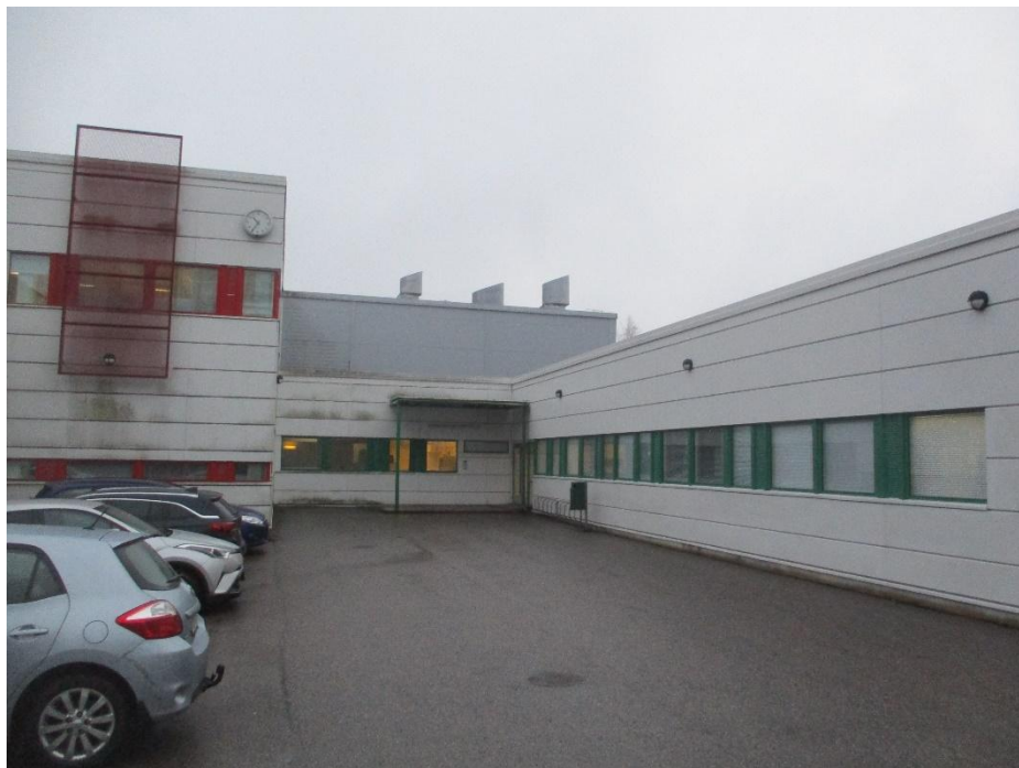
Kuva 3.2 Yleiskuvaa terveyssiiven etelän puoleisen pihan puolelta.
