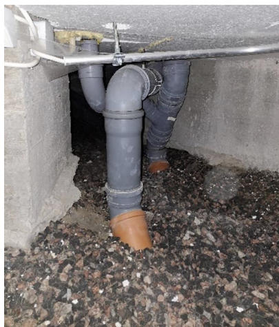
Kuva 68 Murske on kosteaa luukun lähellä.
