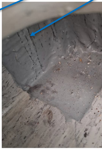
Pilarin juuria on jo aiemmin tiivistyskorjattu.
