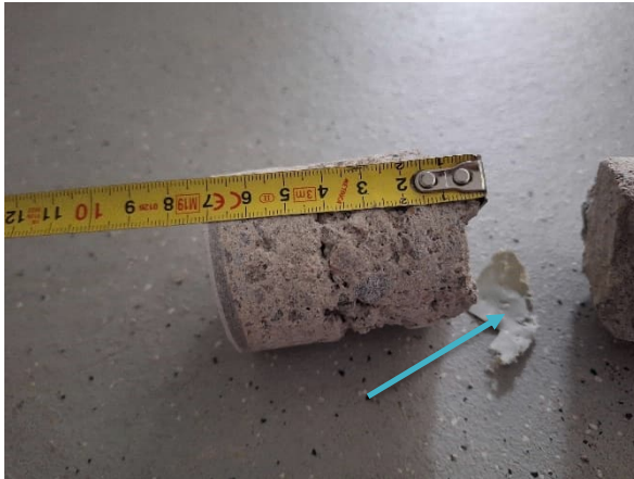
Kuva 40 Pintalaatan paksuus on 70 mm. Betonien välissä on muovia.
