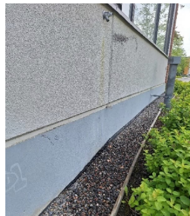
Kuva 13 A-osan laajennusosan sorakaistaletta.
