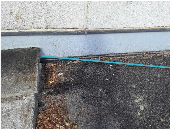
Kuva 16 Suojamuurilevy päättyy katoksen alla olevan luiskan kohdalla.
