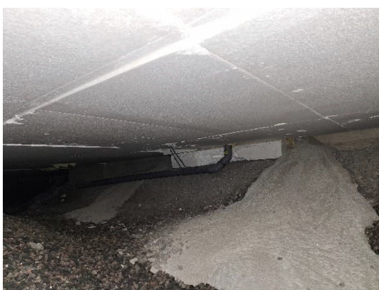
Kuva 70 Alustatilaan on syötetty ylimäärävalua betonikuormasta.
