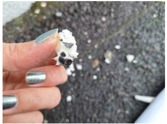
Kuva 84 US6, eristeenä polyuretaania, josta ei tutkittu mikrobeja.
