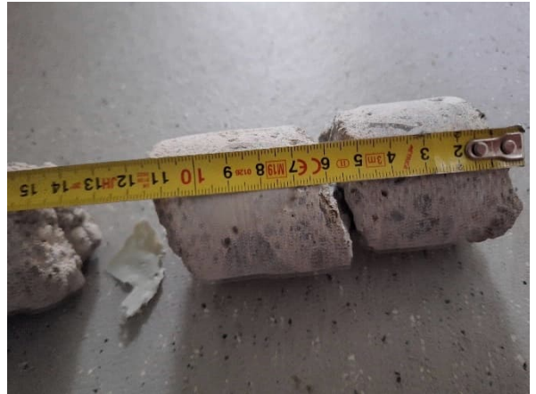
Kuva 41 Kantavan betonilaatan paksuus on 110 mm.
