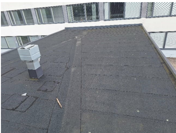
Kuva 105 Yleiskuva rakennusosien yhdyskäytä- vän vesikatteesta.
