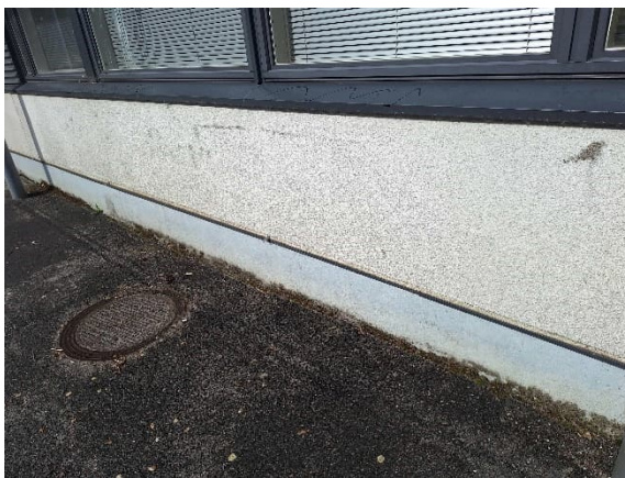
Kuva 10 Rakennuksen sisäpihaa, joka on asfaltoitu.
