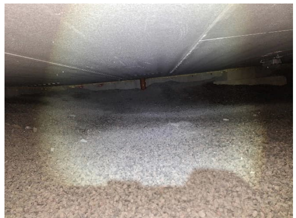
Kuva 69 Yleiskuva alustatilasta. Murske on kuivaa. Murskekerros nousee väliseiniä ja pilareiden kohdilla korkeammalle.
