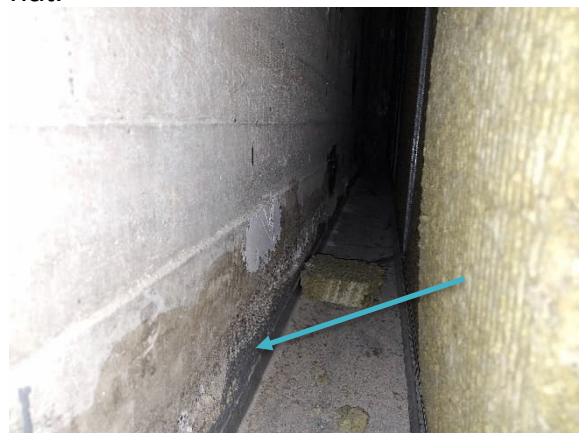
Kuva 92 Vanhan ulkoseinän eteen on lisätty uudempi seinärakenne: ilmarako, villaeristys ja metalliranka, kipsilevy. Ulkoseinän ja lattian rajalla oli harmaa eristys.
