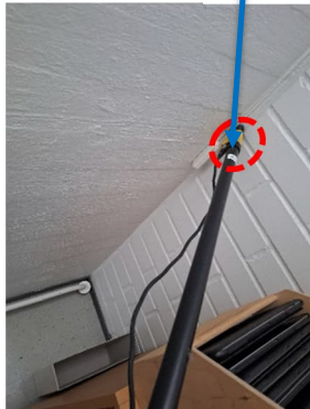
Selvää ilmavuotoa väliseinän kulmauksessa. Kaasu leviää myös lattialistan takana. Väliseinän ja ulkoseinän kulmauksessa on pientä rakoa. Lattialistan päälle on lisätty tiivistysmassaa lyhyelle matkalle (sininen nuoli).
