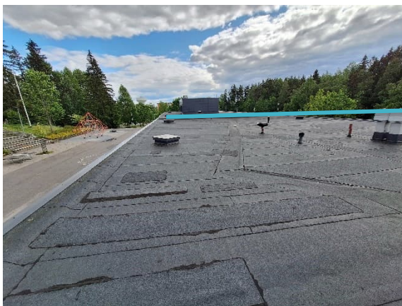
Kuva 99 Yleiskuva A-osan vesikatteesta.
