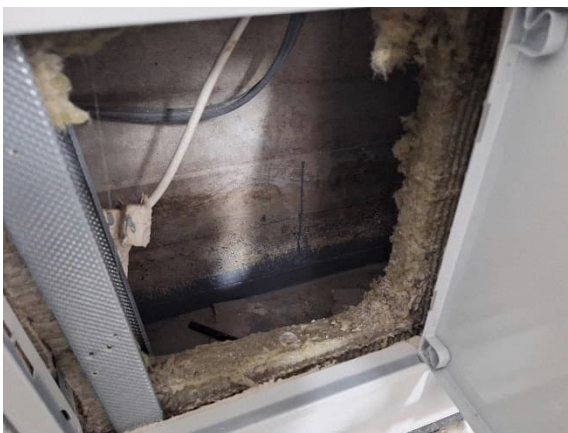
Kuva 91 Musiikkiluokan 101 takakulmassa oli tarkastusluukku maanvastaiseen ulkoseinään.
