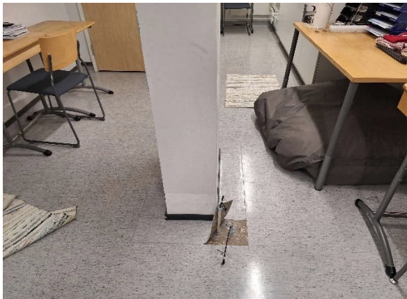
Kuva 44 Porareikien tekokohta tilassa 164.
