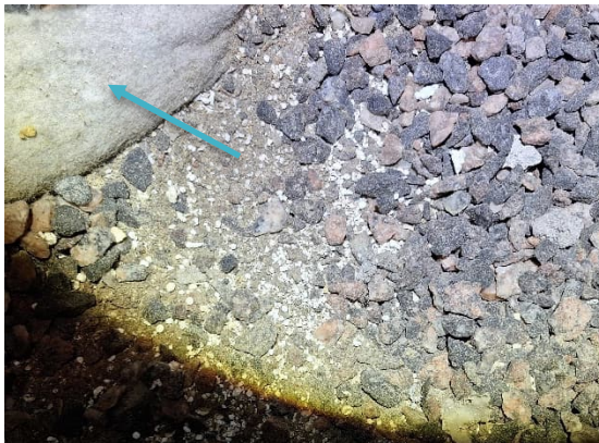
Kuva 66 Salaojamurskeen alla on valkoinen suodatinkangas ja hiekkainen maaperä.
