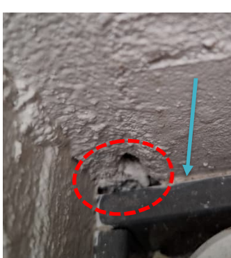
Selvää ilmavuotoa väliseinän kulmauksessa. Kaasu leviää myös lattialistan takana. Väliseinän ja ulkoseinän kulmauksessa on pientä rakoa. Lattialistan päälle on lisätty tiivistysmassaa lyhyelle matkalle (sininen nuoli).
