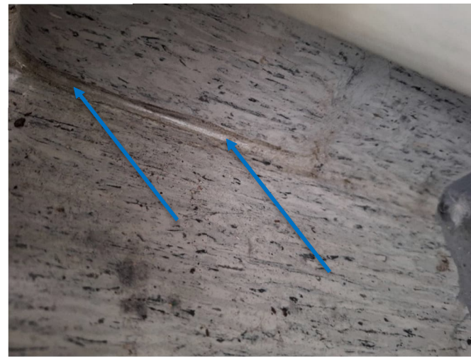
Muovimaton ylösnostoa on myös lisätiivistetty.
