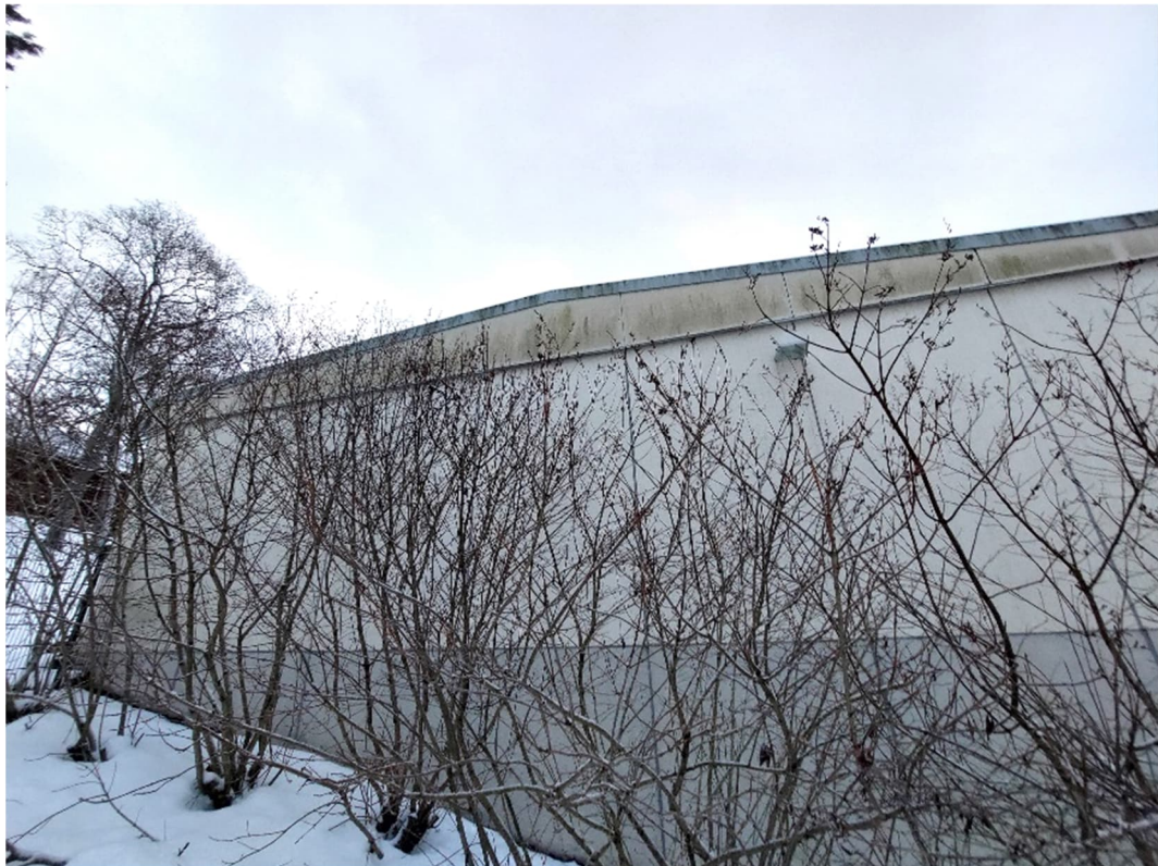
Kuva 3. Pohjoispäädyssä on osittain maanvastaista seinää ja rakennuksen vierellä on kasvillisuutta.
