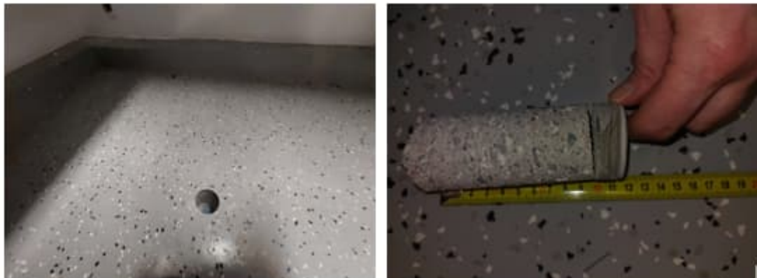
Kuva 19. Rakenneavaus RAK18 tehtiin varaston 008 lattiaan.
