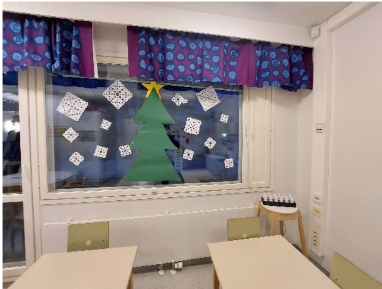
Kuva 44. Ulkoseinien sisäpinnat ovat siistit eikä niissä havaittu poikkeavaa.
