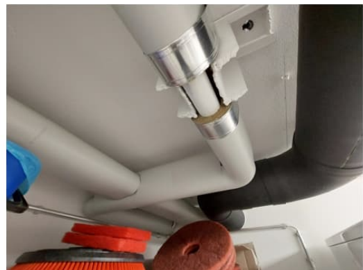
Kuva 29. Siivousskomerossa tila 017 on välipohjan alapinnassa eristettyjä putkia, mutta putkien päät ovat eristämättä ja paljas mineraalivillapinta on näkyvissä.
