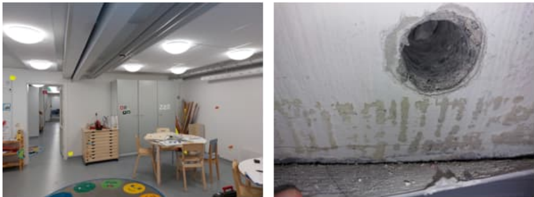
Kuva 22. Alapohjan ja maanvastaisen seinän liittymä tilassa 030.
