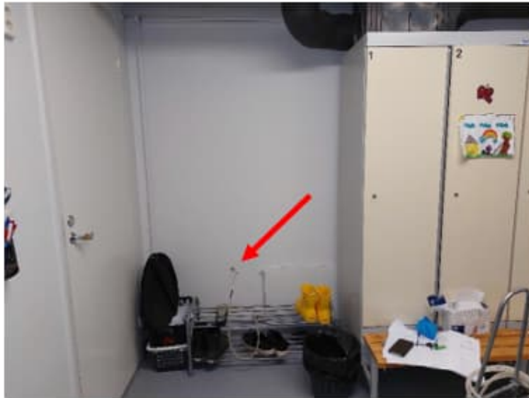
Kuva 23. Maanvastaisen seinän merkkiainekoe tehtiin sosiaalitilaan 021. Merkkiainekokeessa ei havaittu ilmavuotoa rakenneliittymistä.
