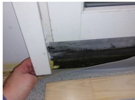
Kuva 48. Tilassa 111 avattiin ikkunalistaa (rakenneavaus RAK7a). Ikkunaliittymien tiivistys oli toteutettu suunnitelmien mukaan. Butyyliteippi oli lähes kauttaaltaan alustassaan kiinni.
