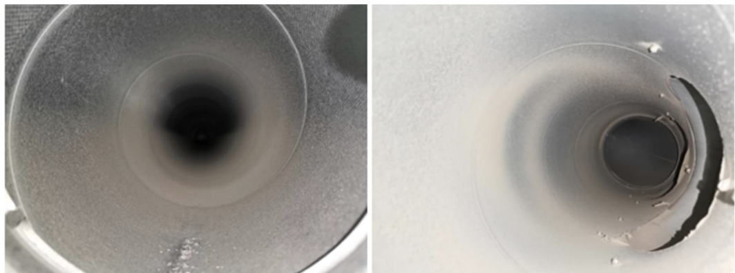
Kuva 76. Yleiskuvat poistoilmakanavien sisältä. Poistoilmakanavissa havaittiin hieman pölykertymää, joka oli paikoin hieman suurempaa kytkentäkanavaosuuksilla. Kuvien pölykertymä on silmämääräisen arvion perusteella pienempi kuin 0,7 \text{ g/m}^2 .
