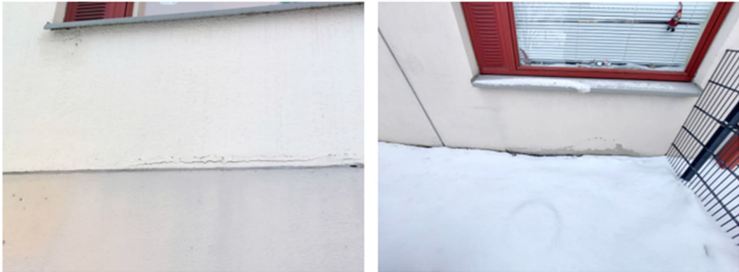
Kuva 42. Länsijulkisivulla toisen ensimmäisen ja toisen kerroksen välisen vaakasauman yläpuolella ja lähellä maanpintaa on pinnoite irtoillut alustastaan.
