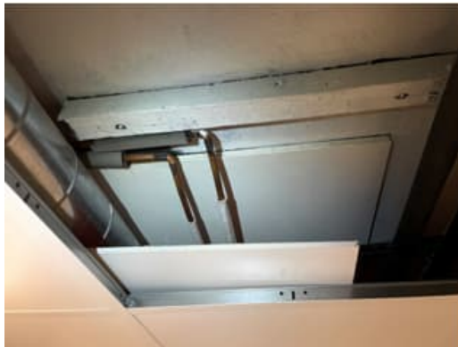
Kuva 34. Tilassa 004 wc:n edustalta avattiin alakattoa. Alakattotilassa havaittiin eristämättömiä tai osittain eristettyjä lämpöputkia.
