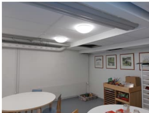
Kuva 35. Tilan 030 alaslasketun katon mineraalivillalevyssä oli vanha kosteusjälki, minkä oli aiheuttanut todennäköisesti yläpuolisten putkien kondensoituminen. Alakattotilassa ei havaittu aktiivista vuotoa.
