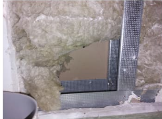
Kuva 61. Rakenneavaus RAK2, tehtiin eteisen ja portaikon väliseen väliseinään keittiön läheisyyteen. Avauksesta havaittiin teräsranan ruuvikiinnityksissä ruostejälkiä, kipsilevyissä ei ollut merkkejä kosteudesta. Eristeenä olevasta mineraalivillasta otettiin materiaalinäyte MAT2 mikrobianalyysiä varten. Näytteessä ei todettu mikrobikasvua.
