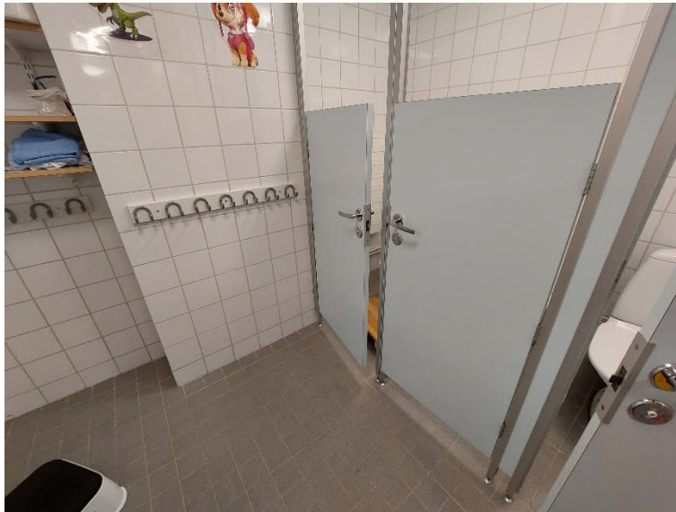
Kuva 28. Märkätilojen pintarakenteet olivat hyväkuntoiset.
