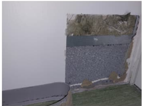
Kuva 60. Rakenneavaus RAK1, tehtiin eteisen ja wc-tilan väliseen väliseinään keittiön oven välittömään läheisyyteen. Avauksesta ei havaittu merkkejä kesällä 2022 tapahtuneesta vesivahingosta. Rakenne oli lähtötietojen väliseinätyypin VS4 mukainen. Eristeenä olevasta mineraalivillasta otettiin materiaalinäyte MAT1 mikrobianalyysiä varten. Näytteessä ei todettu mikrobikasvua.
