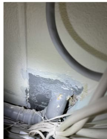
Kuva 29. Siivousskomerossa tila 017 on välipohjan alapinnassa eristettyjä putkia, mutta putkien päät ovat eristämättä ja paljas mineraalivillapinta on näkyvissä.
