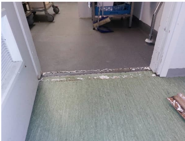
Kuva 27. Vesivahingon jälkeen myös keittiön puolelta uusittiin kitkamattoa noin metrin levyinen kaistale. Kuvassa on irrotettu kosteusvaurioitunut puukynnys.
