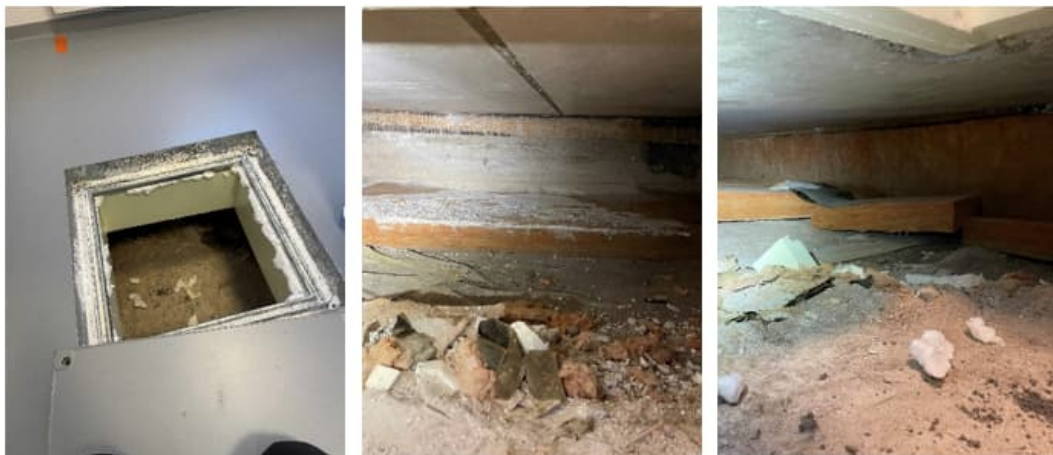
Kuva 15. Alustatilaan pääsee kolmesta kulkuluukusta, joissa on kaasutiiviit kannet. Alustatilassa on lämmöneristeenä mineraalivillalevyjä maapohjan päällä. Alustatila on matalahko ja siellä havaittiin myös jonkin verran rakennusjätettä.
