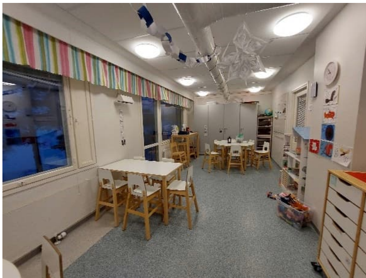
Kuva 25. Välipohjaliittymien tiivistysten yhteydessä ulkoseinän vierellä on uusittu mattoaluetta noin puolen metrin matkalta.
