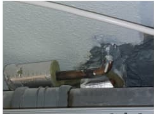
Kuva 33. Tilassa 037 avattiin alakattoa ja tarkastettiin läpivientien tiiveys välipohjaan. Läpiviennit oli tiivistetty, mutta putkieristeissä oli näkyvissä avointa mineraalivillapintaa.
