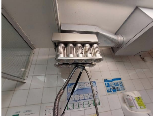
Kuva 72. Yleiskuva keittiön rasvahuuvasta, valmistaja on Jeven. Huuva on hyväkuntoinen ja melko puhdas.
