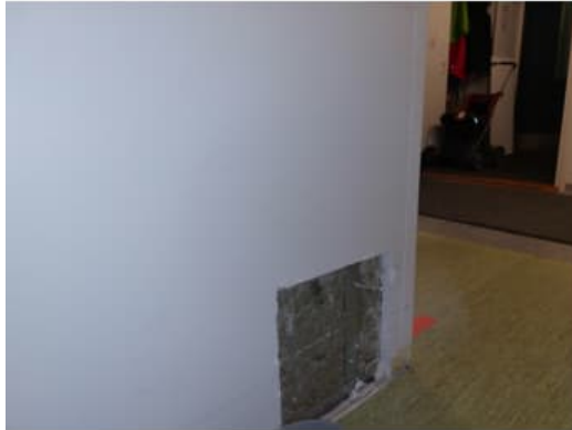
Kuva 61. Rakenneavaus RAK2, tehtiin eteisen ja portaikon väliseen väliseinään keittiön läheisyyteen. Avauksesta havaittiin teräsranan ruuvikiinnityksissä ruostejälkiä, kipsilevyissä ei ollut merkkejä kosteudesta. Eristeenä olevasta mineraalivillasta otettiin materiaalinäyte MAT2 mikrobianalyysiä varten. Näytteessä ei todettu mikrobikasvua.
