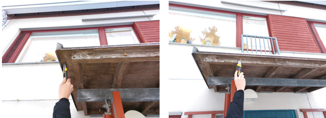
Kuva 65. Sisääntulokatosten vaneriosat olivat jonkin verran pehmenneet. Puuosat olivat kovempia.
