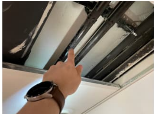
Kuva 34. Tilassa 004 wc:n edustalta avattiin alakattoa. Alakattotilassa havaittiin eristämättömiä tai osittain eristettyjä lämpöputkia.
