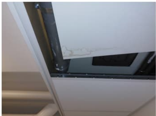
Kuva 35. Tilan 030 alaslasketun katon mineraalivillalevyssä oli vanha kosteusjälki, minkä oli aiheuttanut todennäköisesti yläpuolisten putkien kondensoituminen. Alakattotilassa ei havaittu aktiivista vuotoa.
