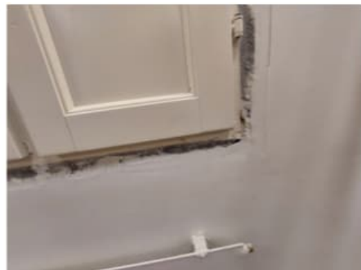
Kuva 48. Tilassa 111 avattiin ikkunalistaa (rakenneavaus RAK7a). Ikkunaliittymien tiivistys oli toteutettu suunnitelmien mukaan. Butyyliteippi oli lähes kauttaaltaan alustassaan kiinni.
