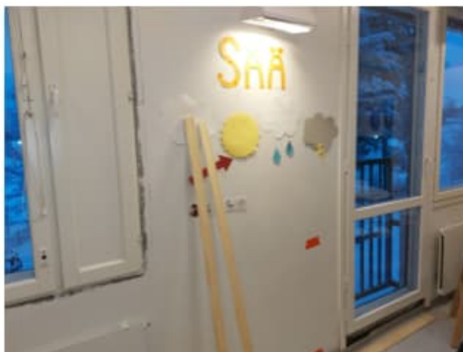
Kuva 48. Tilassa 111 avattiin ikkunalistaa (rakenneavaus RAK7a). Ikkunaliittymien tiivistys oli toteutettu suunnitelmien mukaan. Butyyliteippi oli lähes kauttaaltaan alustassaan kiinni.
