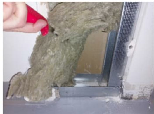
Kuva 62. Rakenneavaus RAK103, tehtiin kellarikerroksen väliseinään portaikon alapäähän, jonne oli valunut vettä keittiön vesivahingossa. Avauksesta ei havaittu poikkeavaa. Väliseinä on yhdistetty portaikon kantavaan väliseinään. Kantavan väliseinän tiivistys oli toteutettu suunnitelmien mukaan. Eristeenä olevasta mineraalivillasta otettiin materiaalinäyte MAT7 mikrobianalyysiä varten. Näytteessä ei todettu mikrobikasvua.
