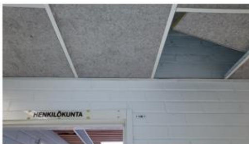
Kuva 46. Käytävillä olevissa alakattotiloissa on runsaasti talotekniikkaa. Alakattotilat ovat pölyisiä. Läpivientejä väliseiniin ei ole tiivistetty.
