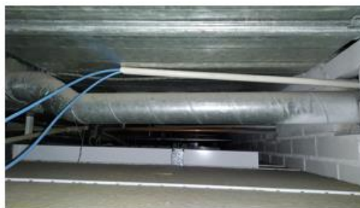
Kuva 46. Käytävillä olevissa alakattotiloissa on runsaasti talotekniikkaa. Alakattotilat ovat pölyisiä. Läpivientejä väliseiniin ei ole tiivistetty.
