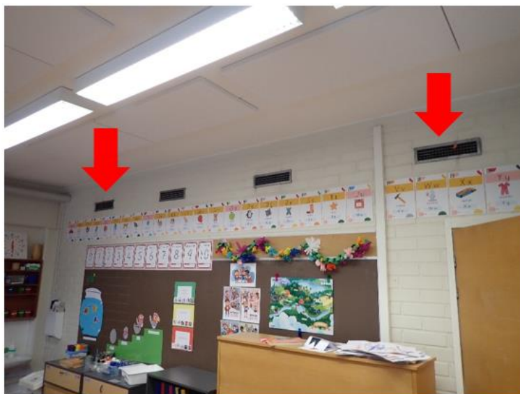
Kuva 70. Yleiskuva luokkatilojen tyypillisestä ilmanjakoratkaisusta ja päätelaitteiden sijoittelusta. Uloimmat päätelaitteet (kuvaan merkittynä punaisilla nuolilla) ovat tuloilmasäleikköjä ja poistoilmasäleiköt sijaitsevat keskellä. Tuloilman päätelaitteiden edessä on virtausesteitä, kuten kattovalaisimia.
