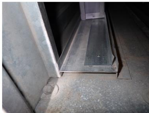
Kuva 63. Tuloilmasuodatin on likainen ja sen suodatusluokka on G4. Suodatin ei tiivisty kunnolla koneen runkoa vasten, sallien ohivirtauksen suodattimen ohi.
