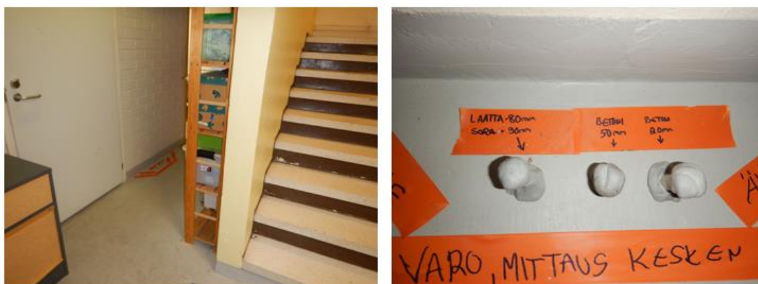
Kuva 26. Porareikämittaus kellarin alapohjarakenteeseen käytävällä 0.05 varaston 0.06 seinän vieressä.
