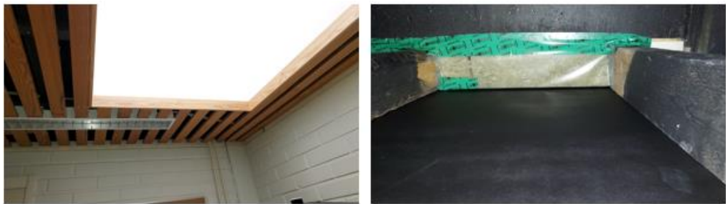
Kuva 40. Sosiaalitulassa 1.38 kattoikkunassa havaittiin vesikaton korjaussuunnitelmien mukainen höyrynsulkumuovi ja -teippi.
