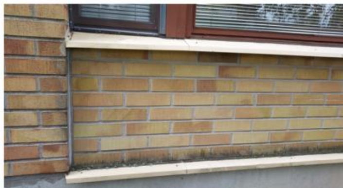
Kuva 33. Julkisivulla tiilipinnassa on etenkin itäjulkisivulla tummumaa. Sokkelin päällä oleva vesipelti on lähes vaakatasossa ja seinän alaosa näiltä kohdin tumma ja seinän sekä pellityksen liitoskohdassa on sammalta, mikä viittaa kosteuden kertymiseen.
