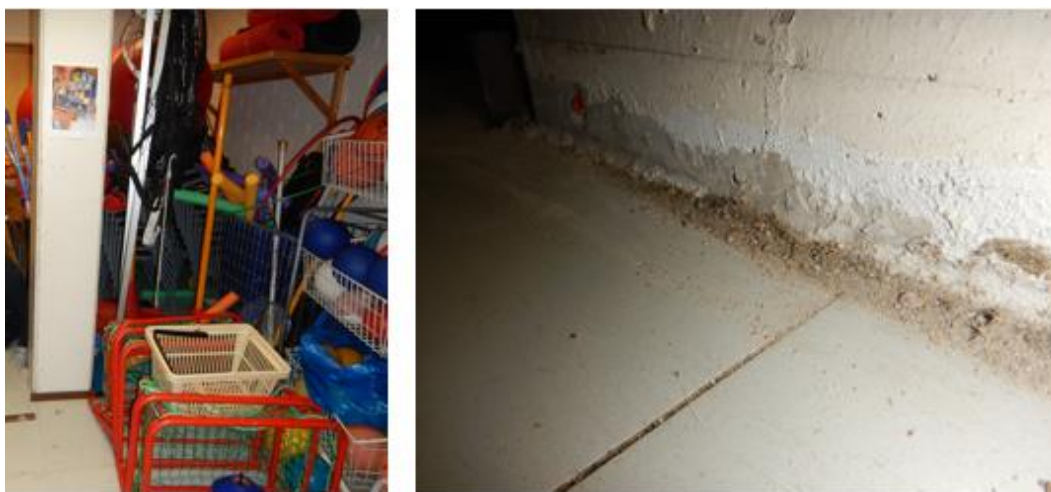
Kuva 15. Liikuntavälinevaraston 1.45 pilarin ja alapohjan välistä liittymää tarkasteltiin aistinvaraisesti. Pilarin ja lattian liittymässä on puiset jalkalistat. Listan takaa ei havaittu tiivistysmateriaaleja, mutta merkkisavulla ja aistinvaraisesti arvioiden liittymä on tiivis.
