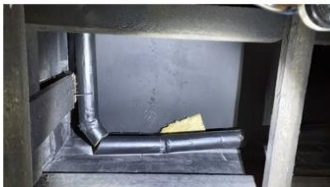
Kuva 44. Pukuhuoneen 1.50 ritiläalakattotilassa oli vähän avointa mineraalivillapintaa.
