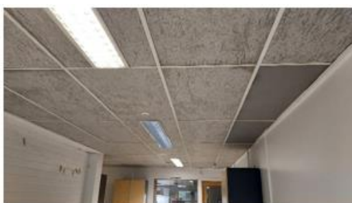
Kuva 45. Käytävien alaslasketun katon akustointilevyt ovat melko nuhjaantuneet. Luokkatiloissa on uudemmat siisti akustointilevyt, jotka on liimattu suoraan ontelolattian alapintaan.
