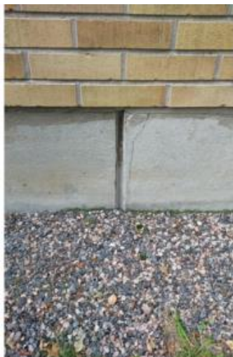
Kuva 33. Julkisivulla tiilipinnassa on etenkin itäjulkisivulla tummumaa. Sokkelin päällä oleva vesipelti on lähes vaakatasossa ja seinän alaosa näiltä kohdin tumma ja seinän sekä pellityksen liitoskohdassa on sammalta, mikä viittaa kosteuden kertymiseen.
