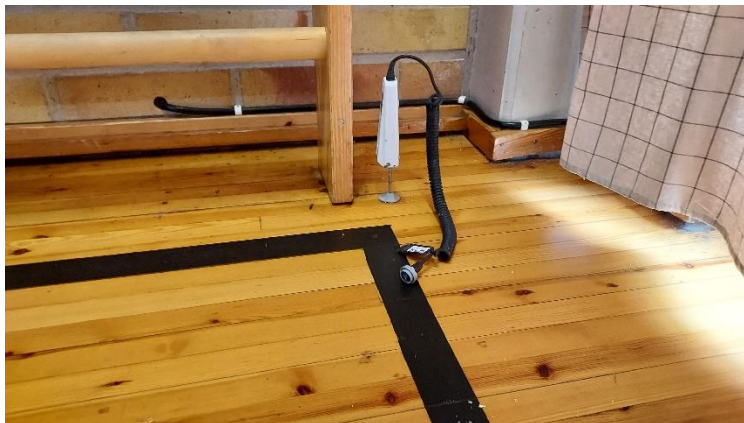
Kuva 24. Eristetilan hetkellinen kosteusmittaus ulkoseinän vierellä liikuntasalin alapohjarakenteesta.
