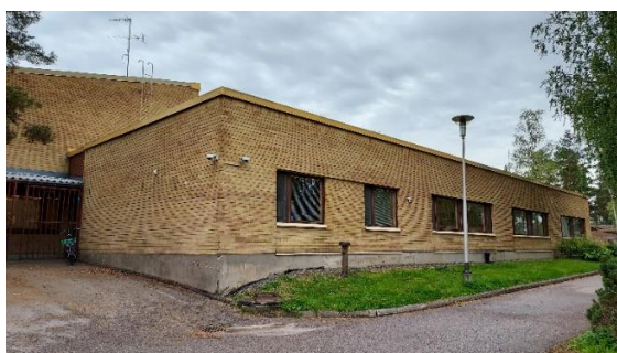
Kuva 7. Itäjulkisivulla sokkelin vierellä on sepelöinti ja kapea viheralue, joka rajoittuu asfaltoituun kulkutiehen. Maanpinta viettää pois päin rakennuksesta.
