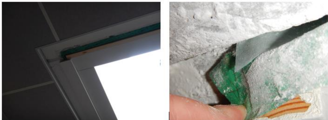
Kuva 41. Tilassa 1.26 kattoikkunan ja yläpohjarakenteen liittymässä havaittiin vesikaton korjaussuunnitelmien mukainen höyrynsulkuteippi ja -muovi. Peitelistan takana muovin limitys rakenteeseen ei ollut täysin tiivis.
