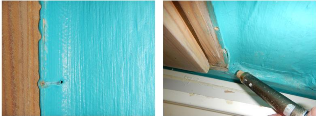
Kuva. Ikkunaliittymistä ja naulan rei'istä todettiin pistemäistä ilmavuotoa.
