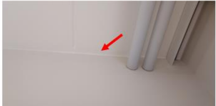
Kuva 32. Seinien ja yläpohjien liittymät sekä ontelolaattojen saumat on tiivistetty liitosnauhalla sekä siveltävällä massalla.
