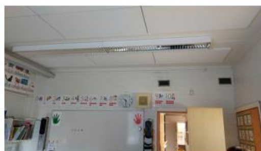
Kuva 45. Käytävien alaslasketun katon akustointilevyt ovat melko nuhjaantuneet. Luokkatiloissa on uudemmat siisti akustointilevyt, jotka on liimattu suoraan ontelolattian alapintaan.
