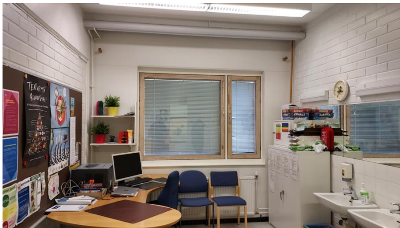
Kuva 28. Ulkoseinien sisäpinnat on pääosin tasoitetut ja maalatut. Väliseinät on maalatut. Seinäpinnat olivat hyväkuntoisia.
