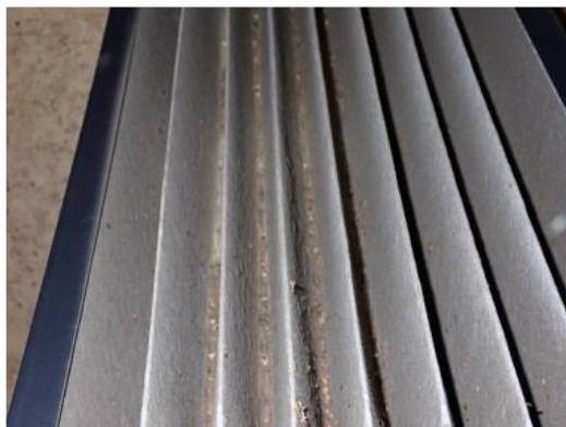
Kuva 63. Tuloilmasuodatin on likainen ja sen suodatusluokka on G4. Suodatin ei tiivisty kunnolla koneen runkoa vasten, sallien ohivirtauksen suodattimen ohi.
