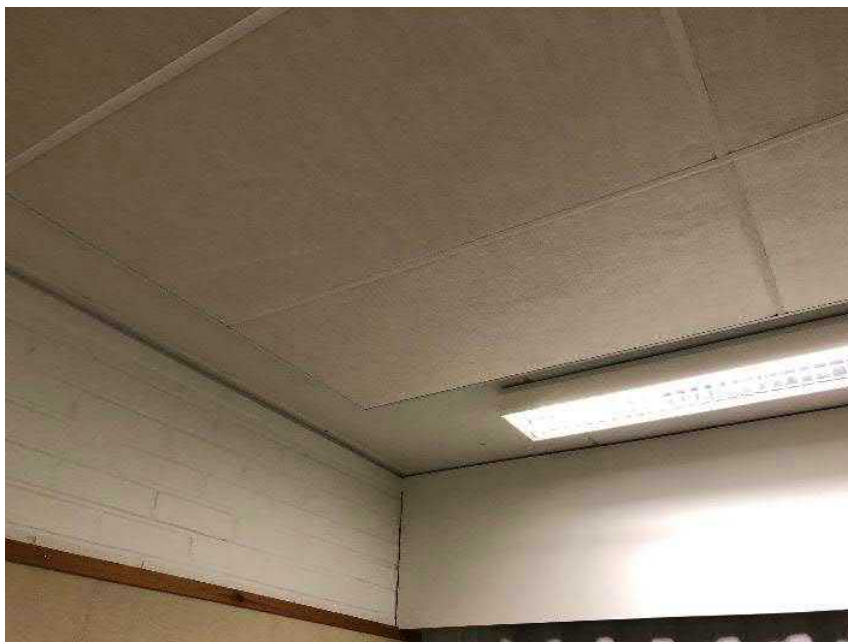
Kuva 32 . Tilassa 33 on vanhat, muista tiloista poikkeavat katon akustiikkalevyt. Levyt ovat tekstiilipintaisia ja niistä epäillään emittoituvan tunkkaista hajua tilaan.
