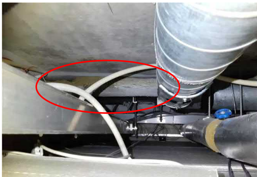
Kuva 37. Alakattorakenteiden yläpuolisessa tilassa havaittiin yhdessä kohdassa pinnoittamaton, vanha mineraalivillalevy. Muuten alakattojen yläpuolella ei havaittu juurikaan huomautettavaa.
