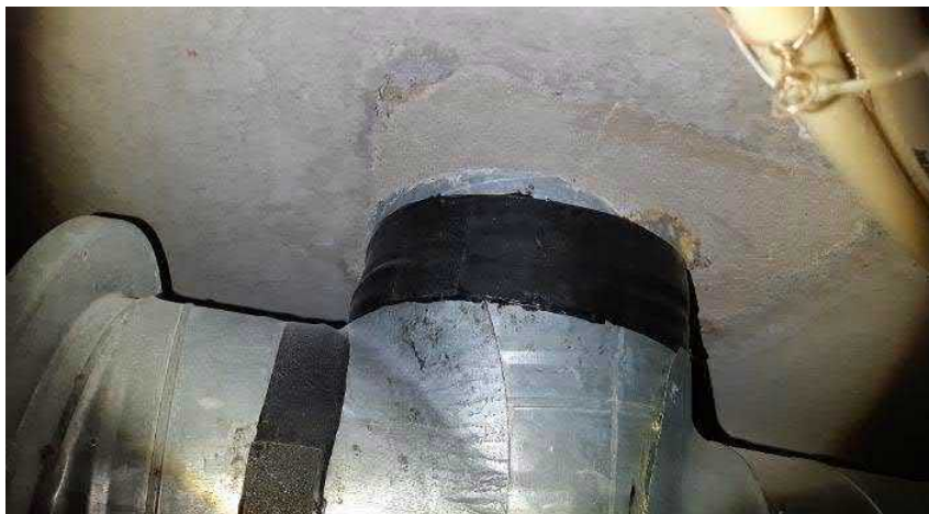
Kuva 50. Yläpohjarakenteessa ei ole kovin paljoa läpivientejä. Ilmanvaihtokanavien läpiviennit on betonoitu ja ne vaikuttivat aistinvaraisesti tiiviiltä.
