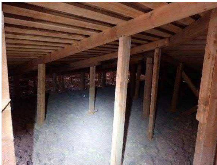
Kuva 40. Yleiskuva yläpohjan eristetilasta. Tila tuulettuu riittävästi. Ku- vassa näkyy räystäiden tuuletusreittinä toimiva harvalaudoitus.
