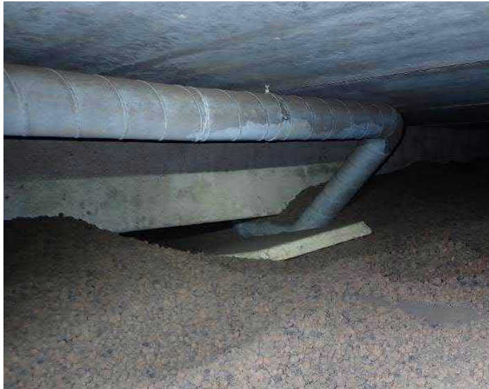
Kuva 10. Ryömintätilaan on asennettu kevytsorapohja. Peruspalkkien alta oli vaikea kulkea eri osastoille.
