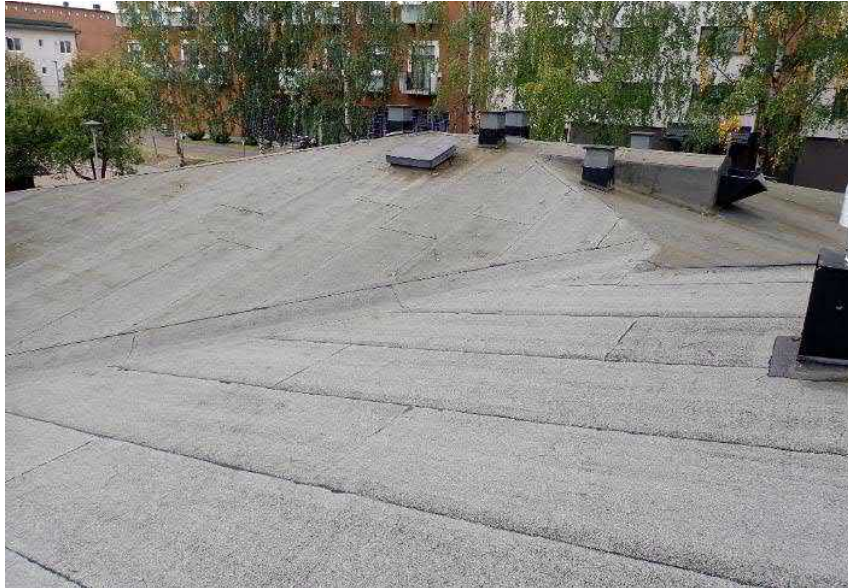
Kuva 39. Yleiskuva vesikatolta. Vesikatteen yleiskunto on välttävä.
