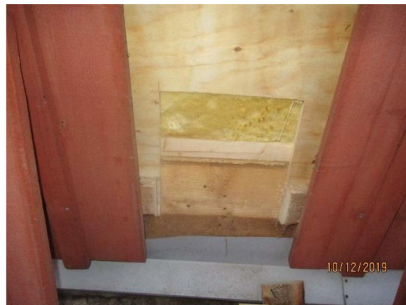
Kuva 6.6. Aistinvaraisten tarkasteluiden perusteella ei ulkoseinärakenteen ulkopinnan vanerin sisä- tai ulkopinnassa havaittu kosteusjälkiä. Rakenteiden pinnoilla ei myöskään havaittu merkittävää määrää ulkotiloissa käsittelemättömille puupinnoille yleisesti muodostuvaa pintahometta tai sinistymää. Kuvassa rakenneavaus (RA.11-US).
