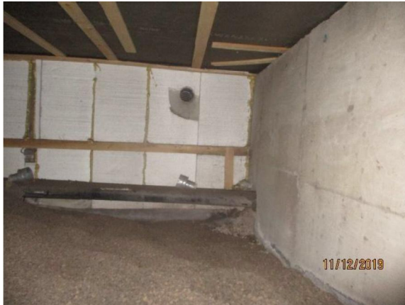
Kuva 5.9. Tarkastusten perusteella on ryömintätilojen kapilaarikatkona käytetty kevytsoraa.
