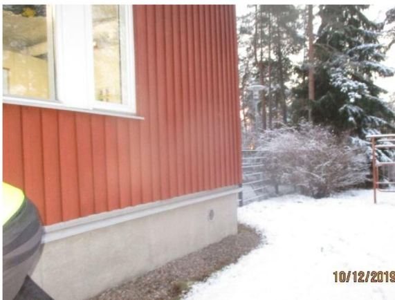
Kuva 4.9. Nurmialueilla on sokkelin viereen tehty reunasorastus rakennuksen pohjoispuolella. Reunasorastuksen paksuus ei ole tiedossa.
