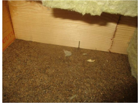
Kuva 5.2. Rakenneavausten yhteydessä suoritettujen aistinvaraisten tarkasteluiden perusteella alapohjarakenteen puuosissa ei havaittu kosteusjälkiä. Kuvassa rakenneavaus (RA.11-AP/US).
