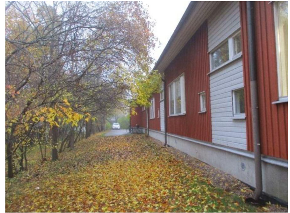
Kuva 4.2. Yleiskuva rakennuksen pohjoisjulkisivusta.
