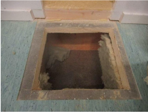
Kuva 5.1. Rakenneavausten yhteydessä suoritettujen aistinvaraisten tarkasteluiden perusteella ei alapohjarakenteen alapohjan bitumikyllästetyn puukuitulevyn yläpinnassa havaittu kosteusjälkiä. Kuvassa rakenneavaus (RA.11-AP/US).
