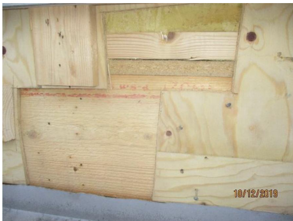
Kuva 6.5. Aistinvaraisten tarkasteluiden perusteella ei ulkoseinärakenteen ulkopinnan vanerin sisä- tai ulkopinnassa havaittu kosteusjälkiä. Rakenteiden pinnoilla ei myöskään havaittu merkittävää määrää ulkotiloissa käsittelemättömille puupinnoille yleisesti muodostuvaa pintahometta tai sinistymää. Kuvassa rakenneavaus (RA.04-US).
