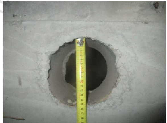
Kuva 5.16. Rakennuksen A- ja B-osan ryömintätilat ovat jaettu kolmeen rakennuksen pituussuuntaisesti jaettuun lohkoon. Lohkojen välisiin perusmuureihin on tehty noin 3 metrin välein tuuletusaukot ( \varnothing 150 mm). Tuuletusaukkojen lisäksi pääsevät lohkot tuulettumaan perusmuureihin tehtyjen kulkuaukkojen kautta.
