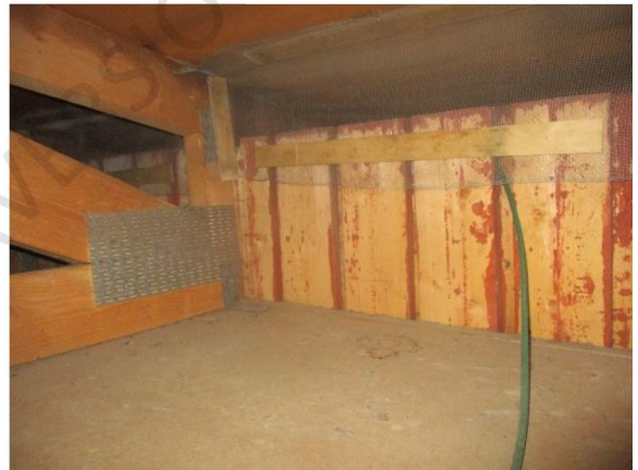
Kuva 7.6. Yläpohjantuuletus on toteutettu sivuräystäiden alapinnan laudoituksen kautta.
