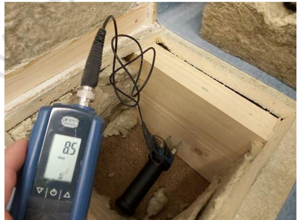
Kuva 5.8. Rakennusneuvoston yhteydessä tehtyjen piikkimittausten perusteella alapohjarakenteen puupalkeissa ei esiintynyt kohonneita kosteutta.
