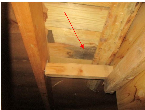
Kuva 7.7 Ruodelaudoituksessa kosteusjälkiä.
