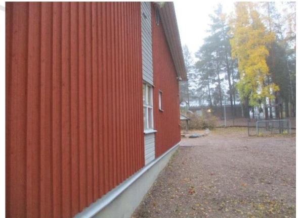
Kuva 4.4. Yleiskuva rakennuksen länsipäädyestä.
