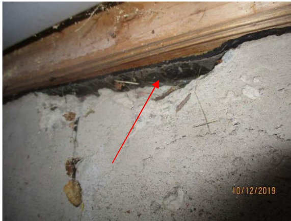
Kuva 6.1. Sokkelirakenteen ja ulkoseinän alaohjauspuun välissä bitumihuopakaista (RA.04-US).
