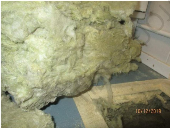
Kuva 5.3. Rakenneavausten yhteydessä suoritettujen aistinvaraisten tarkasteluiden perusteella alapohjarakenteen lämmöneristeessä ei yleisesti havaittu tummentumia lukuun ottamatta henkilöstötilan rakenneavausta. Kuvassa rakenneavaus (RA.06-AP).
