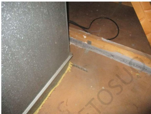
Kuva 7.11. Uretaanilla tiivistetty ilmanvaihtohormi.
