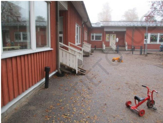
Kuva 4.3. Yleiskuva rakennuksen sisäpihalta.
