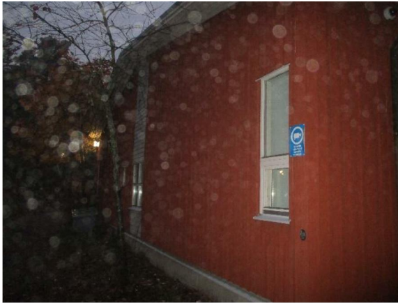
Kuva 4.1. Yleiskuva rakennuksen eteläpäädyestä. Julkisivuverhouksena on käytetty pääosin lomalautaa.
