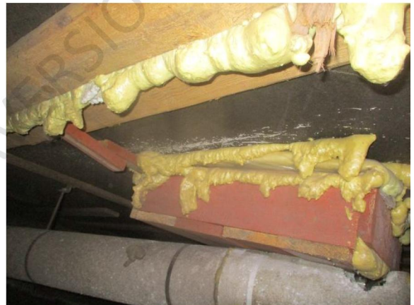
Kuva 5.20. Märkäeteiseen hiekanerotuskaivojen asennuksen seurauksena alapohjarakenteeseen syntyneiden aukkojen paikkaus on suoritettu uretaanivaahdolla.
