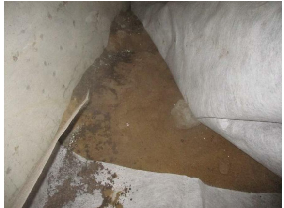
Kuva 5.10. Silmämääräisten havaintojen perusteella on kapilaarikatkon alapuolisena täyttönä käytetty hiekkaa, joka on erotettu kevytsorasta suodatinkankaalla
