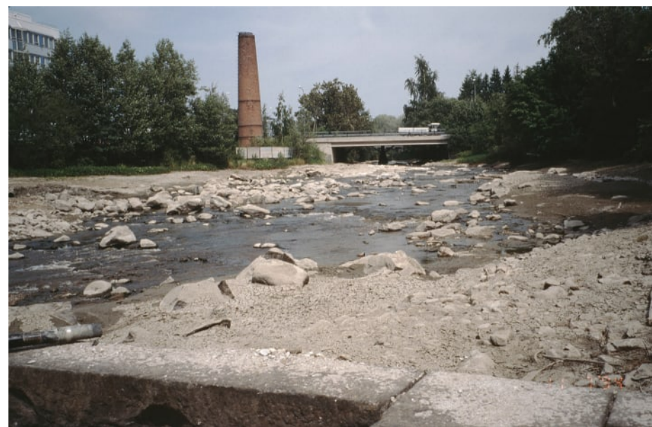
Kuva 13. Heinäkuussa 1994 patoallas oli tyhjennetty kalaportaan rakentamisen ajaksi. Patoaltaan pohjalla on paljon kiviainesta ja kalliota.
